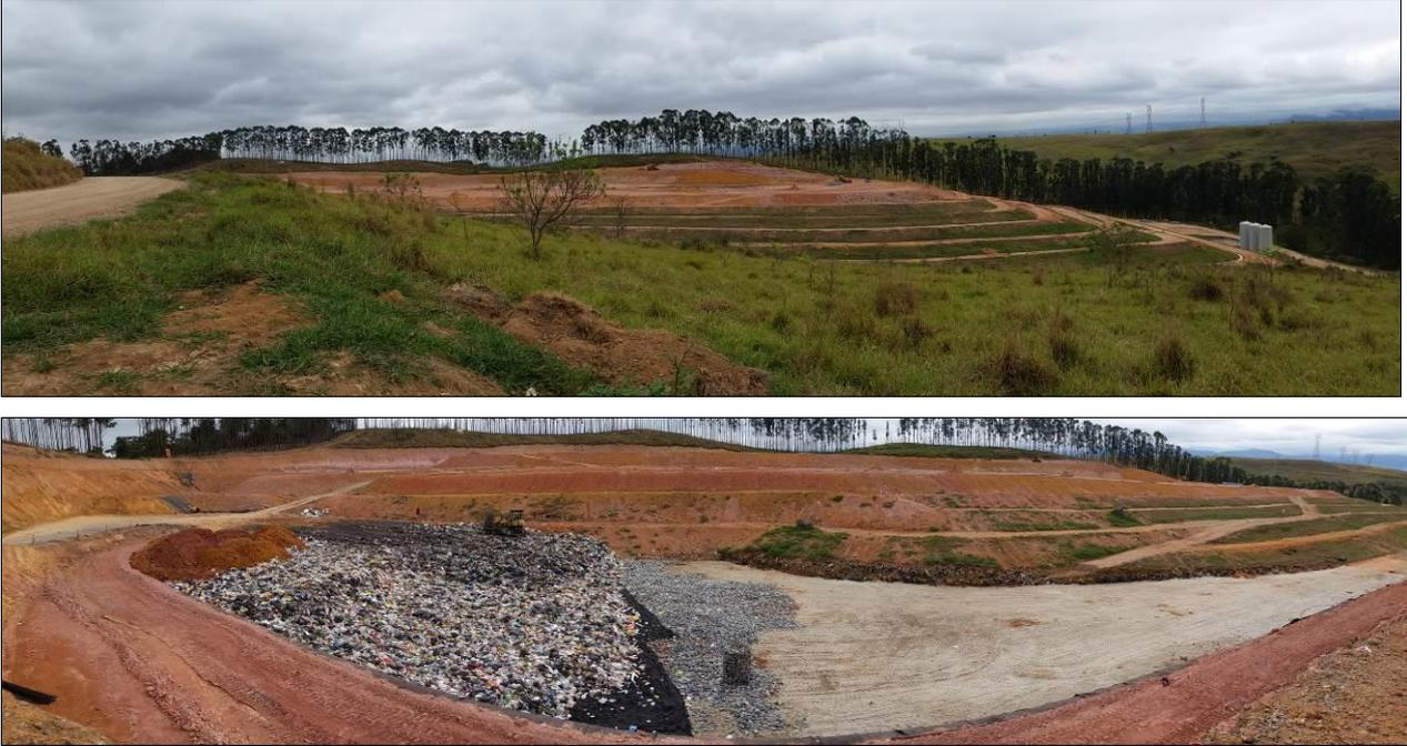
**Figura 43: Resíduos sendo compactados na célula em operação.**
