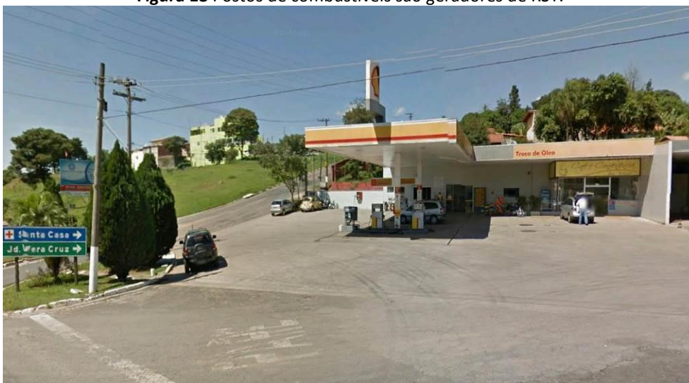
Figura 18 Postos de combustíveis são geradores de RST.
