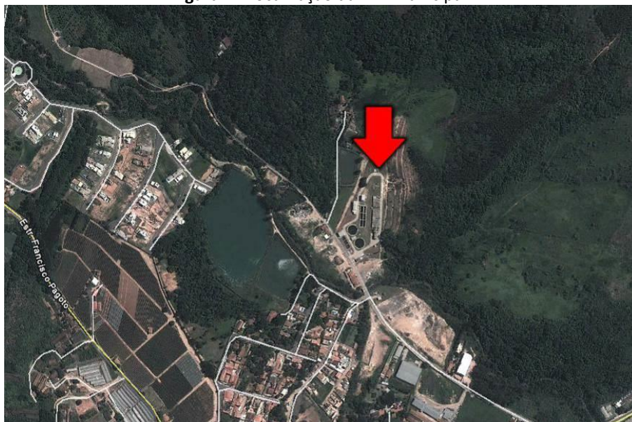
Figura 21 Localização da ETE Municipal.
