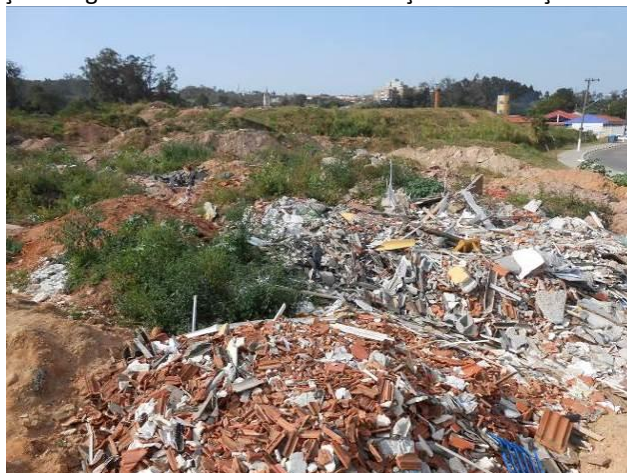
Fotos 18 e 19 Vista geral da área e problemas de disposição irregular dos resíduos de construção e demolição.
