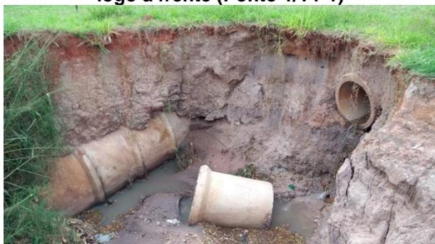
**Foto 3.7 – Galeria de águas pluviais quebrada a céu aberto, após o término da R. Odila Nunes Soares, contribuindo para o processo de assoreamento do Córrego do Matadouro logo à frente (Ponto 2/T1-2)**
