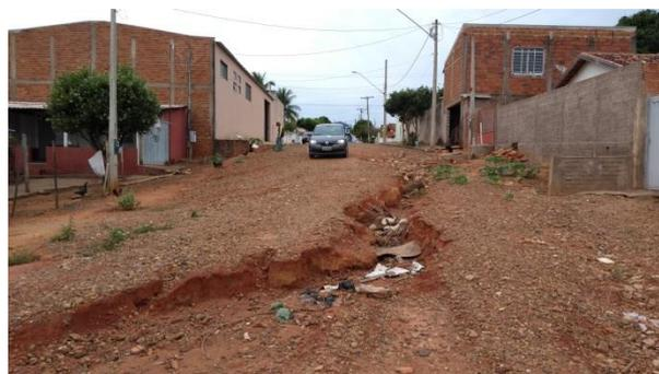
**Foto 3.14 – Falta de pavimentação e equipamentos de drenagem, bem como o escoamento superficial excessivo contribuem para a erosão, carreamento do solo e assoreamento do córrego do matadouro após o término da R. Odila Nunes Soares**
