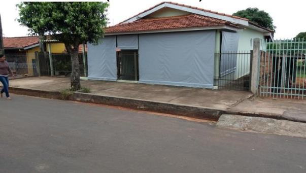
Foto 3.11 – Rampa de acesso para garagem obstruindo sarjeta em região de escoamento superficial excessivo na R. Euclides da Cunha (Ponto 7/T6-2)
