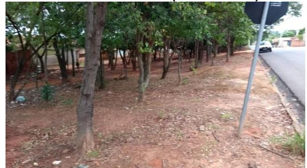
Foto 3.12 – Ausência de equipamentos de drenagem, declividade e o escoamento superficial excessivo ocasionam alagamento das residências adjacentes à área verde da R. Valdomiro Pazin (Ponto 8/T9-1)
