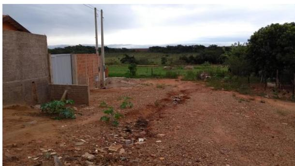
**Foto 3.5 – Ausência de equipamentos de microdrenagem e pavimentação na R. Odila Nunes Soares, possibilitando o carreamento de solo e assoreamento do córrego do matadouro logo à frente (Ponto 1/T1-1)**
