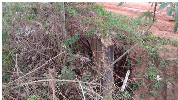
**Foto 3.8 – Galeria de águas pluviais obstruída pela vegetação na travessia da R. Manganez**
