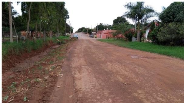
**Foto 3.15 – Ausência de equipamentos de drenagem e pavimentação na R. Manganez (Ponto 4/T4)**
