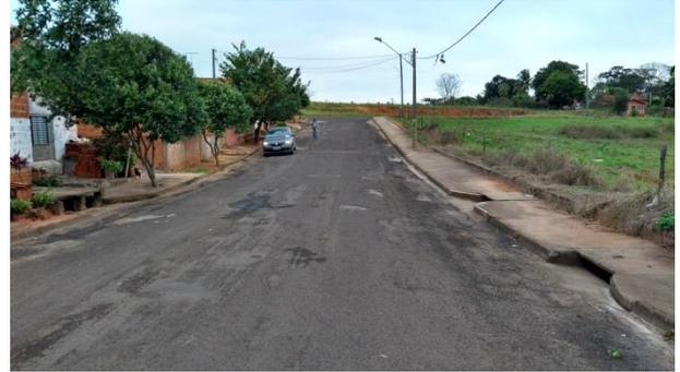
Foto 3.10 – Ponto baixo com equipamentos de drenagem de capacidade insuficientes na R. Euclides da Cunha (Ponto 6/T6-4)
