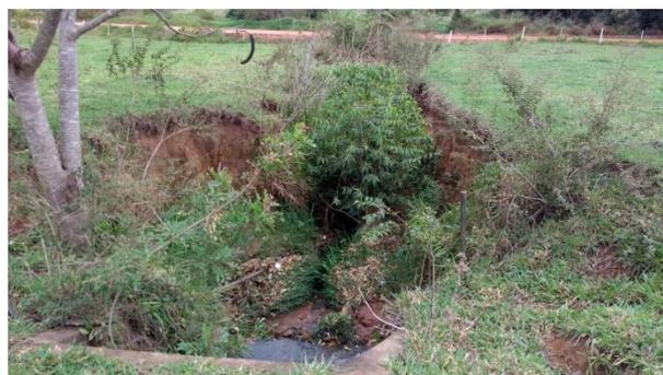
**Foto 3.6 – Saída de bueiro e galeria de águas pluviais obstruídas pela vegetação do terreno à frente do término da R. Odila Nunes Soares**
