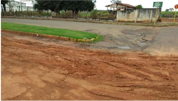
Foto 3.9 – Ausência de limpeza e manutenção das sarjetas e sarjetões na Av. Luís Cavaiar (Ponto 5/T11-2)
