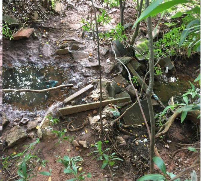
Foto 3.15 – Dissipador não finalizado e destruído
