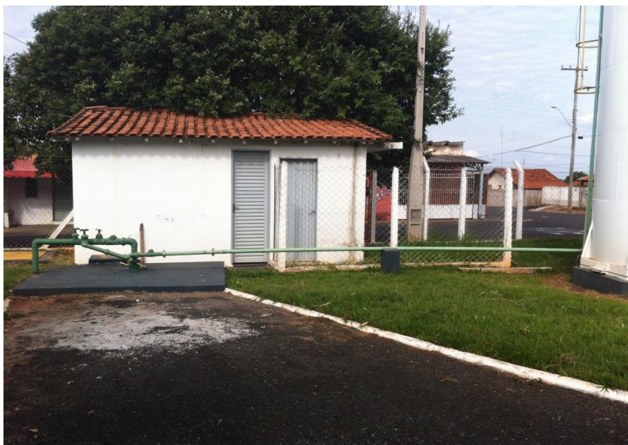
Figura 19. Foto do poço 7
