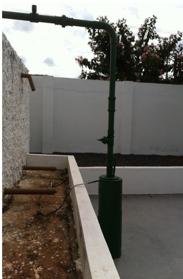
Figura 14. Foto do poço 1
