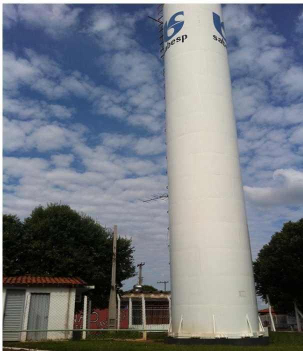
Figura 20. Foto do reservatório acoplado ao poço 7
