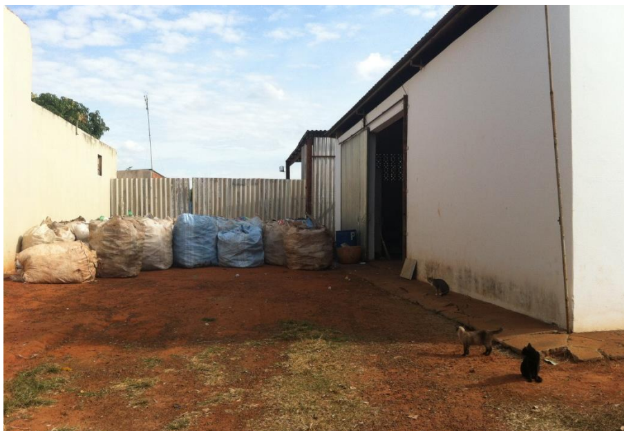
Figura 62. Galpão da central de triagem
