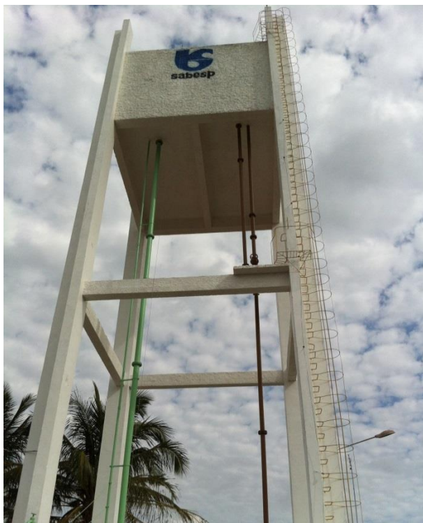
Figura 15. Foto do reservatório elevado do poço 1
