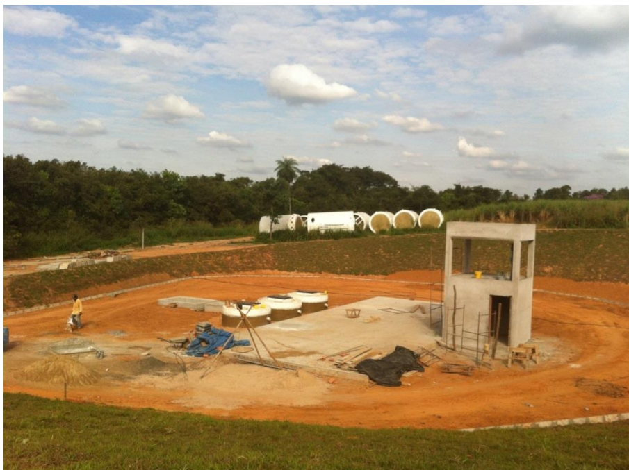
Figura 46. Foto da construção da nova lagoa
