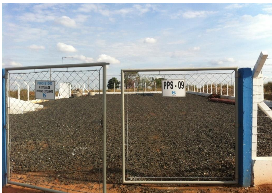
Figura 23. Foto do poço 9
