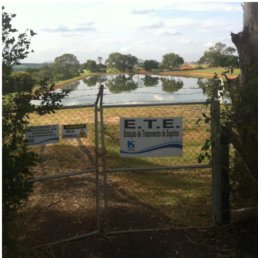
Figura 33. Estação de Tratamento de Esgoto
