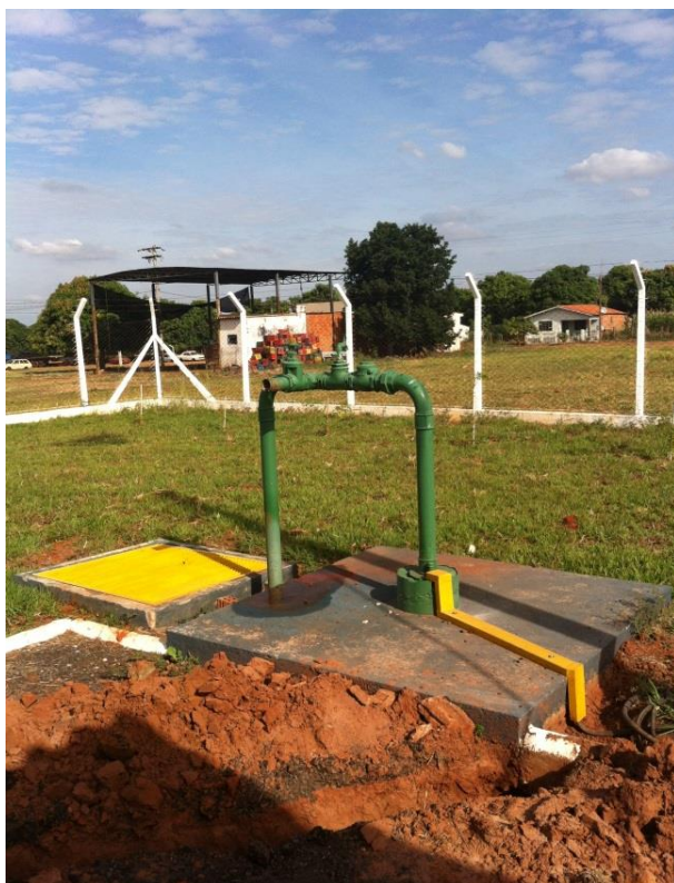
Figura 21. Foto do poço 8
