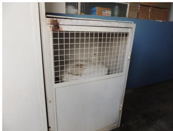
Unidade Programa de Saúde da Família Jardim Vitória– armazenamento externo de resíduos do grupo A.
