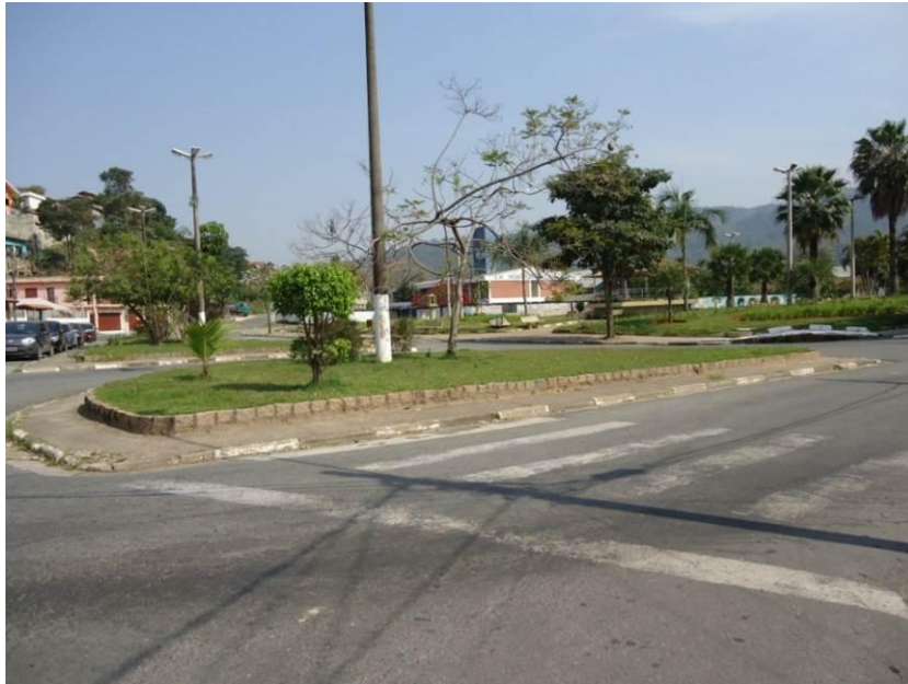
Figura 7 – Ponto de alagamento na Rua Fernão Lopes Fonte: SHS, 2011.
