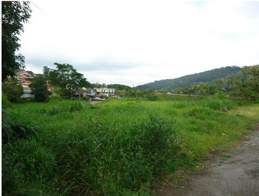
Figura 9 – Ponto de alagamento na Rua João Antonio da Silva, próximo à SABESP. Fonte: SHS, 2011.
