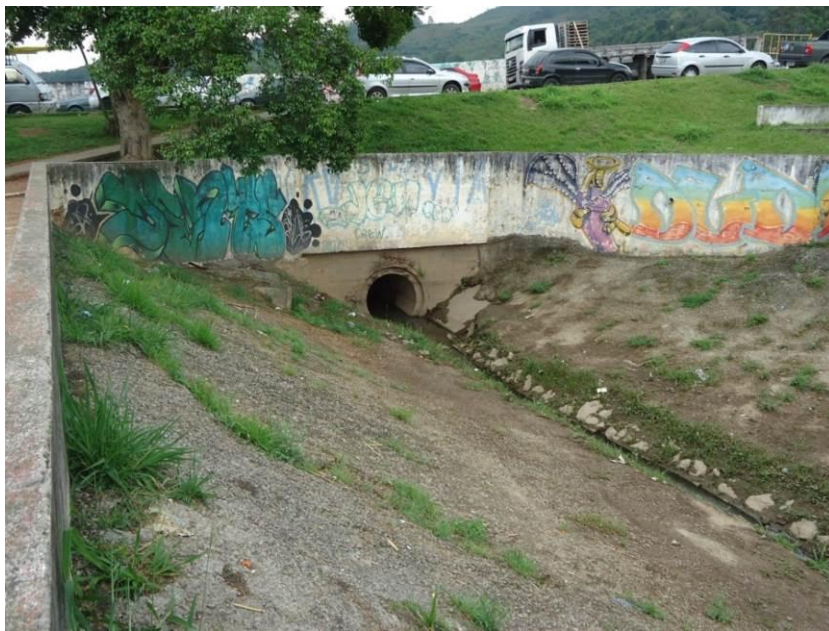
Figura 21 – Ponto de estrangulamento (passagem sob a Av. Antonio Oliveira). Fonte: SHS, 2011.
