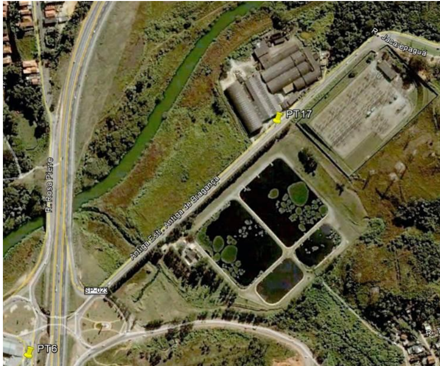
Figura 38 – Localização do ponto de alagamento na rua Nair Hanickel Romaro
