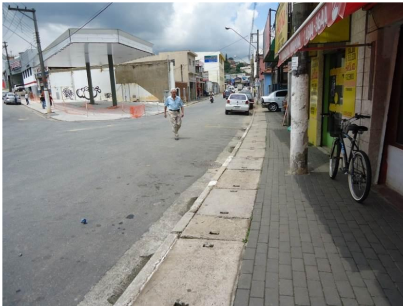
Figura 17 – Ponto de alagamento na esquina da Av. Tabelião Passarella e a Rua Padre Vairo. Fonte: SHS, 2011.
