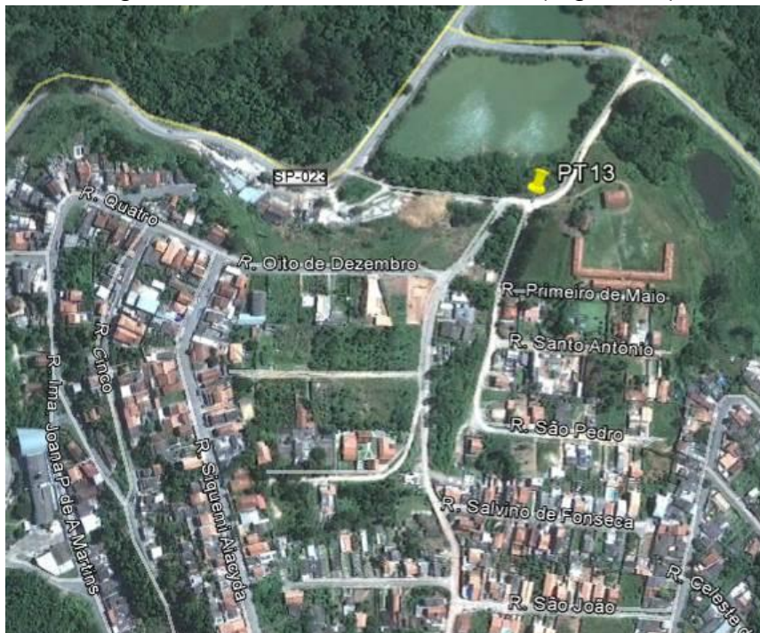
Figura 30 – Localização do ponto de alagamento na rua Vinte e cinco de dezembro
