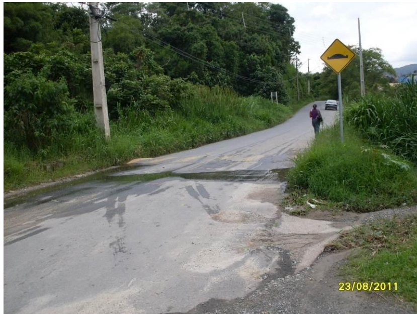
Figura 25 – Avenida João Antonio Brilha, ponto da travessia sobre o córrego sem nome. Fonte: SHS, 2011.
