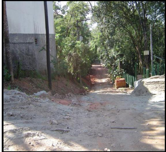
**Foto 06 sem pavimento com manutenção feita com entulho, Pq Petrópolis.**
