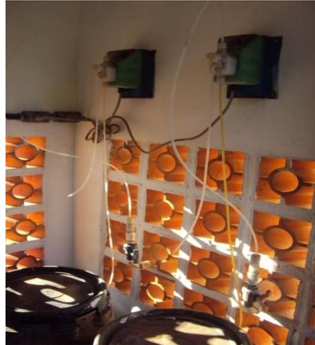
Figura 37 – Dosadores de Cl<sup>-</sup> e F<sup>-</sup> do reservatório Nosso Teto.
