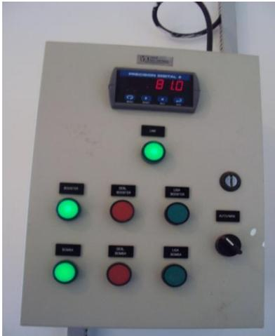
Figura 36 – Painel do controle via rádio do reserv. Nosso Teto.
