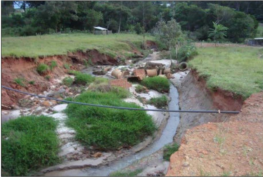
Figura 67 – Erosão e assoreamento de córrego.
