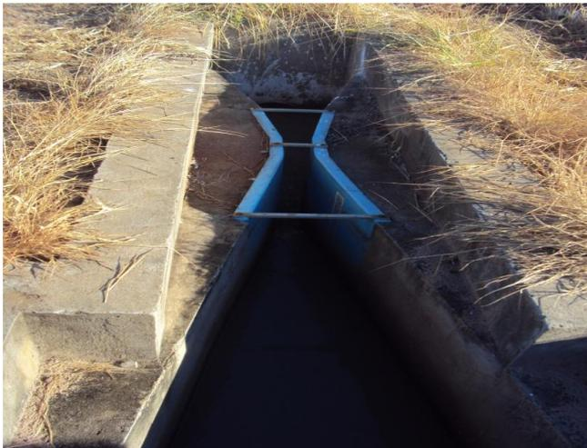
Figura 58 – Medidor de vazão tipo calha Parshall.
