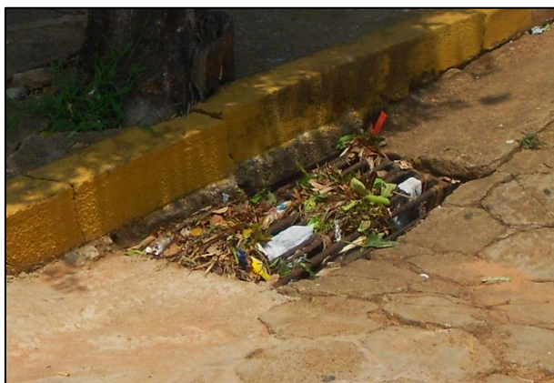
Figuras 60 e 61 - Resíduos impedindo a captação correta da água pluvial pelas “bocas de lobo”. (Avenida Álvaro Coelho)
