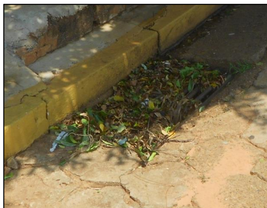
Figuras 60 e 61 - Resíduos impedindo a captação correta da água pluvial pelas “bocas de lobo”. (Avenida Álvaro Coelho)
