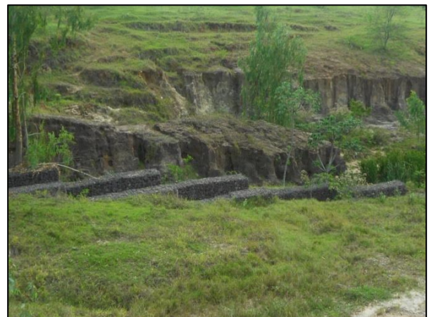
Figuras 64 e 65 – Estrutura de dissipação e erosão (final das Ruas Acácia e Carlos Campos).
