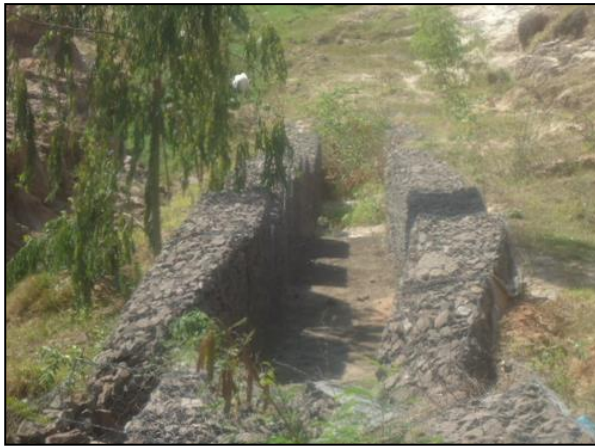
Figuras 62 e 63 – Estrutura de dissipação e erosão (final das Ruas Acácia e Carlos Campos).
