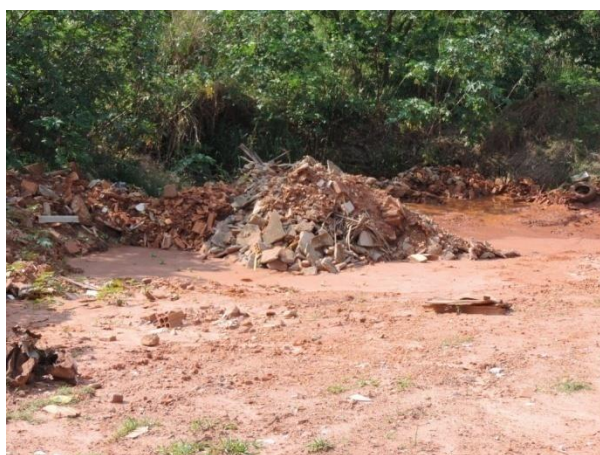
Figura 50 - Local de depósito de RCC Fonte: PROJEC.
