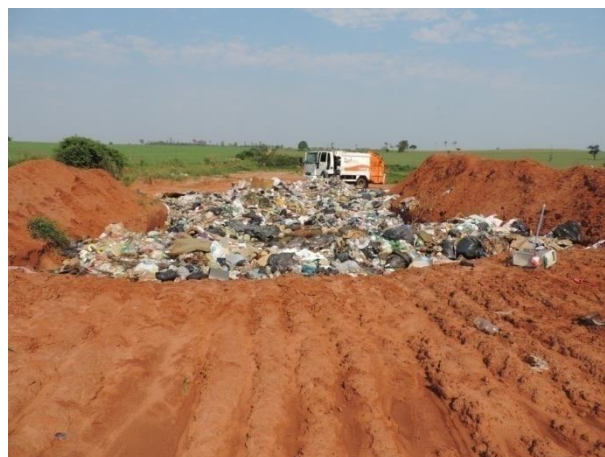
Figura 35 - Vala aberta e lixo depositado durante duas semanas sem cobertura
