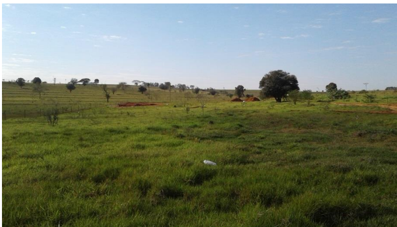
Figura 36 – Vista da nova área com solo removido para abertura de vala Fonte: PROJEC
