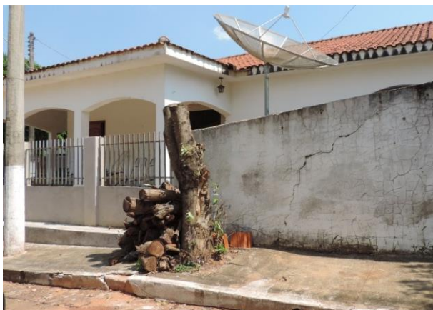
Figura 43 - Acondicionamento de tronco Fonte: PROJEC.
