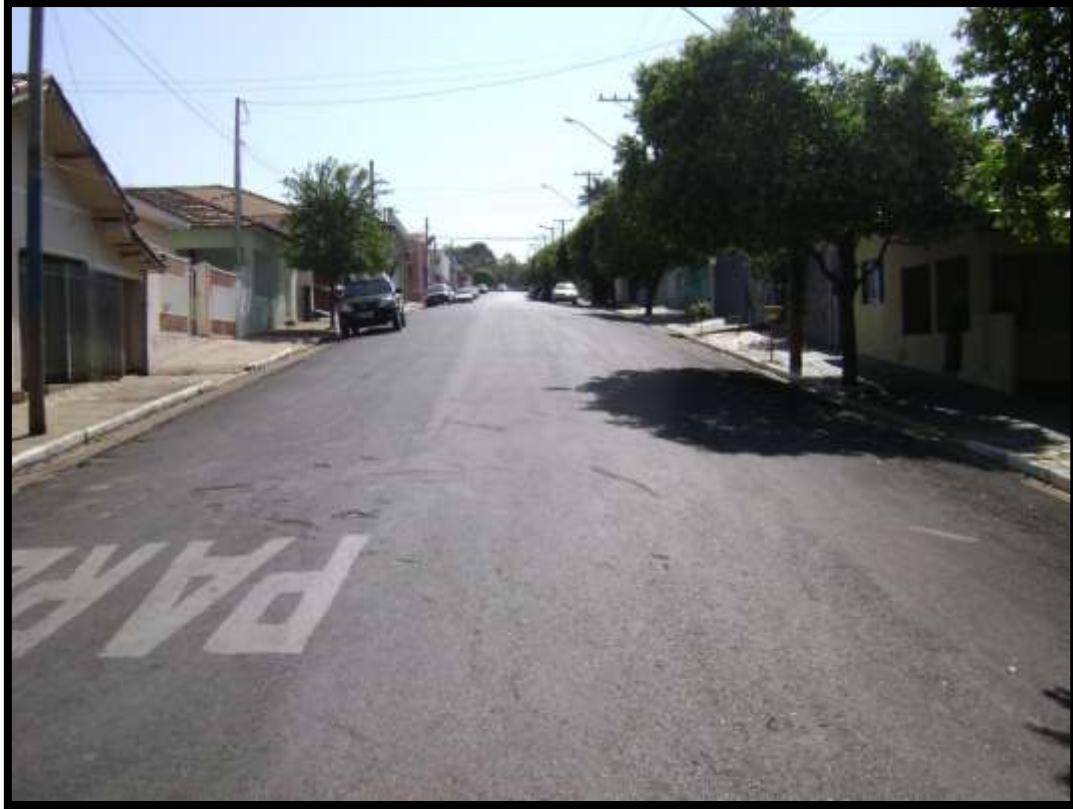
Figura 32 - Vista da Rua 1 de Maio, à montante do ponto de inundação
