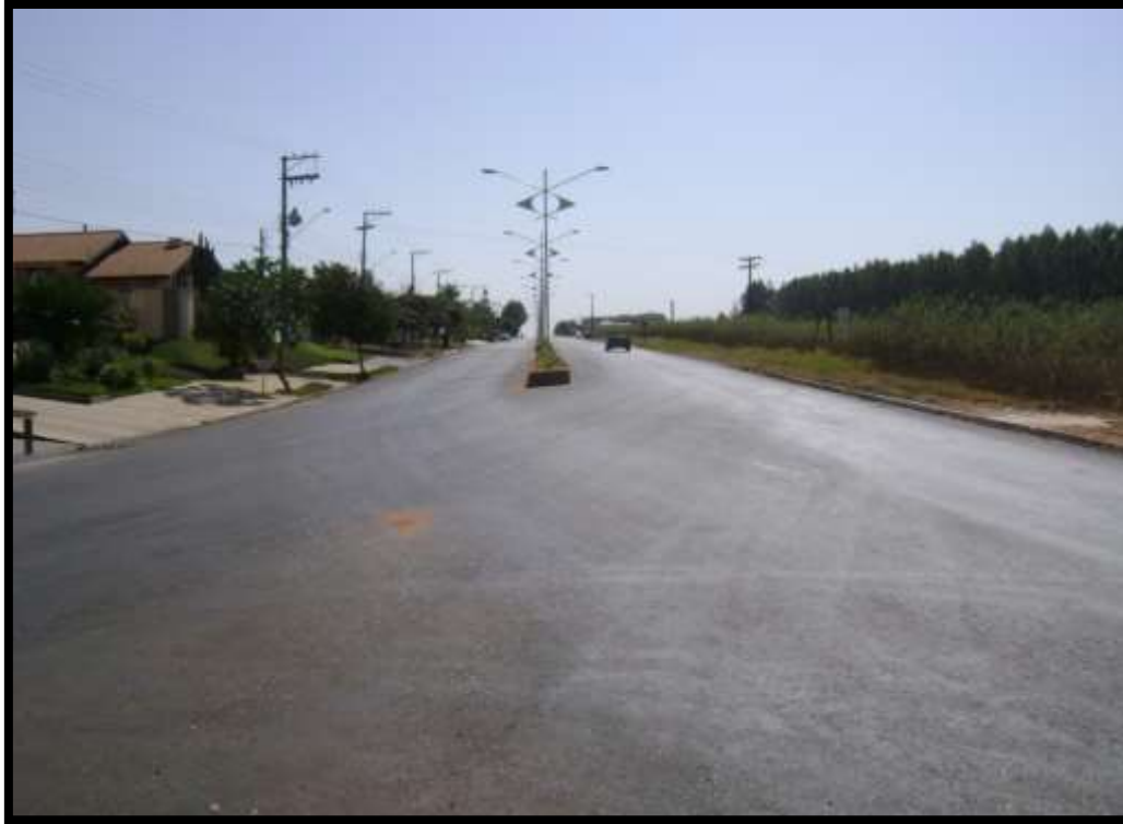
Figura 39 - Vista da Avenida Antonio Rotta, à montante
