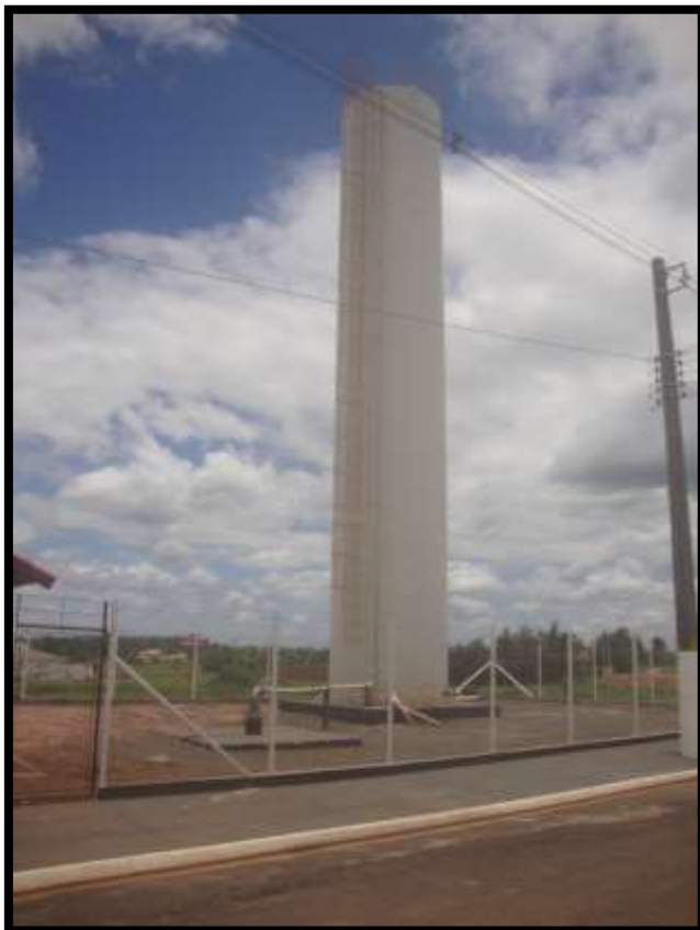
Figura 12 - Reservatório do sistema 5
