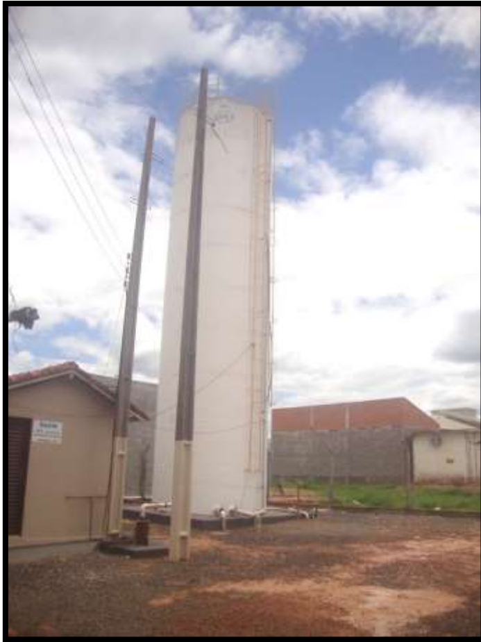
Figura 9 - Reservatório do sistema 2
