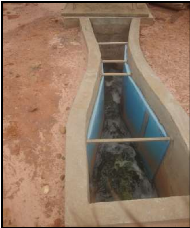
Figura 14 - Medidor de vazão
