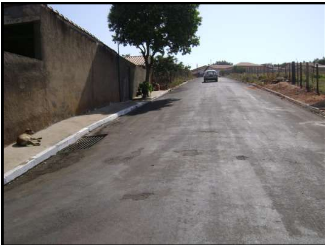
Figura 30 - Vista da Rua 21 de Abril, à montante do cruzamento com a Rua Sta. Terezinha
