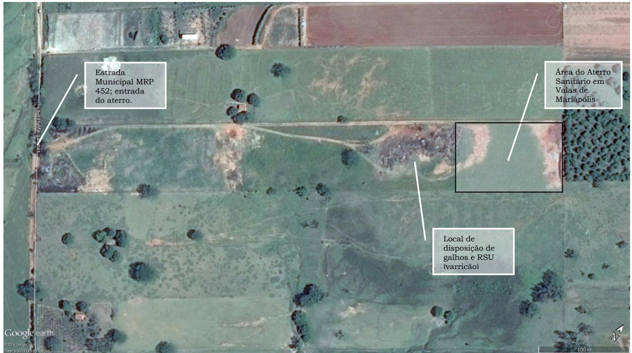
Imagem 15 – vista aérea da instalação do aterro sanitário em valas de Mariápolis.
