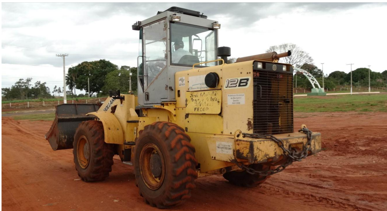
Imagem 19: pá-carregadeira utilizada no aterro em valas.
