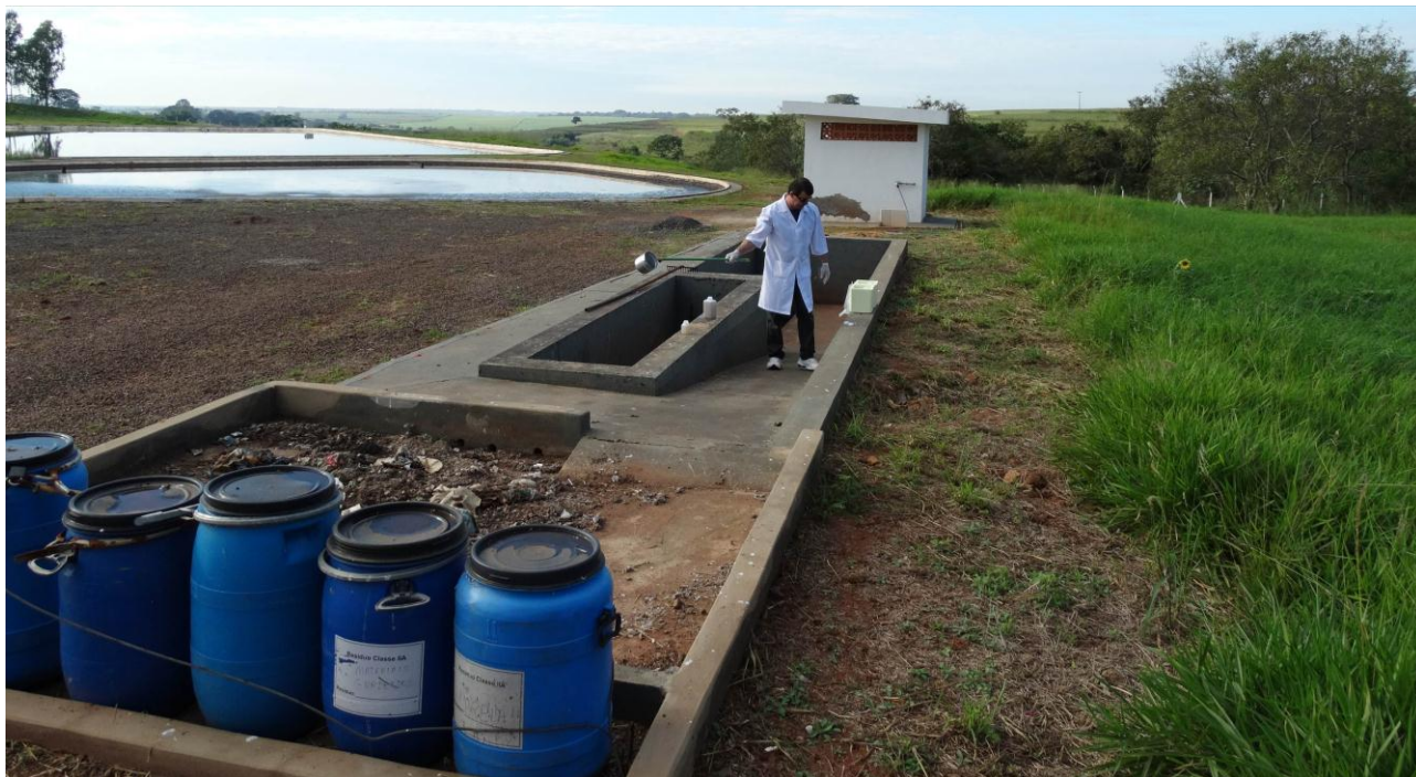
Imagem 41 – tambores para disposição temporária dos resíduos da ETE – lodo.
