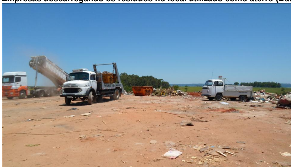
Figura 69: Empresas descarregando os resíduos no local utilizado como aterro (Data: 12/2013).
