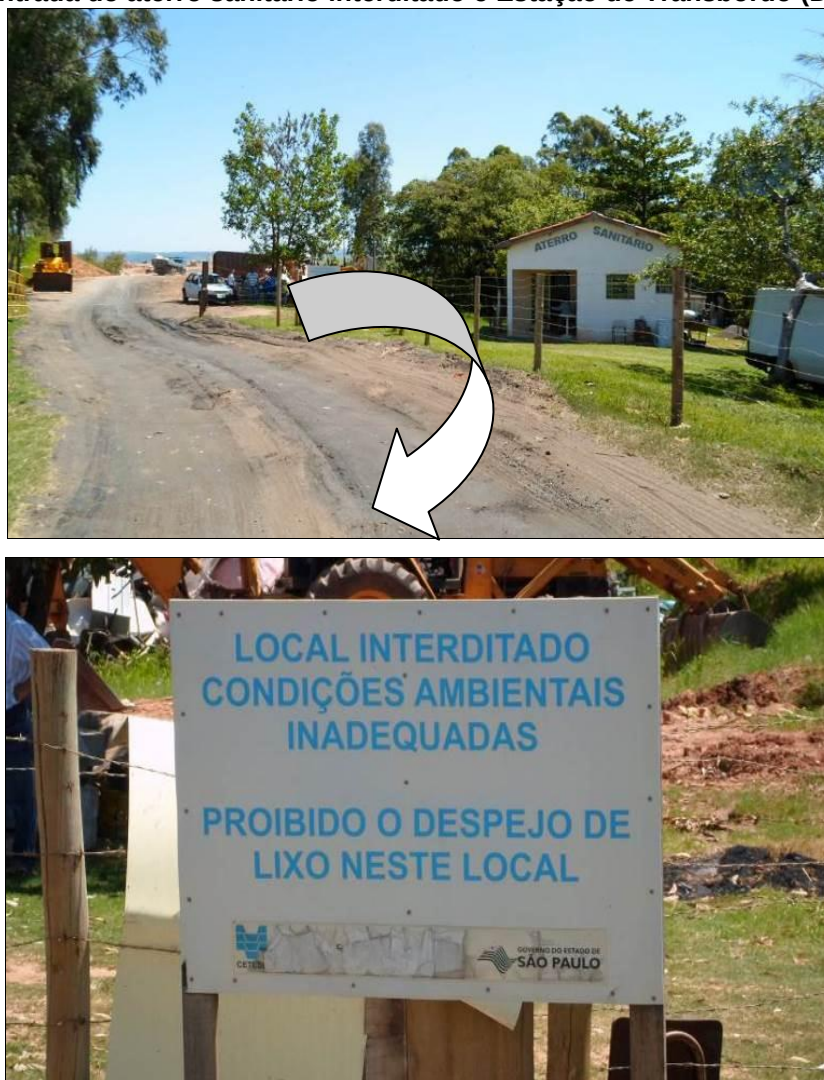
Figura 26: Entrada do aterro sanitário interditado e Estação de Transbordo (Data: 12/2013).
