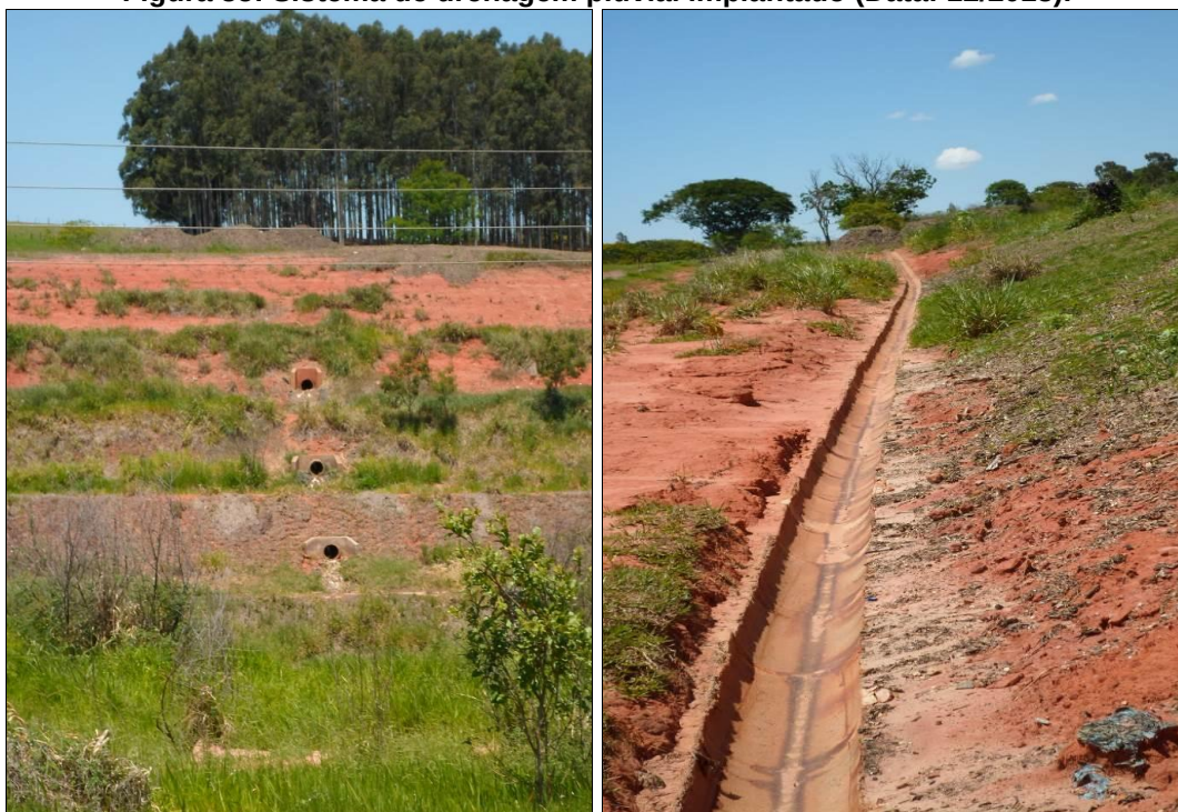
Figura 35: Sistema de drenagem pluvial implantado (Data: 12/2013).
