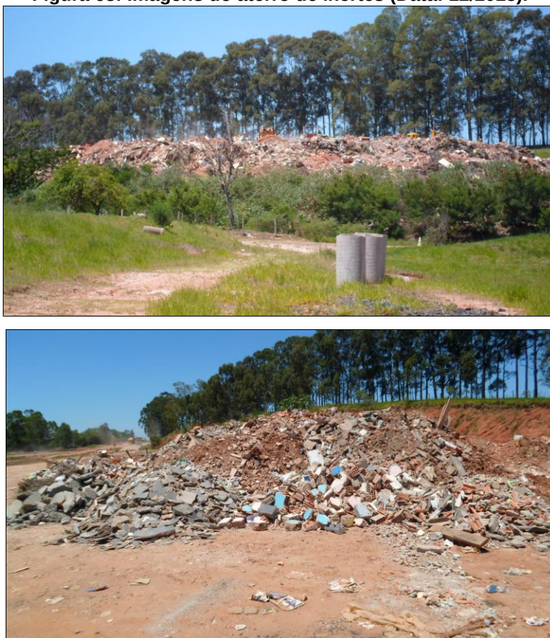
Figura 68: Imagens do aterro de inertes (Data: 12/2013).
