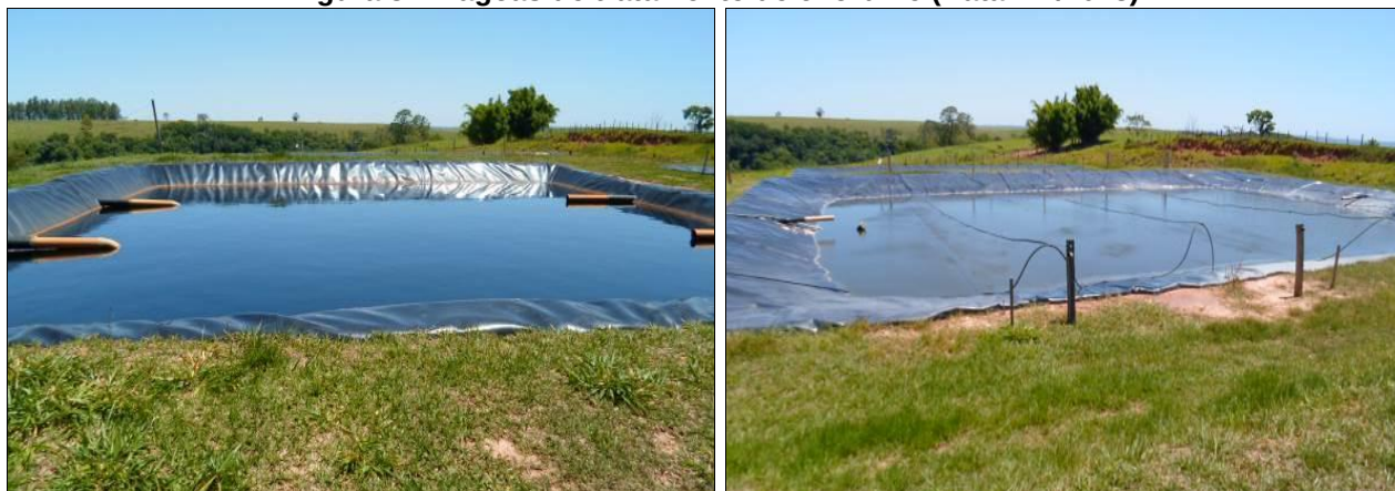
Figura 37: Lagoas de tratamento de chorume (Data: 12/2013).
