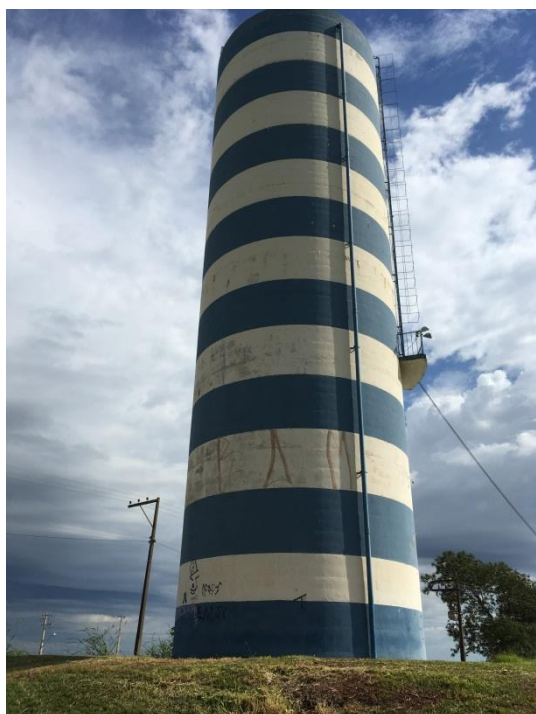
Foto 3.37 - Identificação do Reservatório: REL 05
