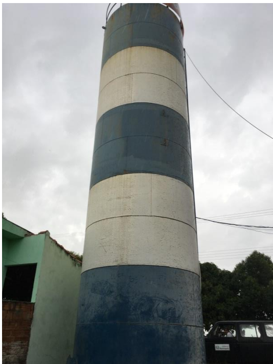
Foto 3.45 - Identificação do Reservatório: RAP 13
