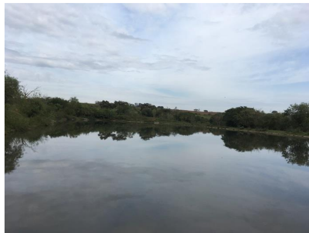
Foto 3.70 – Vista geral da lagoa facultativa ETE Capão Bonito
