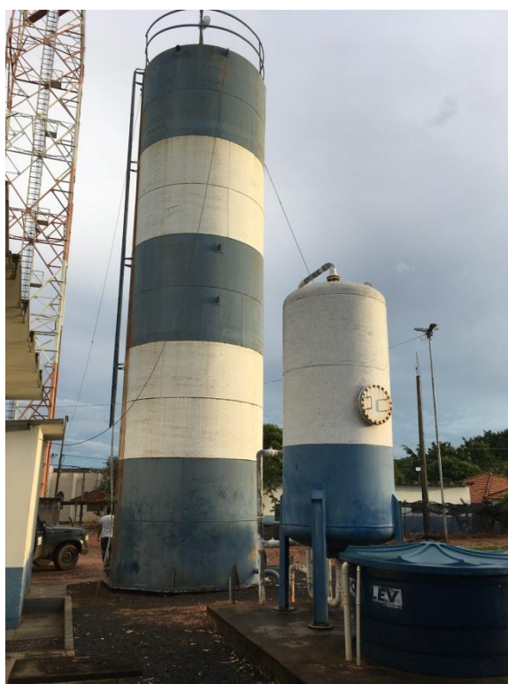
Foto 3.24 – Tratamento complementar para remoção de nitrato no Sistema Distrito Guachos
