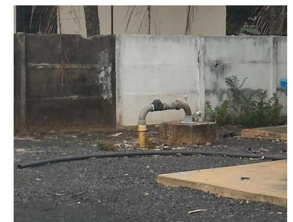
Foto 3.20 - Identificação do Poço: P20
