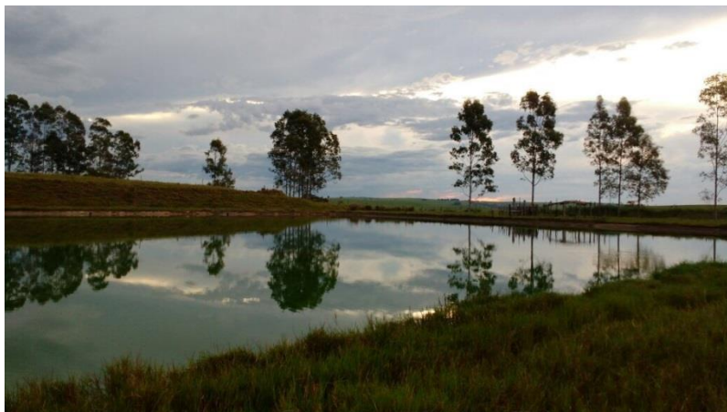
Foto 3.73 – Vista geral da lagoa facultativa ETE Capão Guachos
