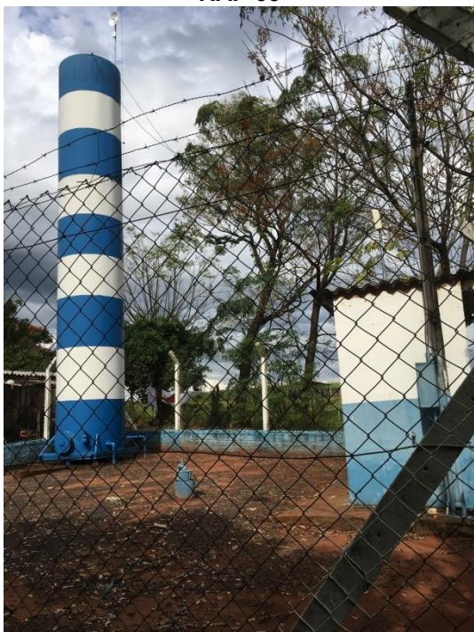
Foto 3.43 - Identificação do Reservatório: RAP 11
