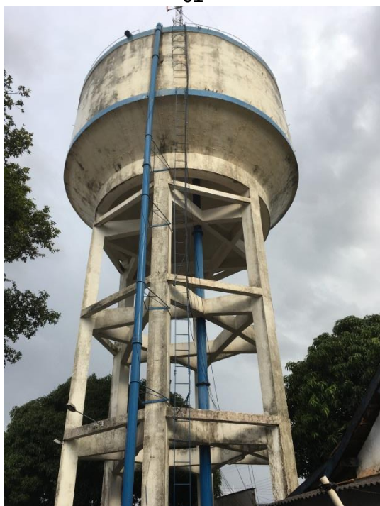
Foto 3.35 - Identificação do Reservatório: REL-03
