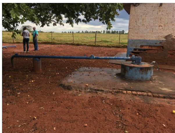
Foto 3.12 - Identificação do Poço: P12
