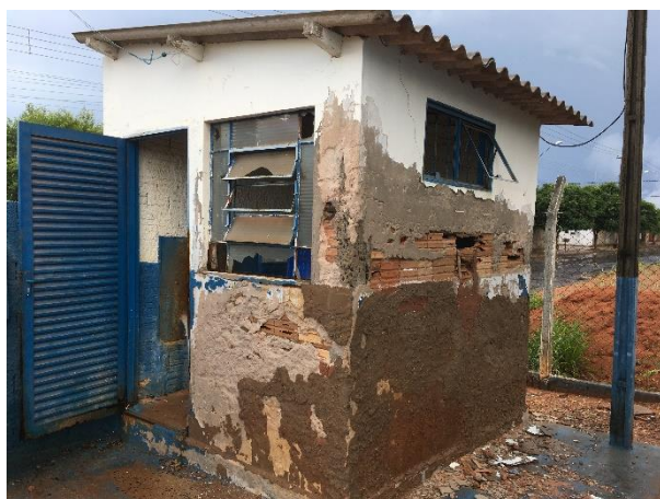
Foto 6.1 – Local onde ficam armazenados os produtos químicos e o painel elétrico
