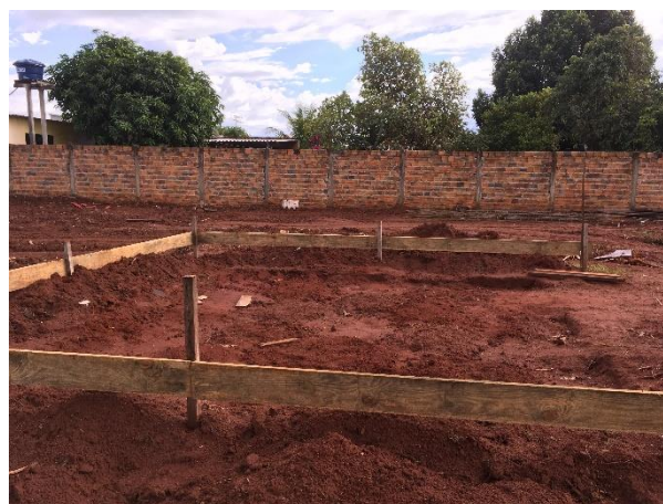
Foto 6.4 – Área onde serão implantados novos poço de captação e reservatório
