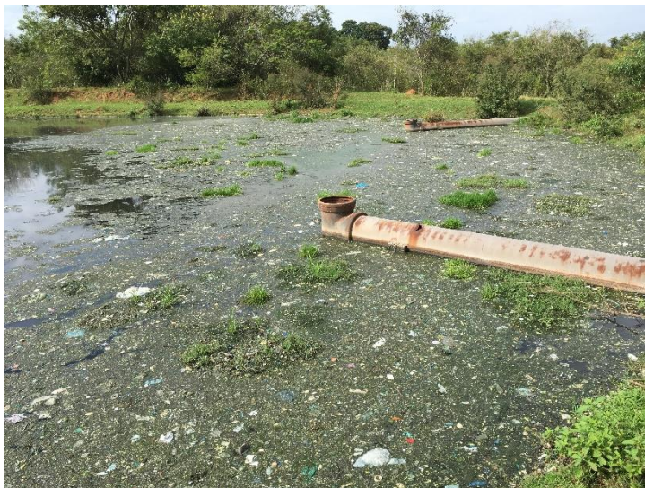
Foto 6.6 – Acúmulo de material flutuante nos desarenadores
