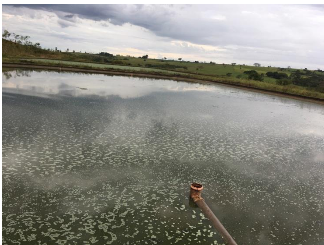
Foto 3.76 – Vista geral da lagoa anaeróbia ETE Teçaindã
