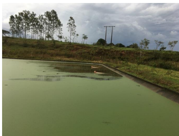
Foto 6.13 – Formação de nata esverdeada sobre a superfície líquida da lagoa facultativa
