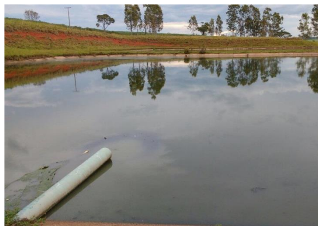
Foto 3.72 – Vista geral da lagoa anaeróbia ETE Guachos
