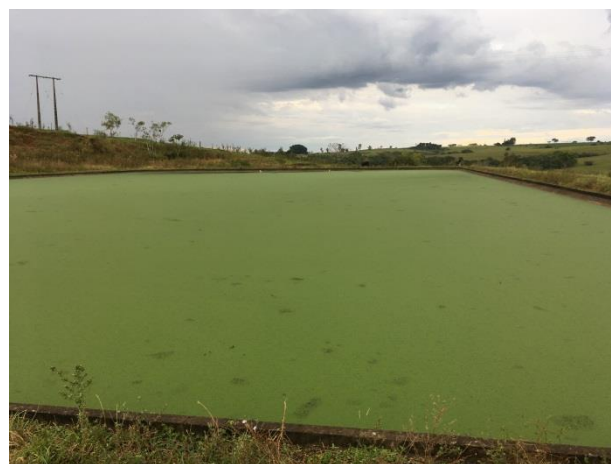
Foto 3.77 – Vista geral da lagoa facultativa ETE Teçaindã
