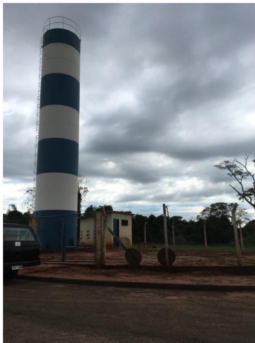
Foto 3.49 - Identificação do Reservatório: RAP 17
