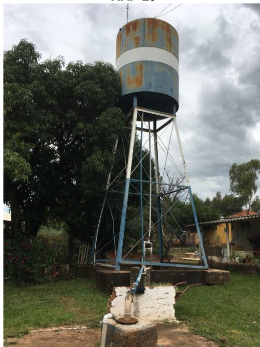
Foto 3.44 - Identificação do Reservatório: REL 12
