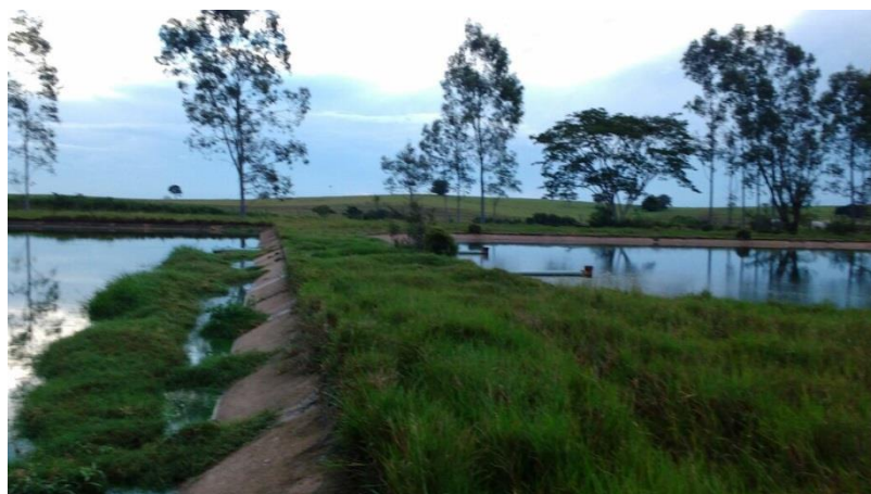
Foto 6.9 – Presença de vegetação e nata esverdeada sobre a superfície líquida da lagoa facultativa
