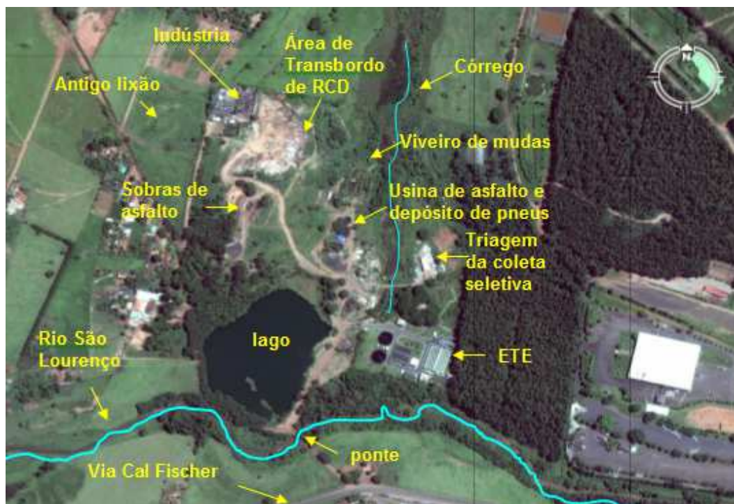
Fig. 69. Vista da área da Pedreira
