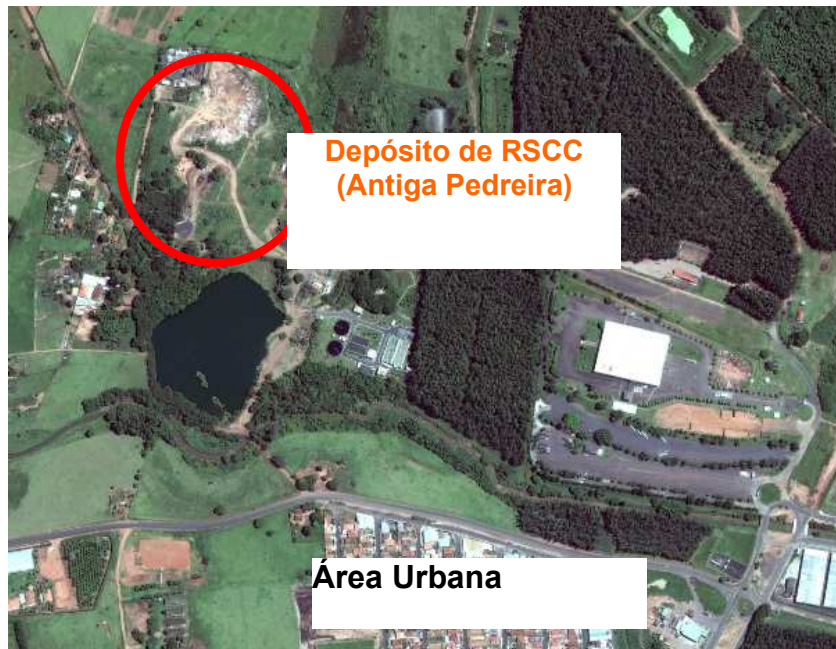
Fig. 68. Vista da área urbana e acesso ao aterro de resíduos sólidos da construção civil e volumosos
