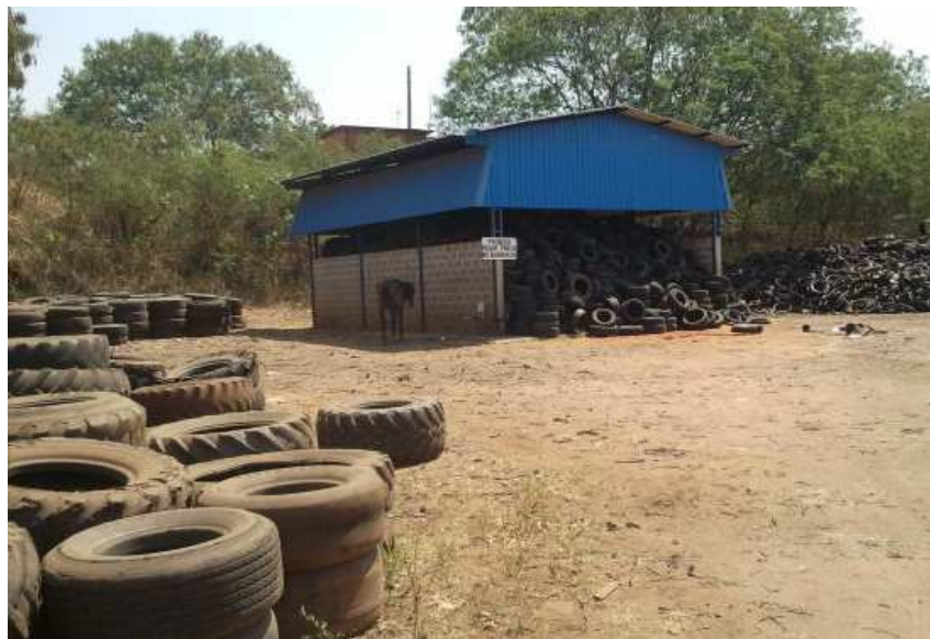
Figura 32 – Galpão para recolhimento de pneus inservíveis – ponto de coleta da Reciclanip
