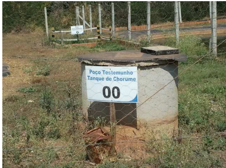
Figura 14 – Poço testemunho do tanque de chorume do aterro municipal
