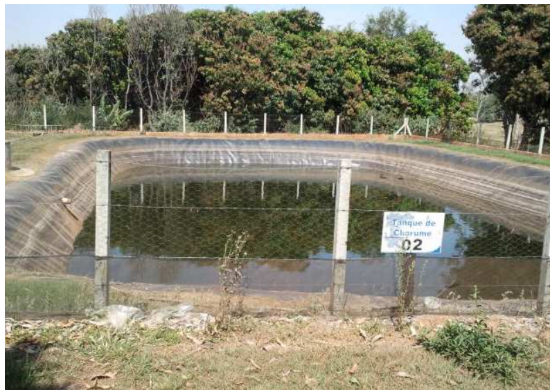
Figura 15 – Tanque de chorume do aterro municipal
