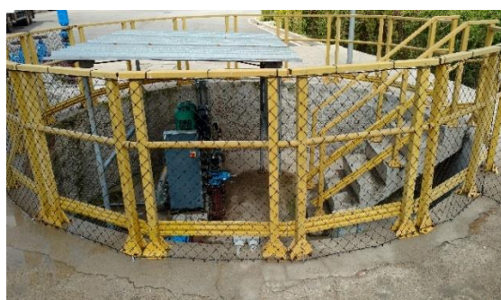
Fotos 28 e 29 – Filtros de areia e carvão poço de água de serviço e reuso
