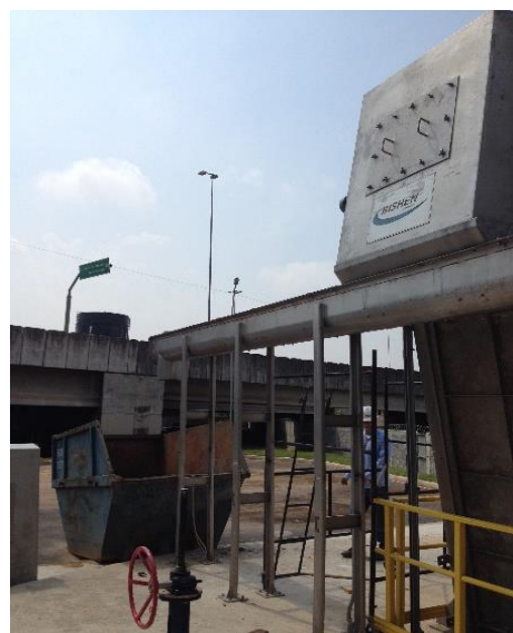
Foto 6 – Poço de Bombas Elevatória Final e Rosca Compactadora
