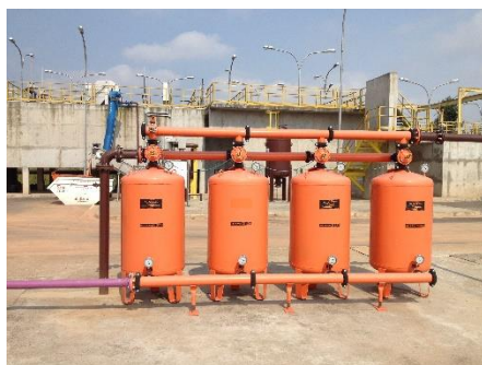
Fotos 28 e 29 – Filtros de areia e carvão poço de água de serviço e reuso
