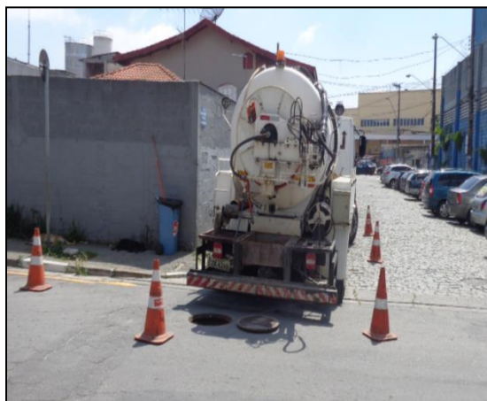
Foto 34 e 35 – Espaço Confinado e Caminhão Jato utilizado para realizar desobstrução.
