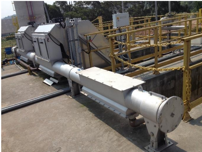
Fotos 15 e 16 – Grade e Rosca Compactadora.
