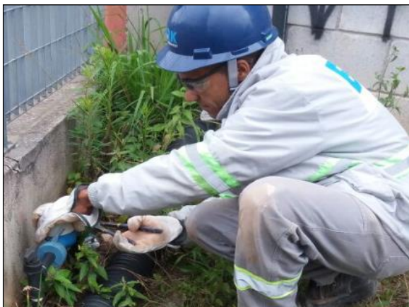
Foto 41 – Realização de manutenção no cavalete.
