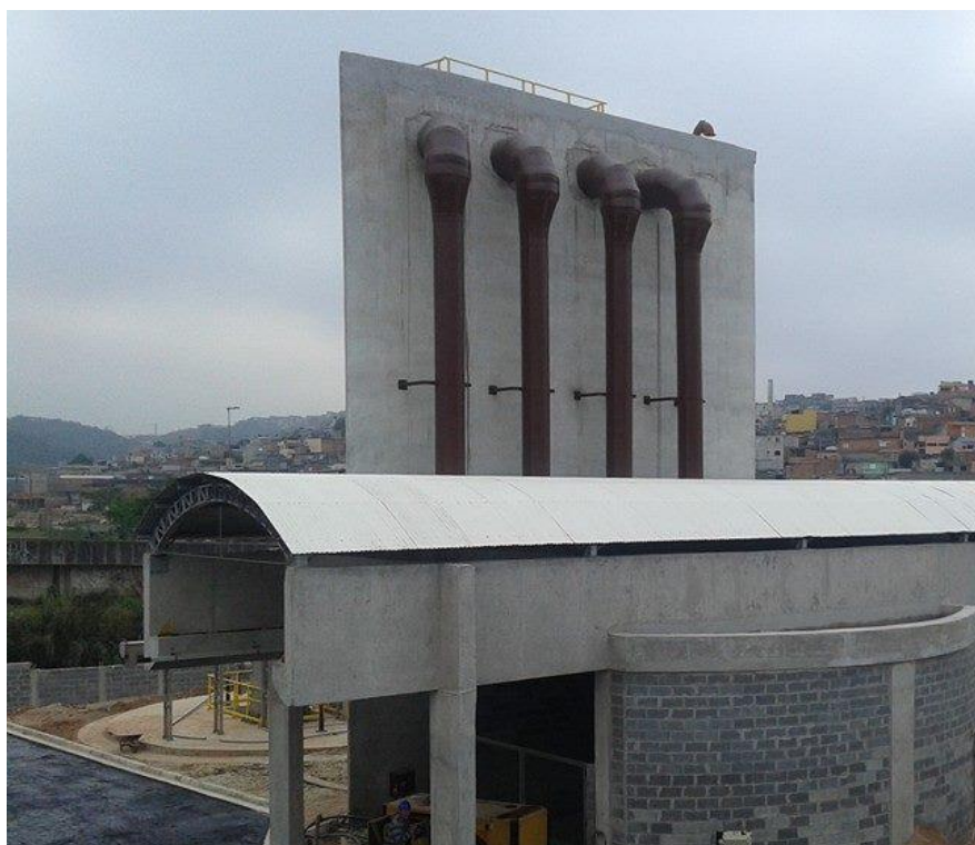
Foto 4 – Câmara de Carga e Gradeamento da Elevatória Final
