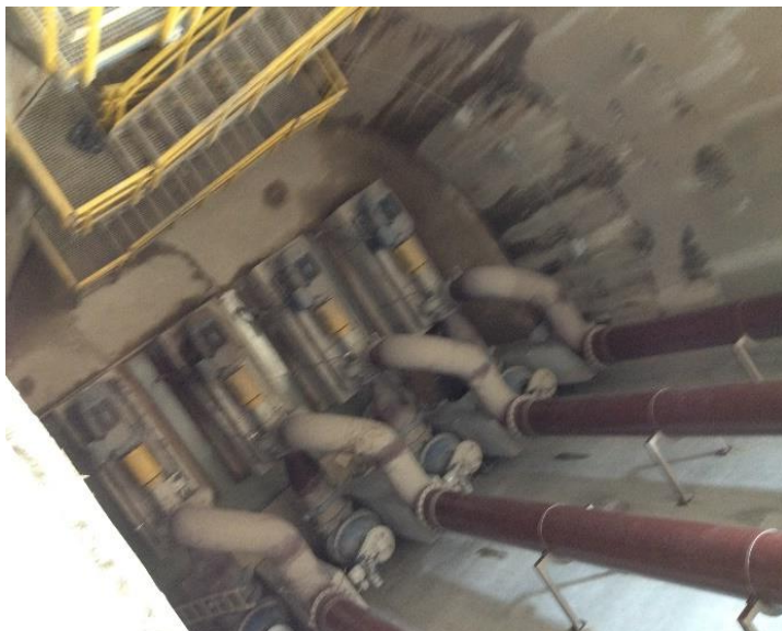
Foto 6 – Poço de Bombas Elevatória Final e Rosca Compactadora
