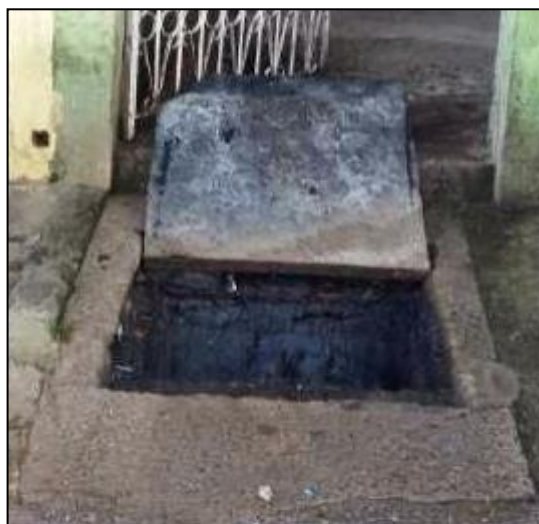
Foto 38 – Caixa de inspeção final após a desobstrução do ramal .
