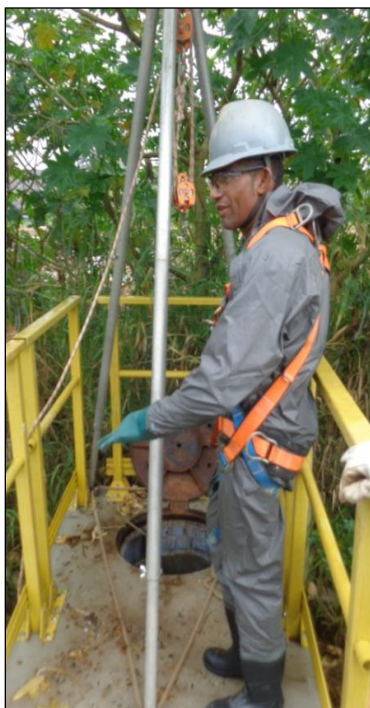
Foto 36 – Tripé instalado para execução de espaço confinado.
