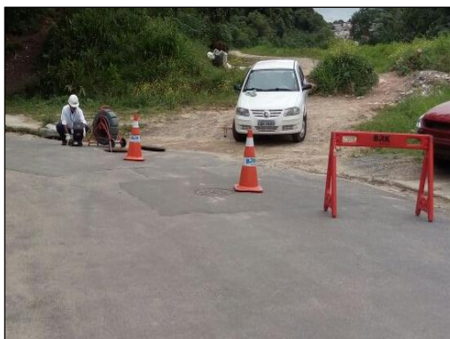
Foto 41 – Sinalização e execução de serviço de Video-Inspeção de rede coletora de esgotos.
