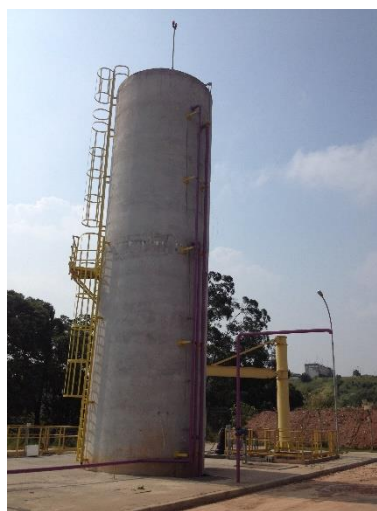
Fotos 26 e 27 - Filtros camatadores e reservatório de água de reuso
