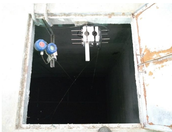
Foto 30 – Tanque de Lodo Bruto
