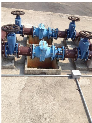
Fotos 26 e 27 - Filtros camatadores e reservatório de água de reuso
