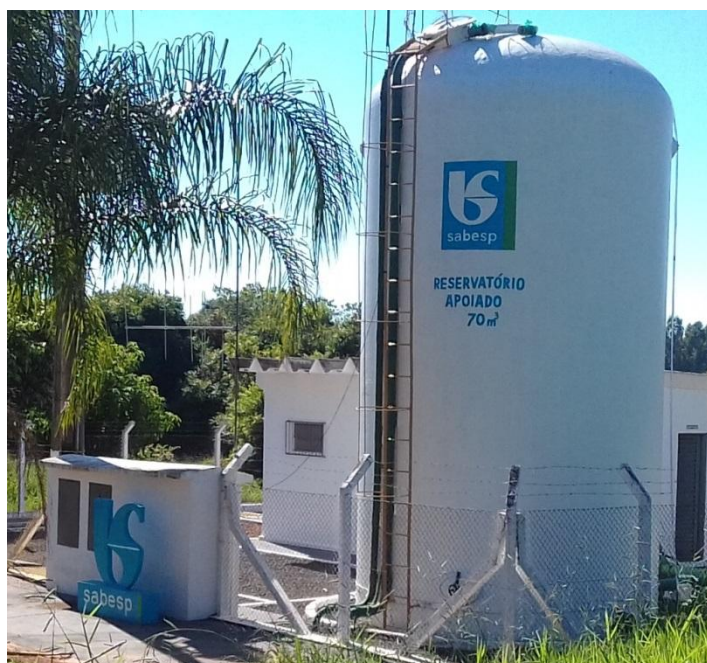
Foto 3.7 – Área dos Reservatório 1
