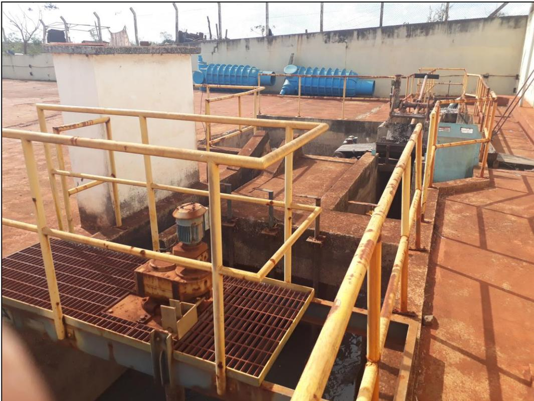
Foto 37 - Estação elevatória EEE01 - Calha Parshall
