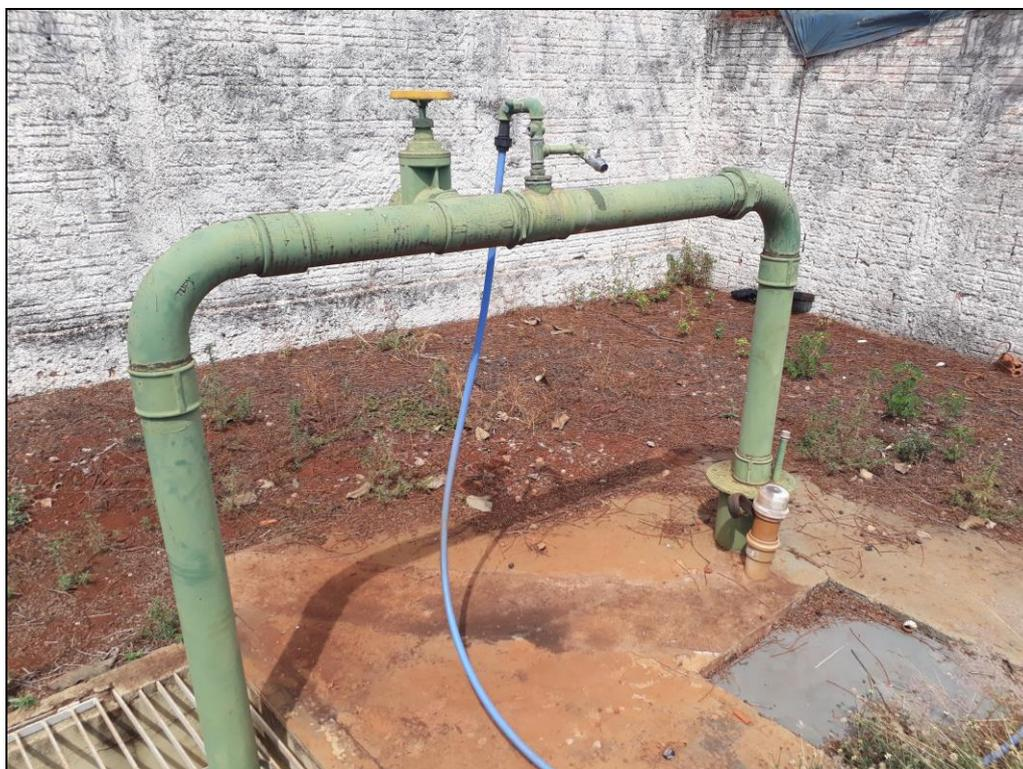
O poço P07 foi desativado, pois apresentou contaminação por nitrato. É um poço em localização favorável e possui toda a infraestrutura necessárias para a operação. A perfuração de um novo poço na área pode ser considerada. Quando em operação o poço abastecia o RAP01
