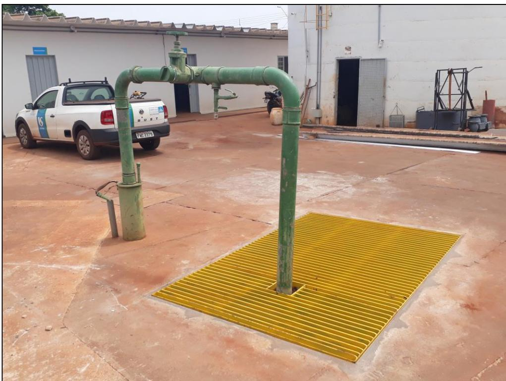
O poço P05 está em operação normal e abastece o reservatório RAP01. O poço apresenta produção de areia que, no entanto, não impede seu aproveitamento.
