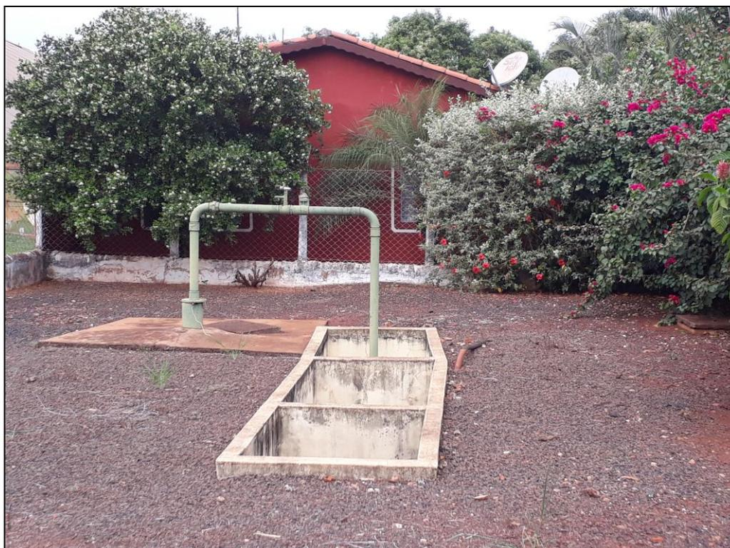
O poço P08 está desativado. Tem baixa produção e provavelmente a camisa está rompida, pois tem infiltração revelada pela presença de água barrenta.
