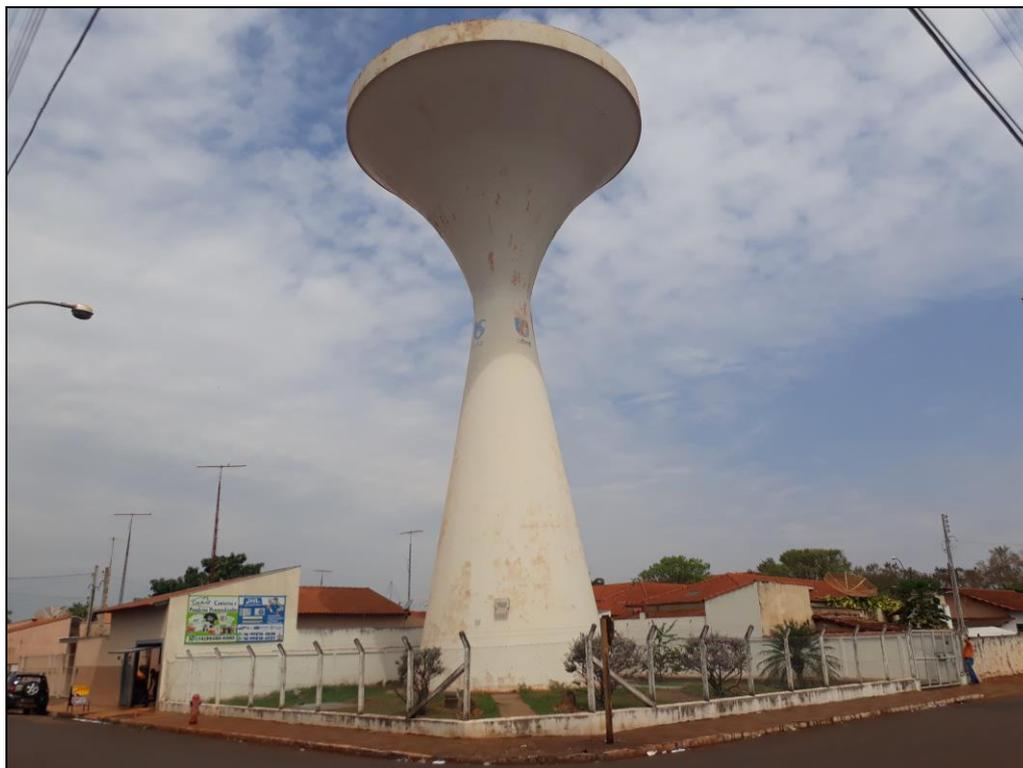
O volume total de reservação existente é de 1.200 m<sup>3</sup>, inferior ao volume dimensionado para 2018 de 1.631 m<sup>3</sup>.
