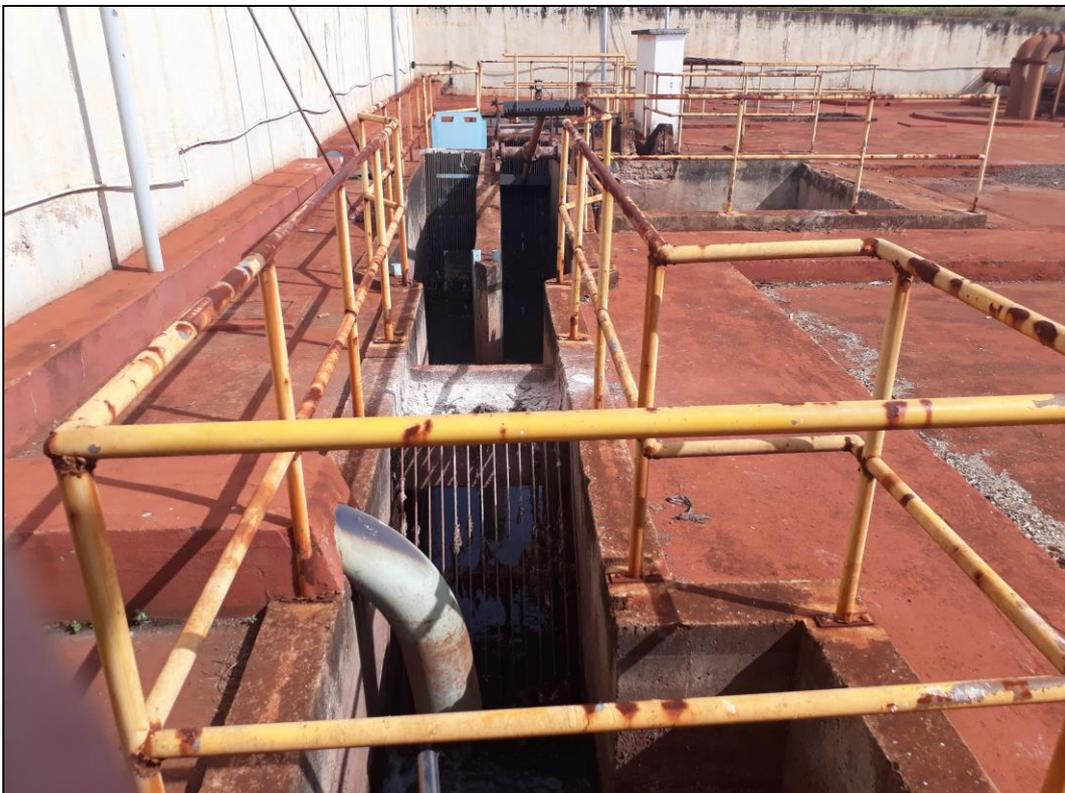
Foto 35 - Estação elevatória EEE01 - Gradeamento fino
