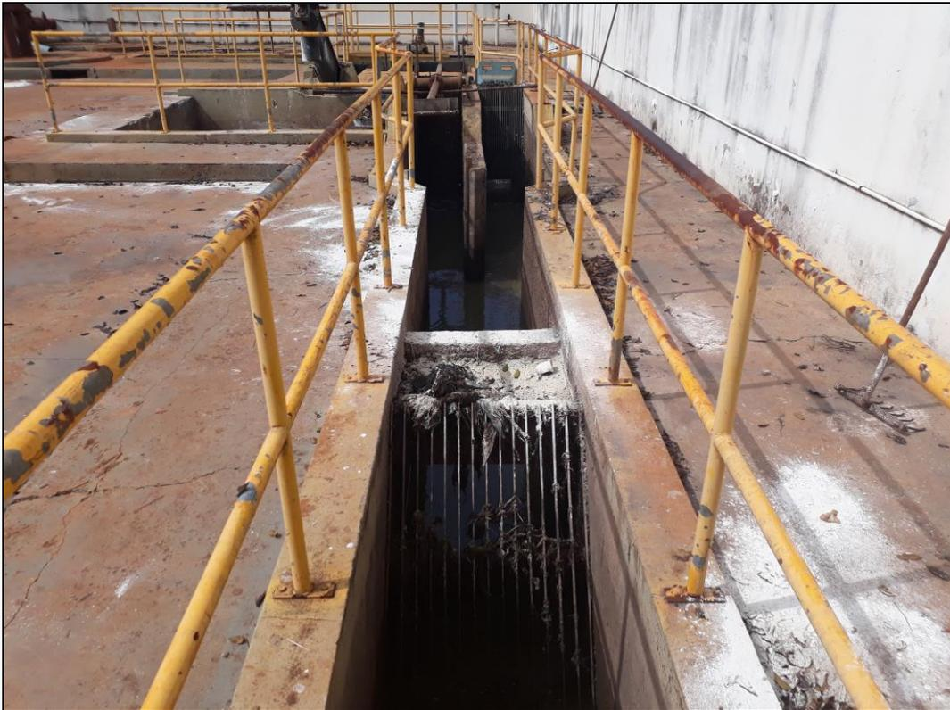
Foto 43 - Estação elevatória EEE02 - Caixa de areia
