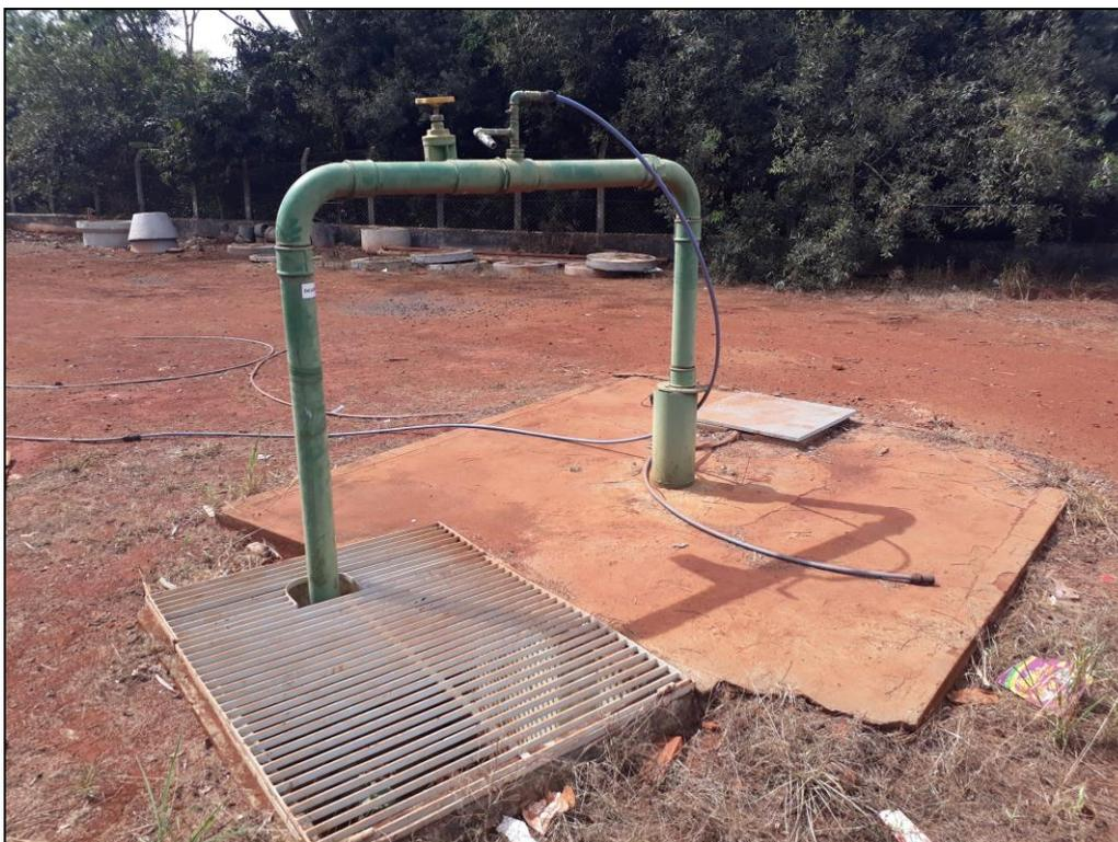
O poço P03 está em reserva, tamponado e não está interligado com o sistema de água.
