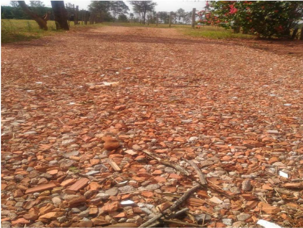
Figura 24: Material (RCC) para impermeabilizar estradas.
