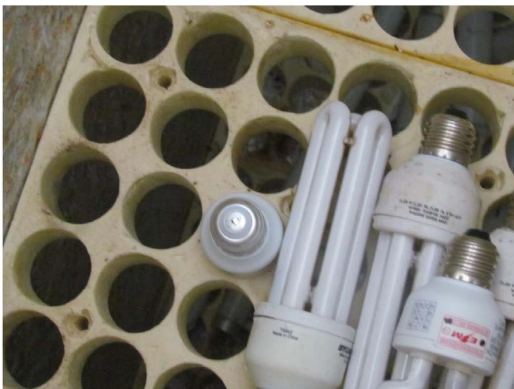
Figura 37: Caixa apropriada para recolher temporariamente lâmpadas fluorescentes
