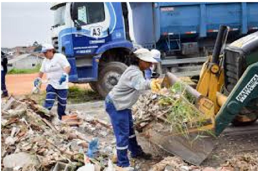
Figura 21: Ilustração de coleta de resíduos da construção civil.
