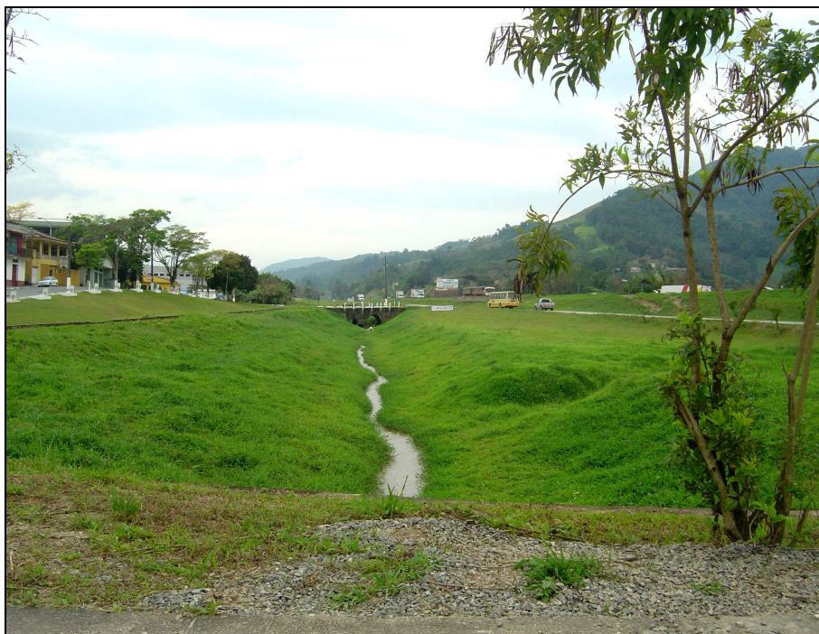
Foto 3 – Visão do Córrego Prainha em Área Urbana de Miracatu
