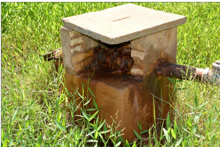
Foto 78: – Local onde é Feito a Dosagem (Tratamento) – Hipoclorito de Sódio e Ácido Fluorsilícico Poço P1 Localização: Jardim Aeroporto.
