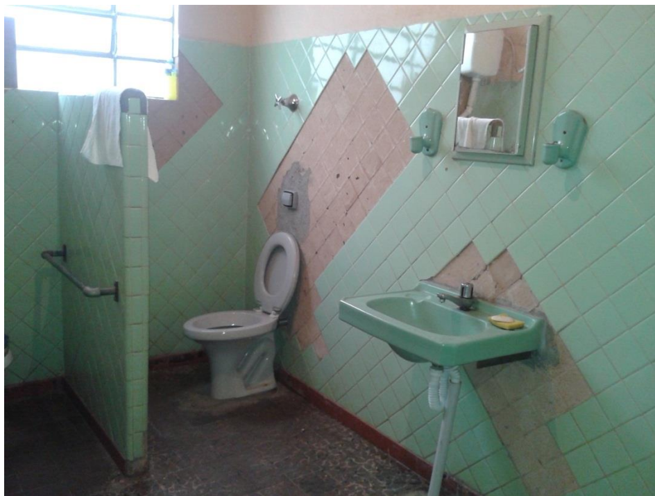
Foto 147: – Banheiros Localização: SAAEM – Mirandópolis
