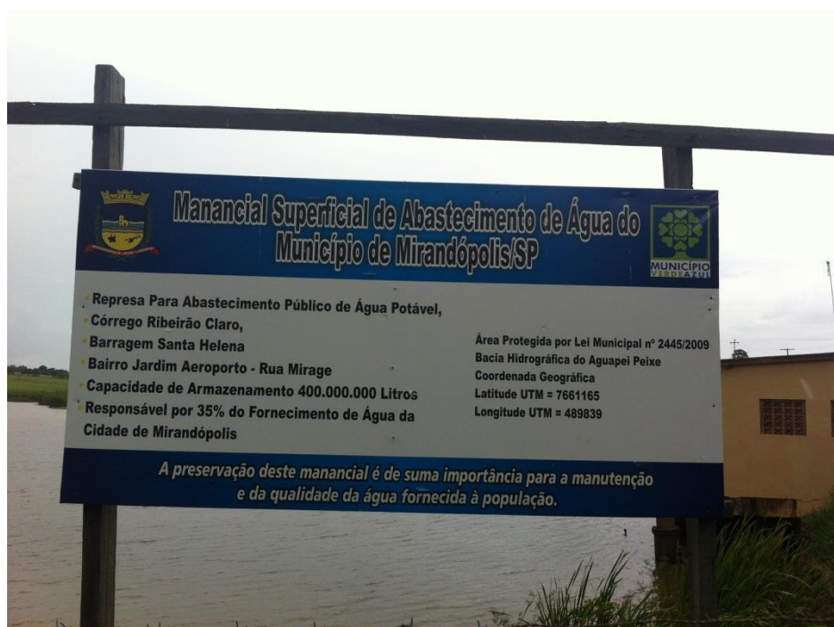
Foto 38: – Placa Informativa Localização: Barragem Santa Helena
