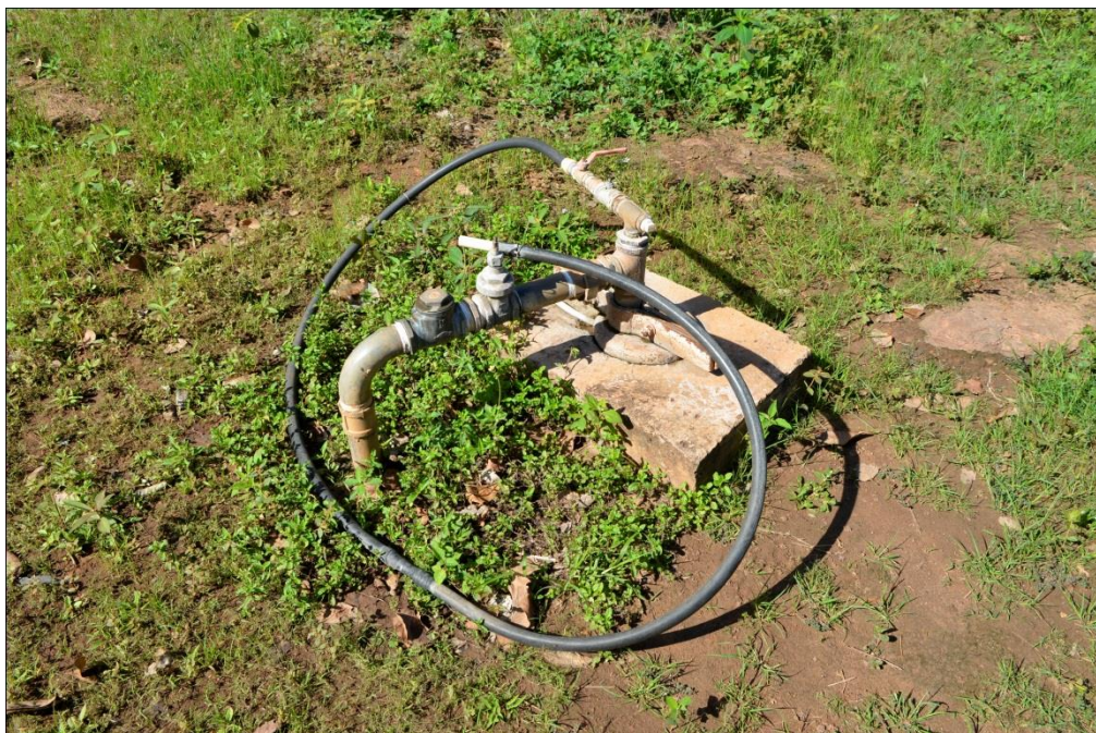
Foto 122: – Entrada Poço - P1 Localização: Bairro Amandaba
