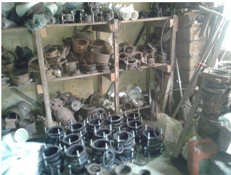
Foto 153: – Almoxarifado Localização: SAAEM – Mirandópolis
