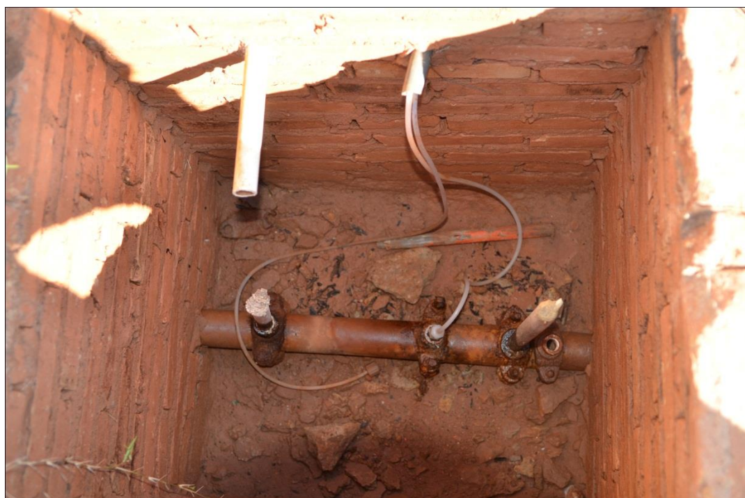
Foto 116: – Local onde é Feito a Dosagem de Cloro e Flúor para Tratamento da Água– Poço P13
