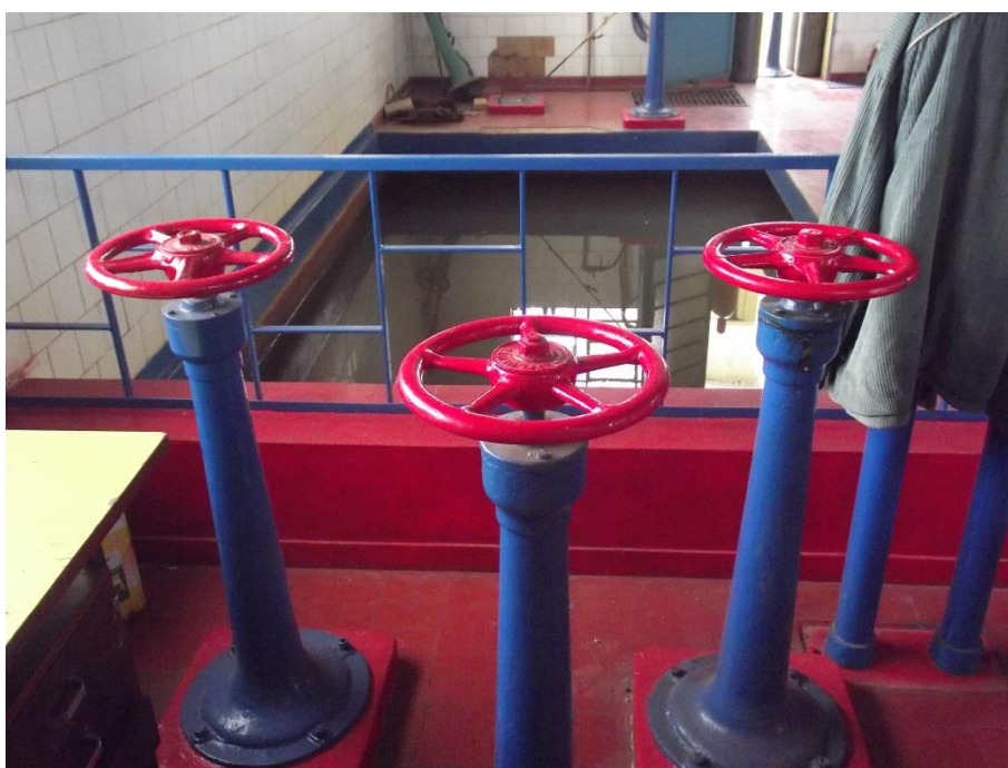
Foto 68: – Registros dos Filtros de Tratamento Localização: ETA – Estação de Tratamento de Água
