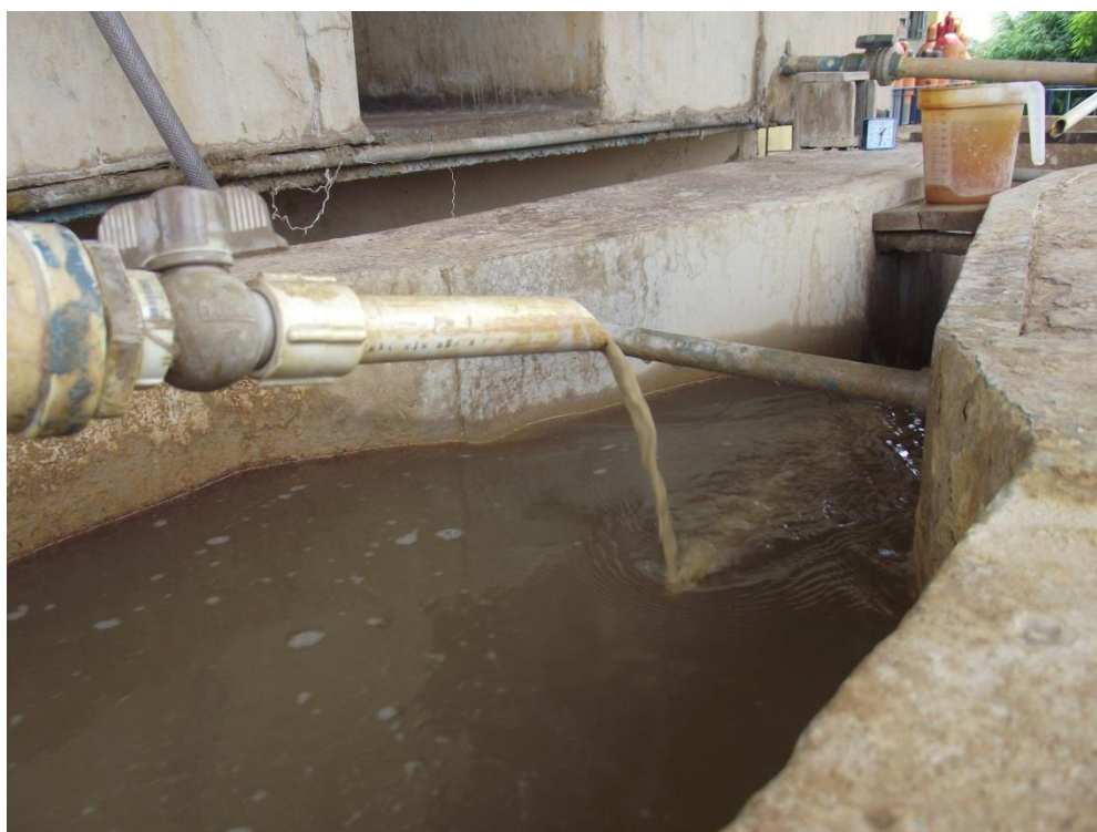
Foto 62: – Adição de Sulfato de Alumínio Ferroso – Água Bruta Localização: ETA – Estação de Tratamento de Água
