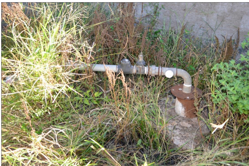
Foto 123: – Entrada Poço - P2 Localização: Bairro Amandaba
