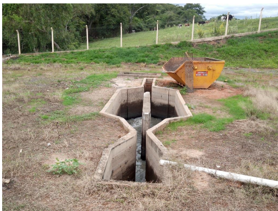
Foto 172: – Calha Parshall - Gradeamento Localização: Estação Elevatória de Esgoto Ribeirão Conchal
