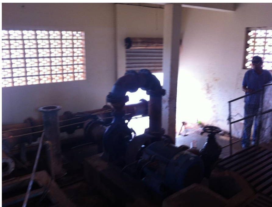
Foto 44: – Motor e Bomba da Captação da Água Bruta Localização: Barragem Santa Helena
