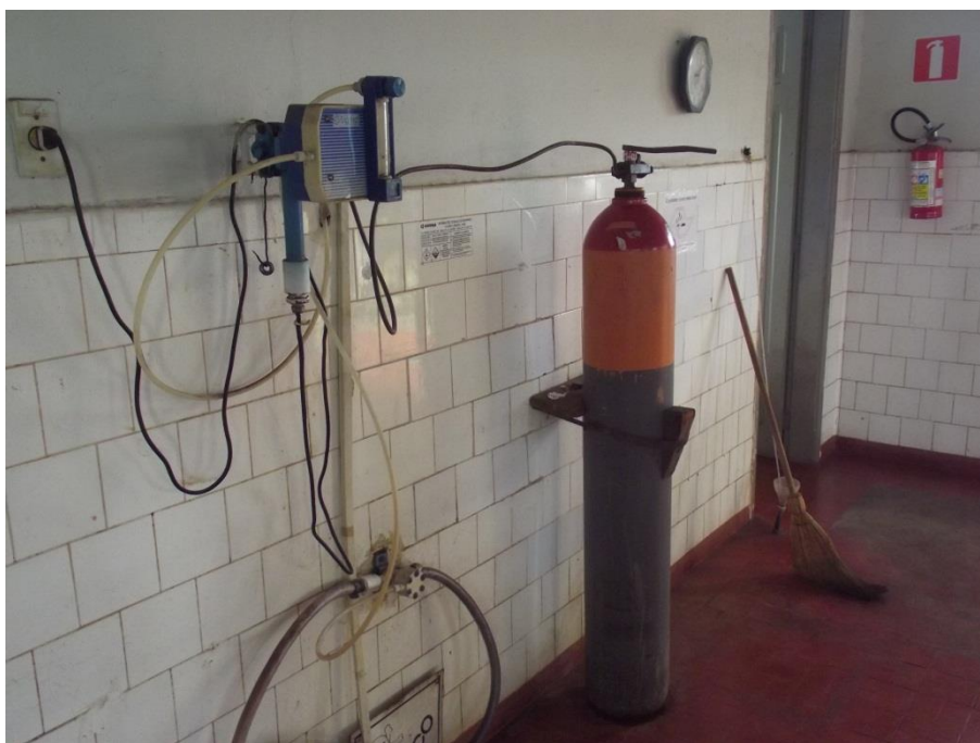
Foto 69: – Bojões para Aplicação do Gás Cloro Para o Tratamento Localização: ETA – Estação de Tratamento de Água
