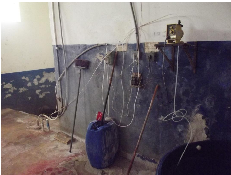
Foto 71: – Bombas Dosadoras para Aplicação do Ácido Fluorsilícico e Orto-Polifosfato (Econox) Localização: ETA – Estação de Tratamento de Água
