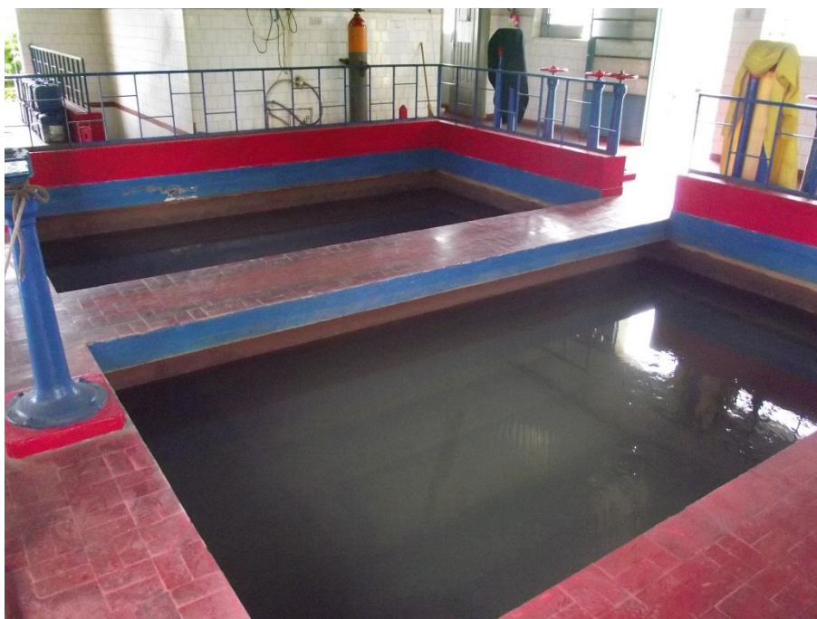
Foto 67: – Filtros do Tratamento e Registros ao Fundo Localização: ETA – Estação de Tratamento de Água
