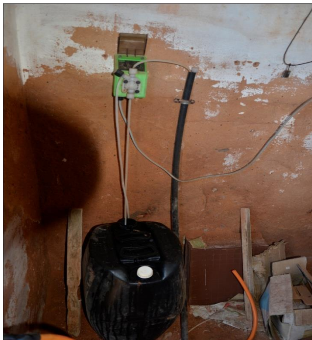
Foto 103: – Produtos Químicos, Bombas Dosadoras e Pannel de Comando P8 Localização: – São Lourenço de Fátima II
