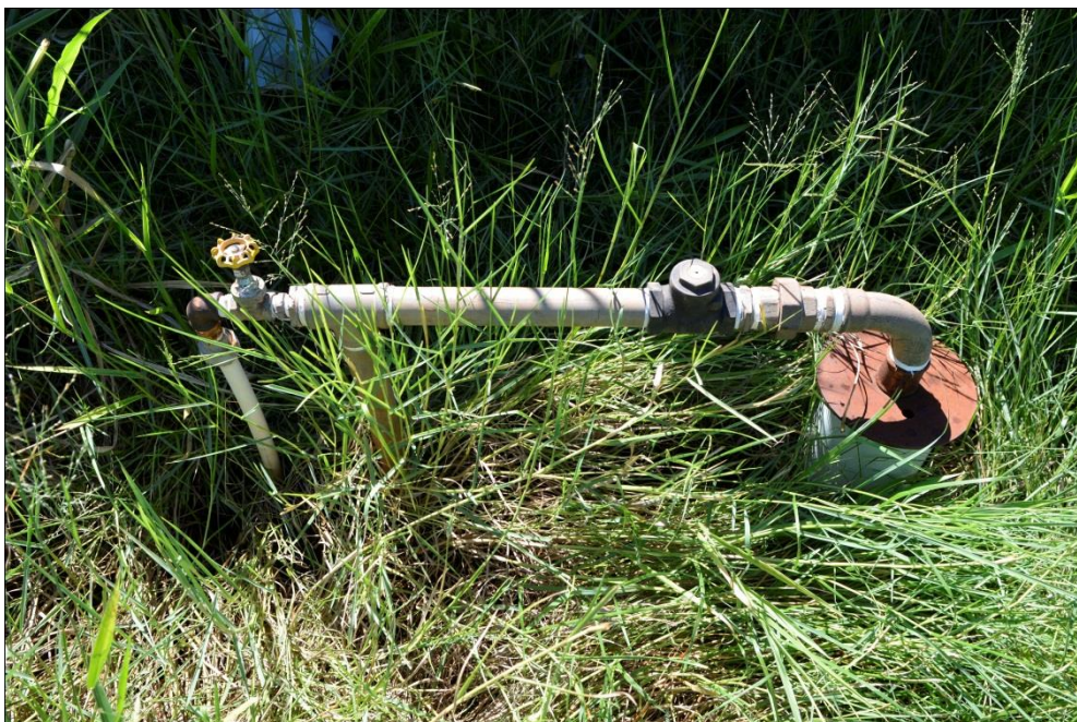
Foto 105: – Entrada do Poço (P9) Localização: – Colina Verde
