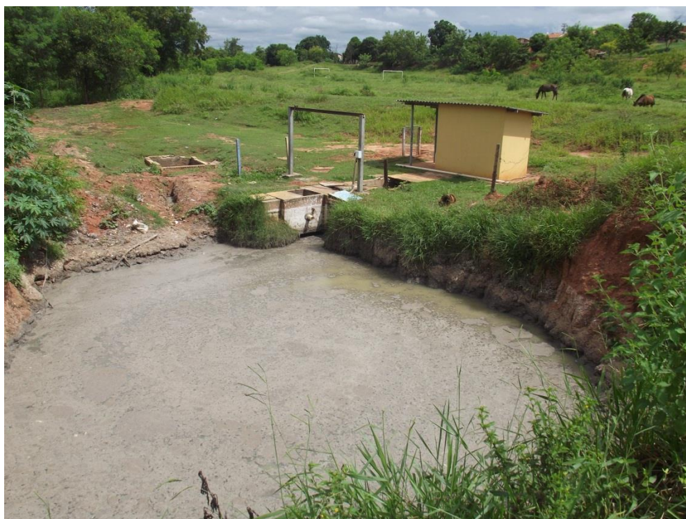
Foto 186: – Vala Executada pelo SAAEM para Conter os Constantes Extravasos de Esgotos (Vista Aérea) Localidade: Estação Elevatória de Esgoto – Santa Rosa
