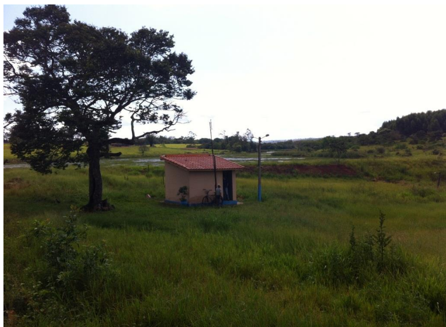
Foto 51: – Guarita Operadores Localização: Barragem São Lourenço
