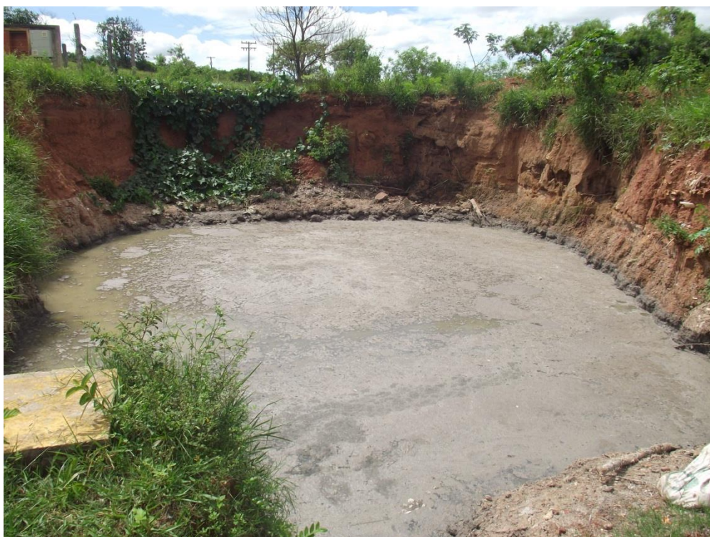
Foto 185: – Vala Executada pelo SAAEM para Conter os Constantes Extravasos de Esgotos Localidade: Estação Elevatória de Esgoto – Santa Rosa
