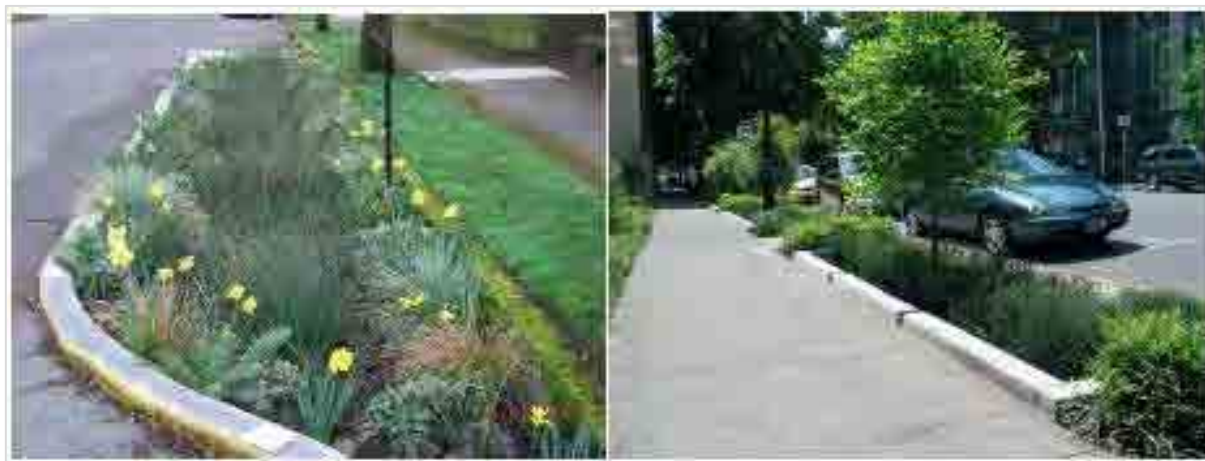
Figura 1.8 – Exemplo de valas de infiltração
