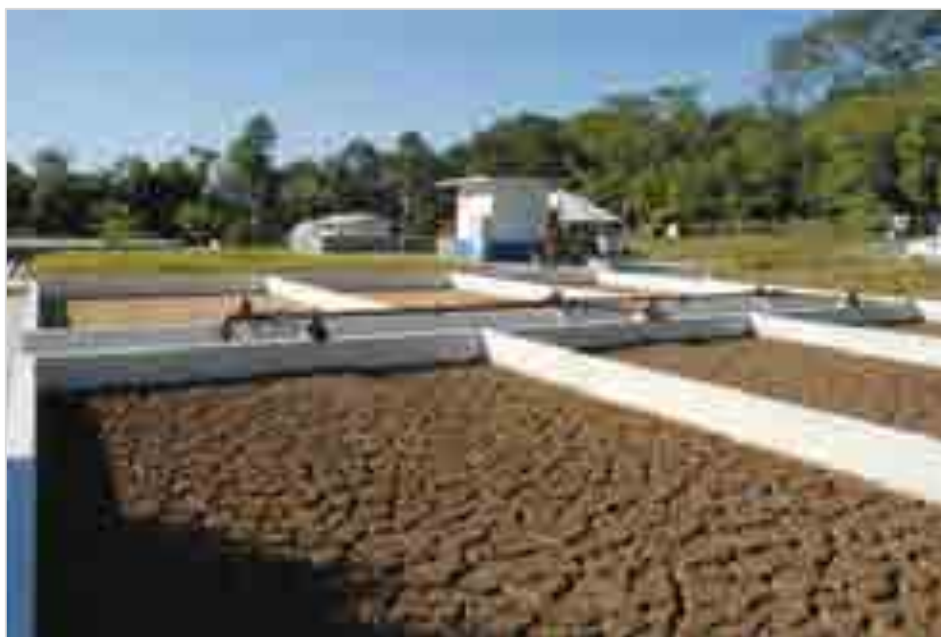
Figura 1.11 – Leito de secagem de lodo de esgoto
