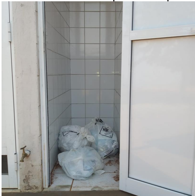
Figura 2.19 – Interior da área de transbordo dos resíduos de serviço de saúde da UBS Dr. Francisco T. Pardo no município de Mirandópolis – SP.
