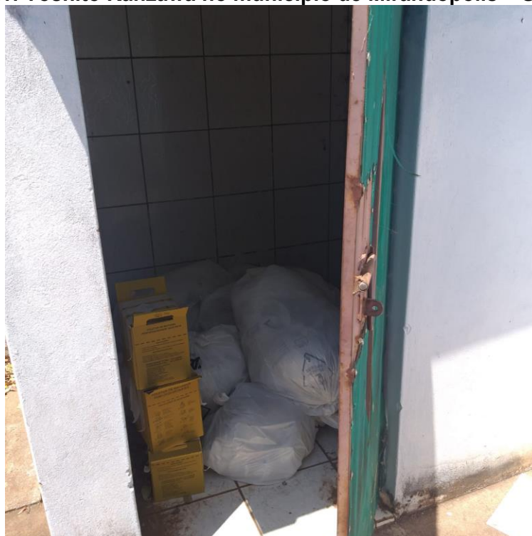
Figura 2.21- Interior da área de transbordo dos resíduos de serviço de saúde da UBS Dr. Yoshito Kanzawa no município de Mirandópolis – SP.
