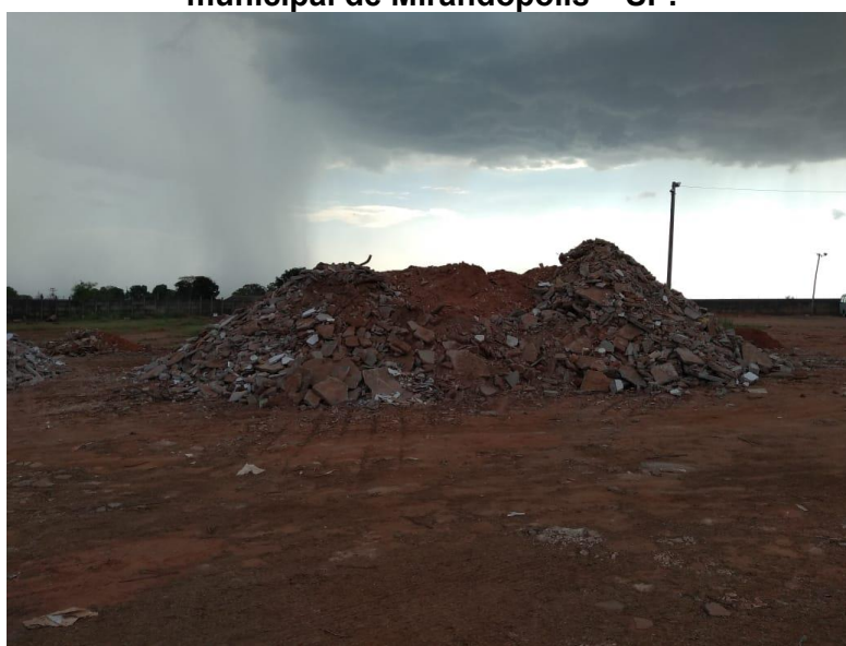
Figura 2.28 – Disposição de entulho para uso em estrada rural no almoxarifado municipal de Mirandópolis – SP.
