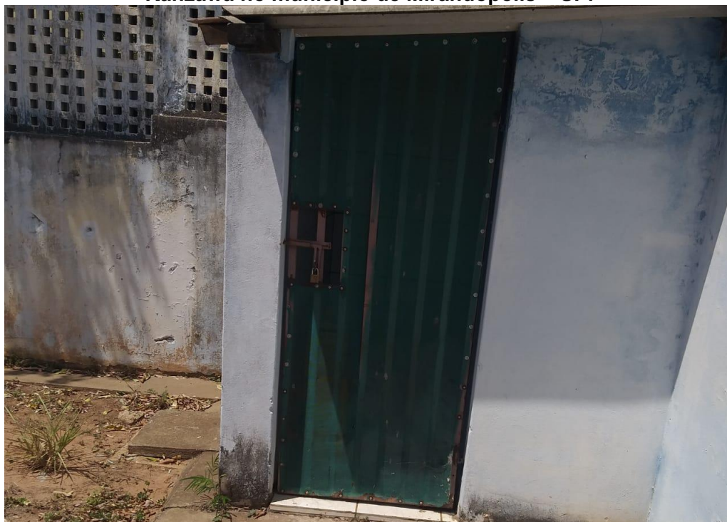
Figura 2.20 - Área de transbordo dos resíduos de serviço de saúde da UBS Dr. Yoshito Kanzawa no município de Mirandópolis – SP.
