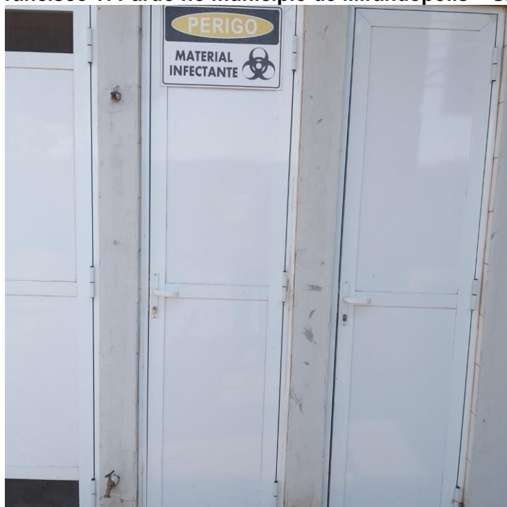
Figura 2.18 - Área de transbordo dos resíduos de serviço de saúde da UBS Dr. Francisco T. Pardo no município de Mirandópolis – SP.
