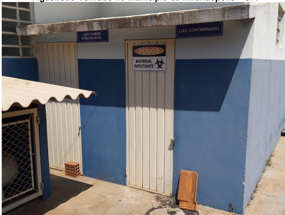
Figura 2.16 - Área de transbordo dos resíduos de serviço de saúde da UBS Dr. Rubéns Figueiredo Conrado no município de Mirandópolis – SP.
