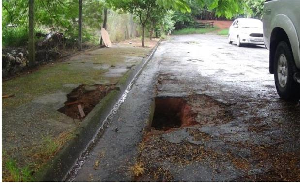
Foto 3.23 – Problemas na pavimentação devido a velocidade do escoamento superficial – Rua Pitágora Marineli
