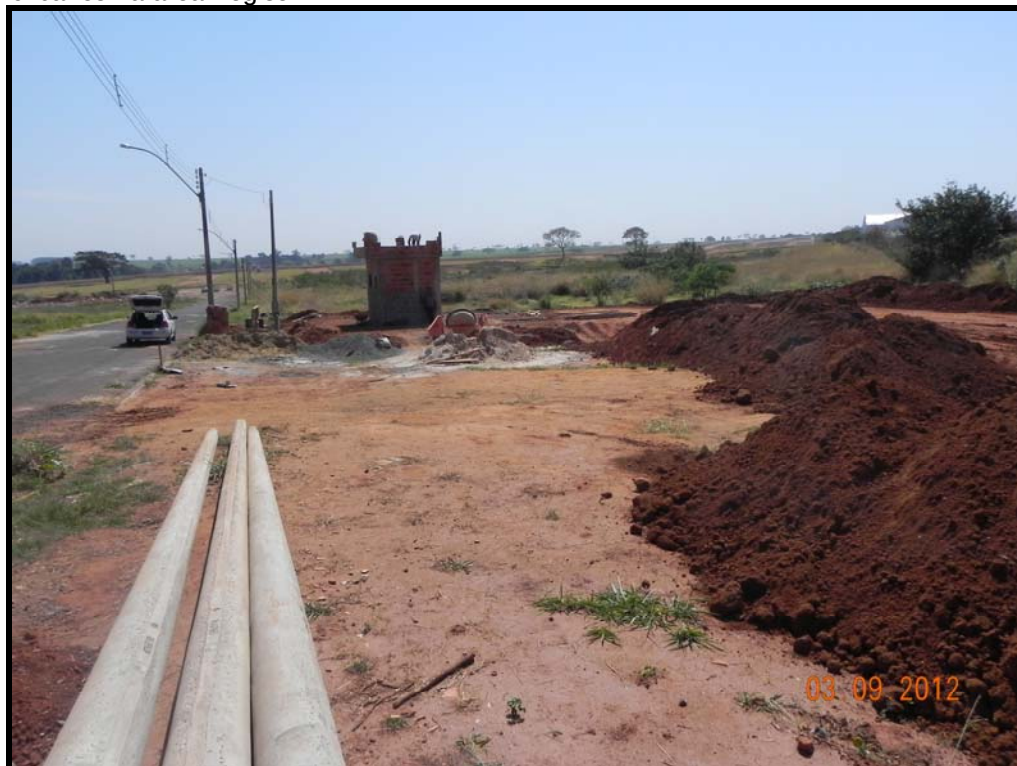
Figura 32: Construção do ponto de apoio para deposição de resíduos sólidos urbanos na área Regisol.
