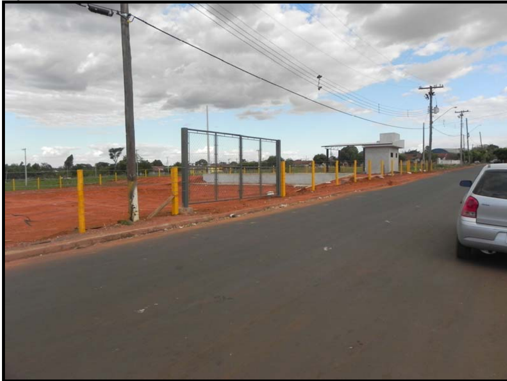
Figura 13: Vista da Entrada da área conhecida como Coab.
