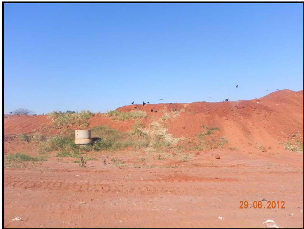
Figura 5: Vista frontal do talude de deposição de resíduos do aterro sanitário de Mirassol.
