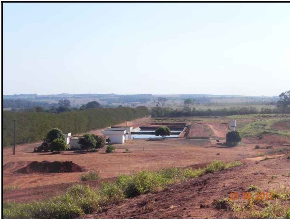
Figura 7: Vista da área de captação e evaporação de efluentes líquidos do aterro sanitário de Mirassol.
