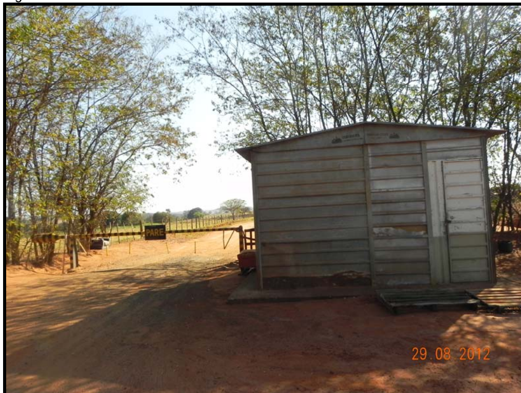
Figura 3: Guarita de entrada do Aterro Sanitário de Mirassol.
