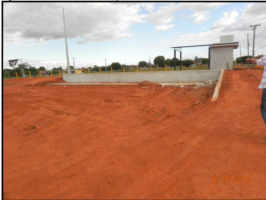
Figura 15: Vista da Coab em construção.
