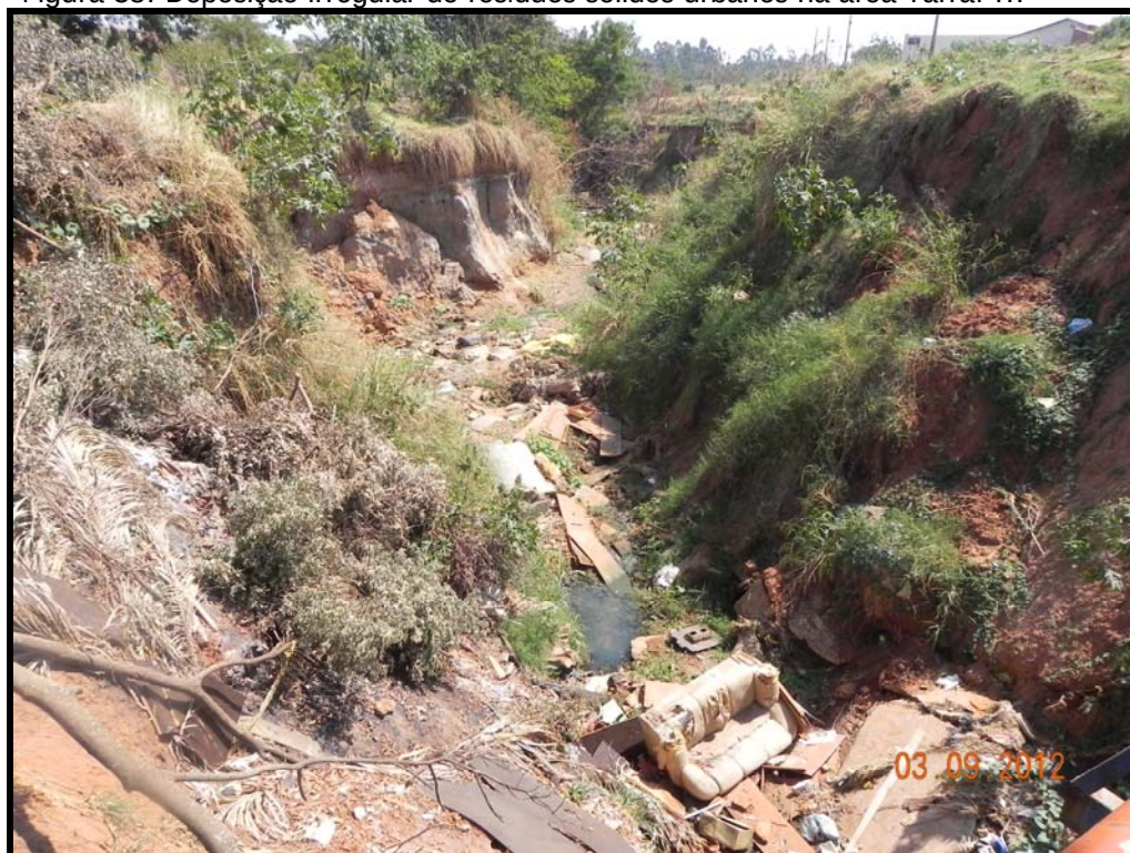
Figura 38: Deposição irregular de resíduos sólidos urbanos na área Tarraf II.
