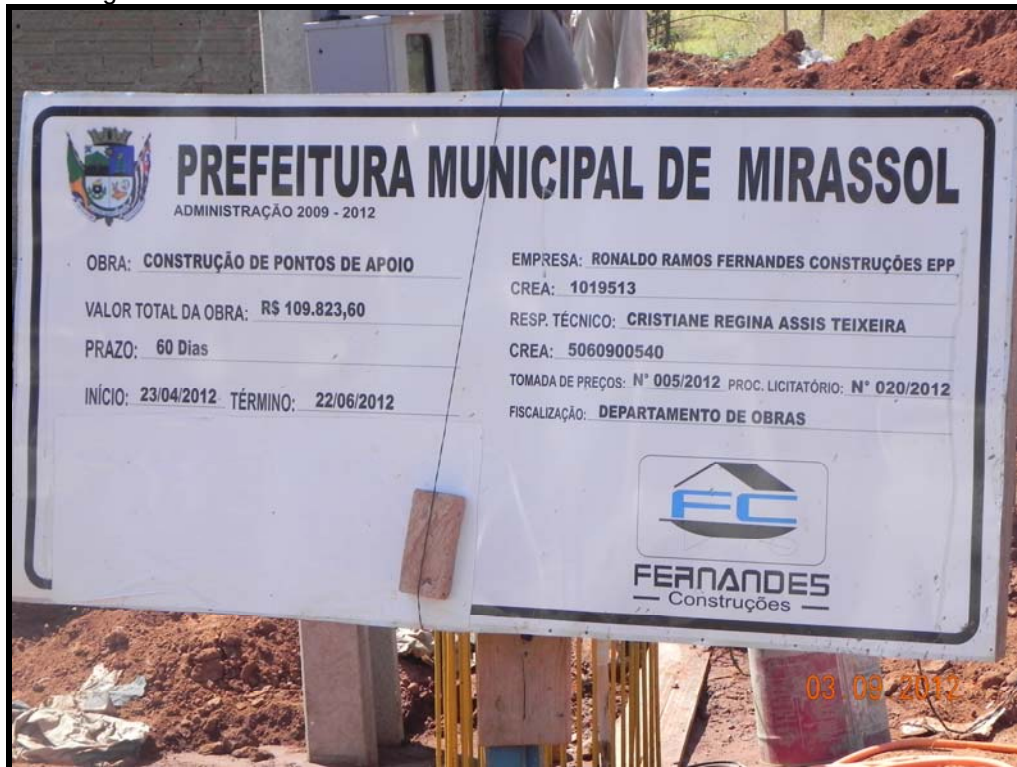
Figura 31: Futuro ponto de apoio para deposição de resíduos sólidos urbanos na área Regisol.
