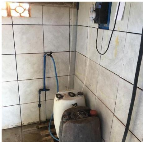
Foto 3.21 – Vista da bomba dosadora de Flúor do poço P06
