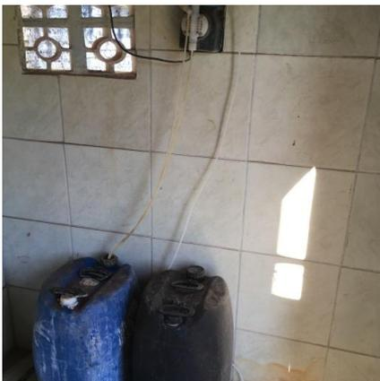
Foto 3.15 – Vista da bomba dosadora de Flúor do poço P03
