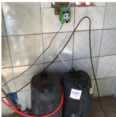
Foto 3.26 – Vista da bomba dosadora de Flúor do poço P09
