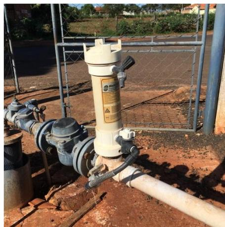
Foto 3.20 – Vista do dosador de Cloro do poço P06
