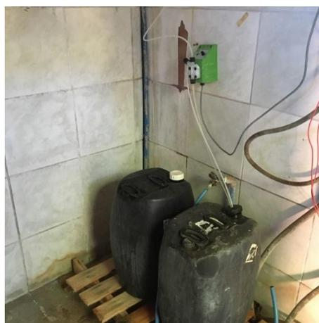
Foto 3.18 – Vista da bomba dosadora de Flúor do poço P05
