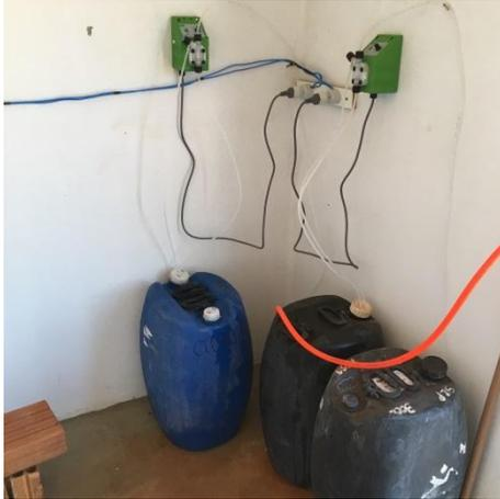
Foto 3.27 – Vista das bombas dosadoras de Cloro e Flúor do poço P10
