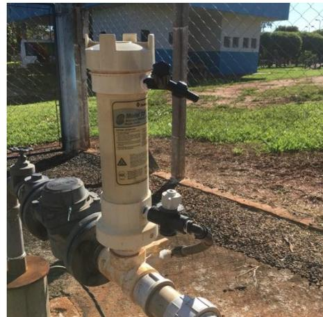
Foto 3.14 – Vista do dosador de Cloro do poço P02
