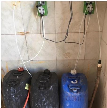
Foto 3.22 – Vista das bombas dosadoras de Cloro e Flúor do poço P07
