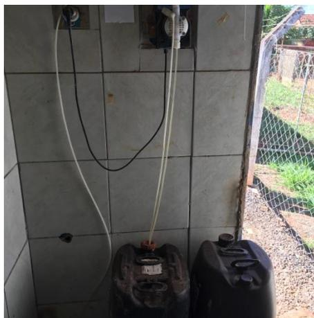
Foto 3.24 – Vista da bomba dosadora de Flúor do poço P08
