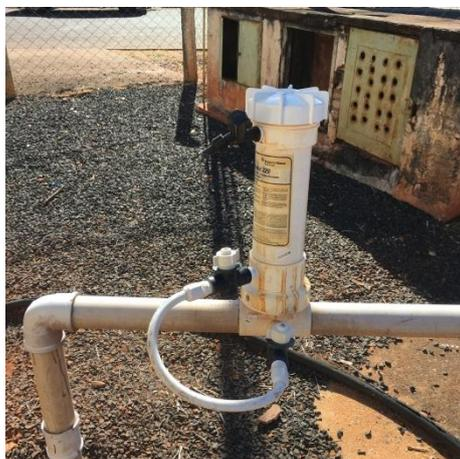
Foto 3.23 – Vista do dosador de Cloro do poço P08
