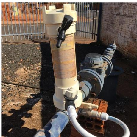
Foto 3.25 – Vista do dosador de Cloro do poço P09
