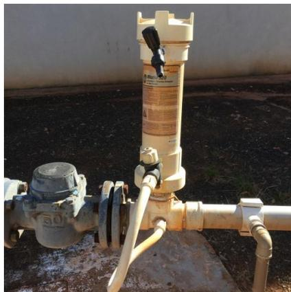
Foto 3.16 – Vista do dosador de Cloro do poço P04
