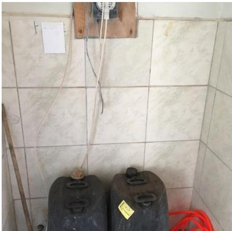
Foto 3.13 – Vista da bomba dosadora de Flúor do poço P01
