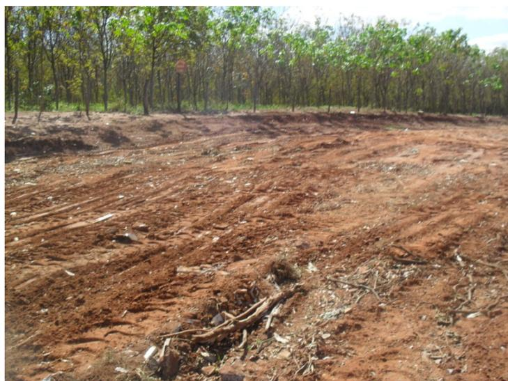
**Figura 09:** Recuperação de processo erosivo utilizando entulho para aterramento na estrada vicinal Mirassolândia - Balsamo. A esquerda parte da erosão ainda sem material, a direita local já recuperado com entulho.
