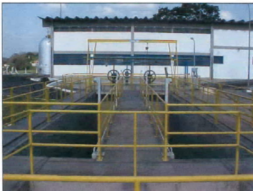
Foto 6 - Vista da caixa de areia da captação do Rio Canoas - Sede
