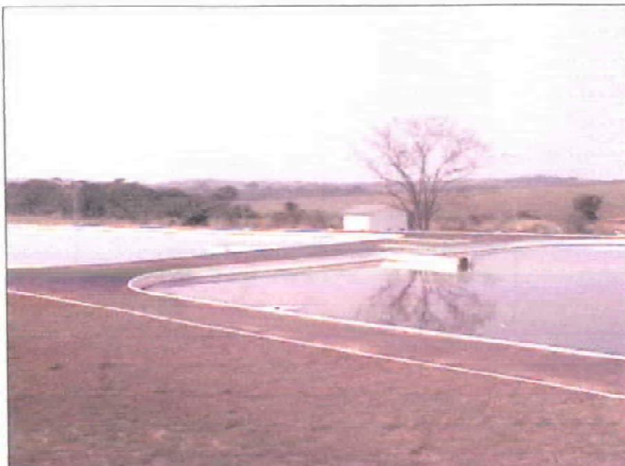
Foto 37 - ETE Santa Elisa, lagoa de sedimentação
