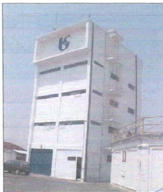
Foto 11 - Reservatório elevado 01 (T01) - ETA - 300 m 3 - Sede
