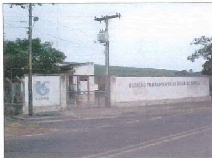
Foto 26 - Área da captação, tratamento e Reservação - Igarai
