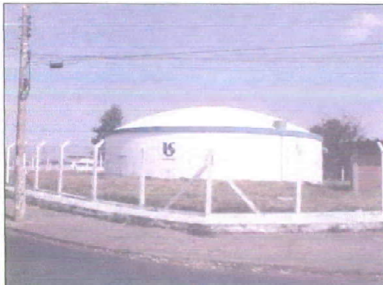
Foto 14 - Reservatório apoiado 01 (RA01) - Cohab - 1.000 m 3 - Sede
