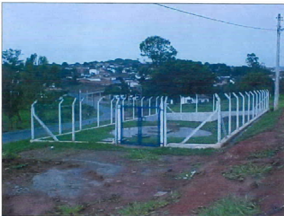
Foto 40 - Estação de tratamento de esgoto - Igarai
