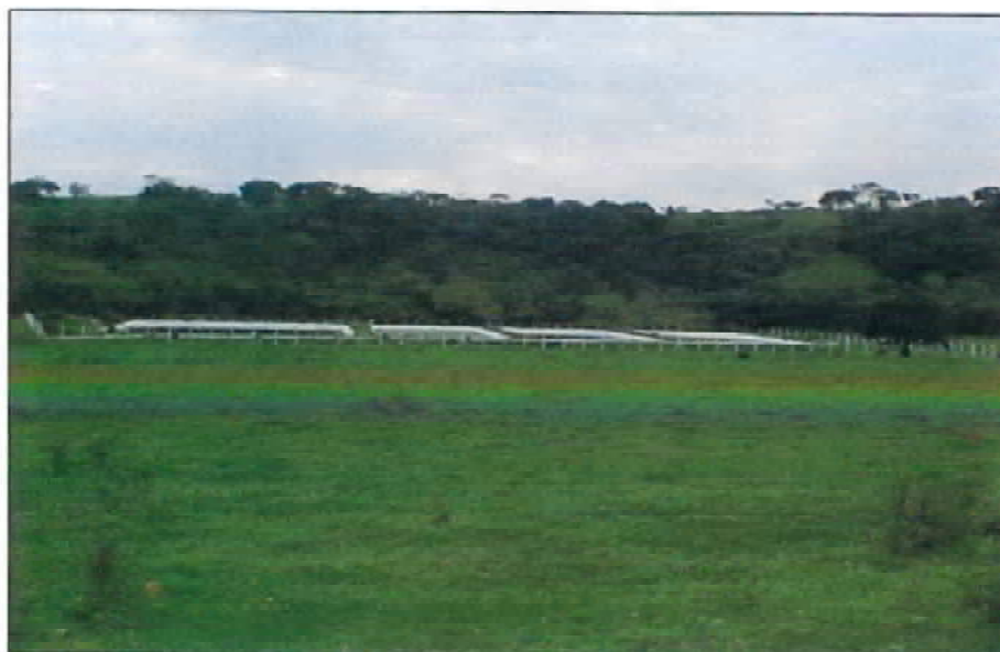
Foto 38 - Estação de tratamento de esgoto - Vista geral
