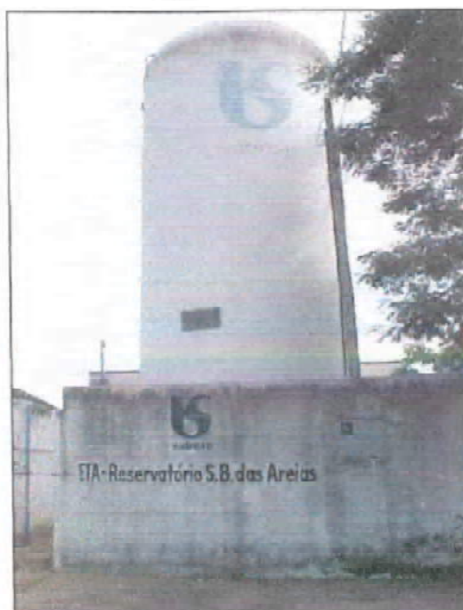
Foto 25 - Reservatório apoiado RA01- São Benedito das Areias
