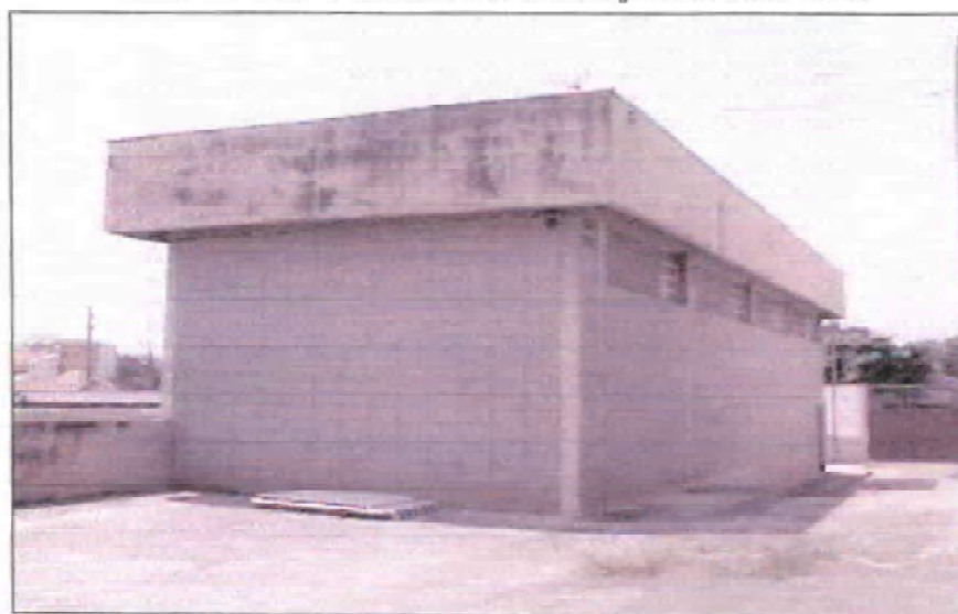
Foto 17 - Vista externa da casa de bombas junto ao RS01 - Sede
