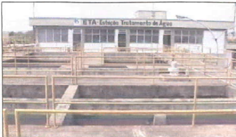
Foto 9 - ETA 01 - Vista do canal de chegada da água bruta
