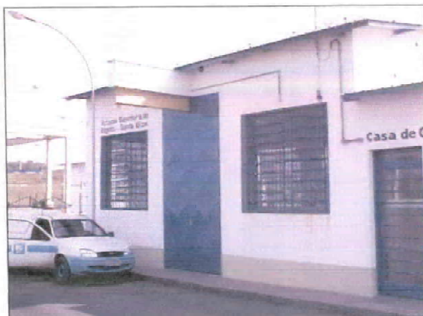
Foto 34 - Estação elevatória Santa Elisa
