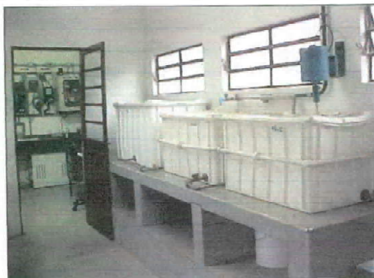
Foto 30 - Controle do tratamento e reservatórios de produtos químicos - Igarai
