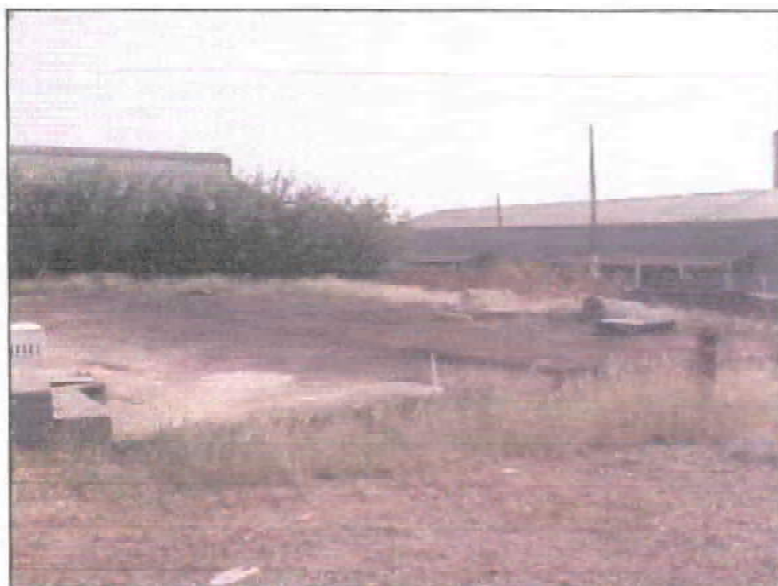
Foto 15 - Reservatório enterrado 01 (RE01) - Sete Casas - 1.000 m 3 - Sede
