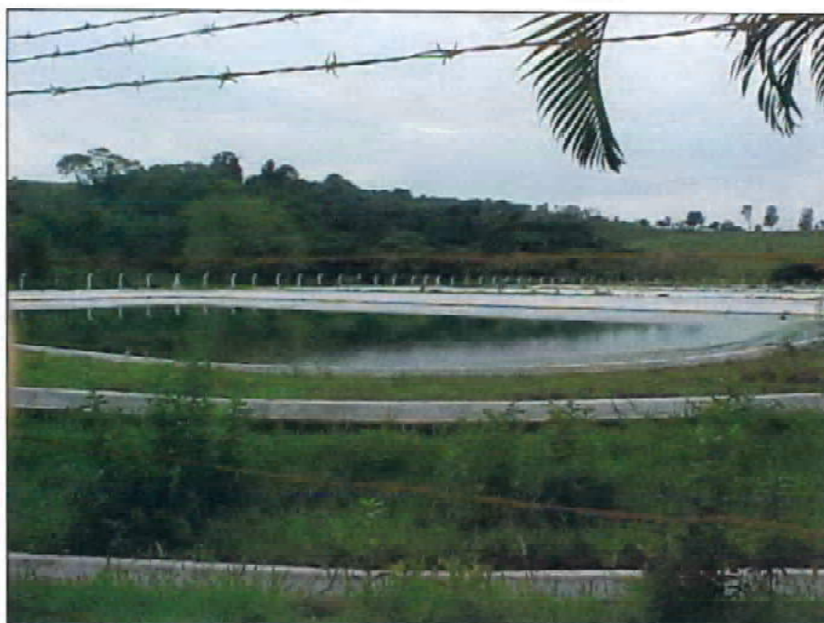
Foto 39 - Estação de tratamento de esgoto
