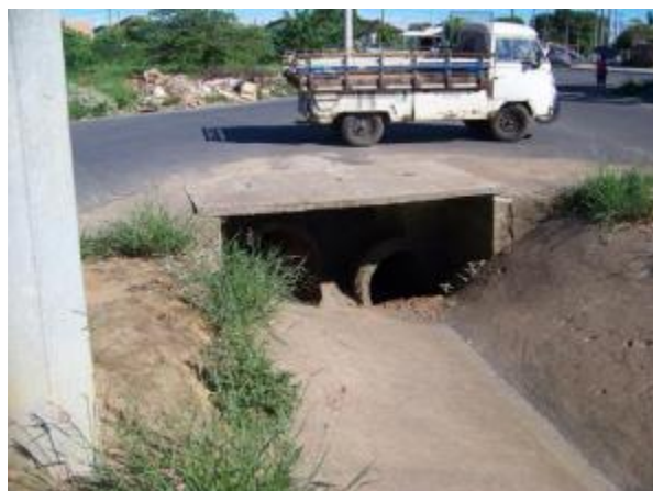
Foto 4.31 - Bueiro duplo de 1,00 m de diâmetro, que esgota a valeta de drenagem no canteiro central da Al. Nazareth Maria Biazotto (Fonte: Plano de Drenagem, 2011).
