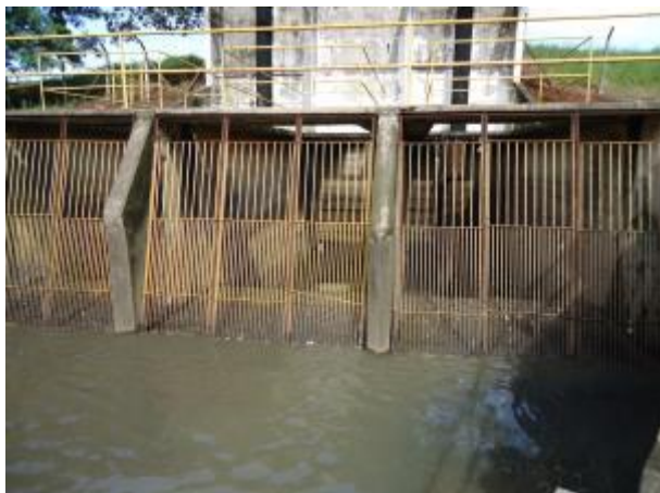
Foto 4.15 – Gradeamento da EEE Final.
