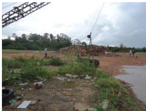
Foto 4.26 – Aterro de Inertes – resíduos de construção civil
