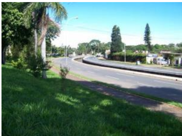
Foto 4.37 - Córrego Cantagalo. (Fonte: Plano de Drenagem, 2011)
