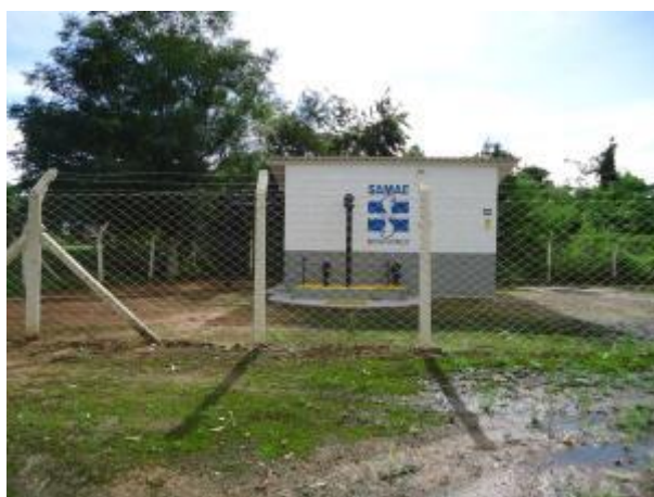
Foto 4.14 – EEE Cidade Nova Mogi Guaçu
