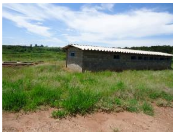
Foto 4.20 – ETE Ipê – prédio construído
