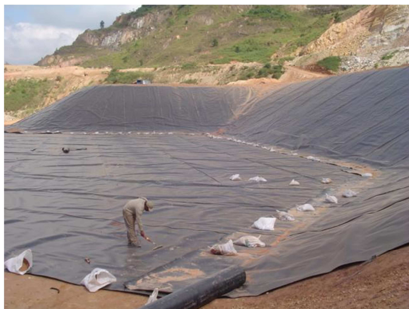
Figura 20 Impermeabilização de fundo CDR - (Soares, 2010)
