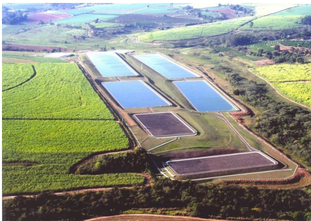
Foto 4.3 – ETE Córrego Rico
