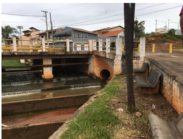
Foto 3.11 – Galeria de Águas Pluviais Lançando no Canal com Dissipadores de Energia
