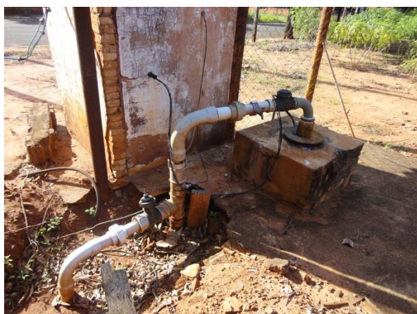
Foto 3.3 – Identificação do Poço: P02
