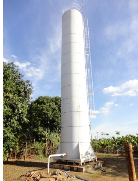
Foto 3.12 – Vista do reservatório RAP-04
