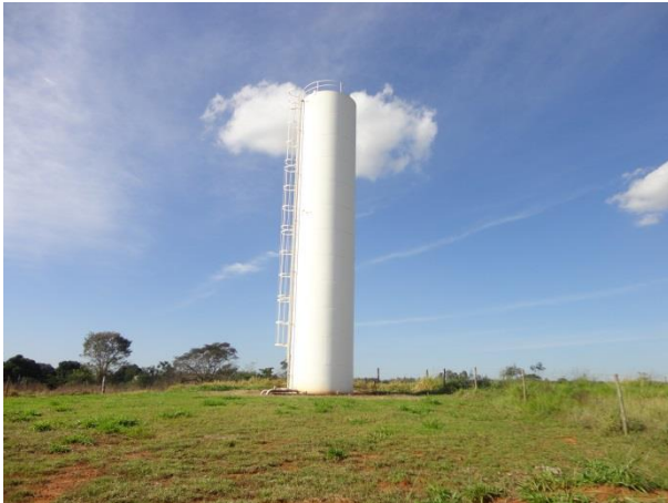
Foto 3.11 – Vista do reservatório RAP-03
