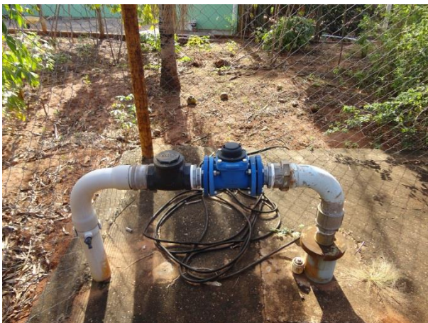
Foto 3.1 – Identificação do Poço: P01
