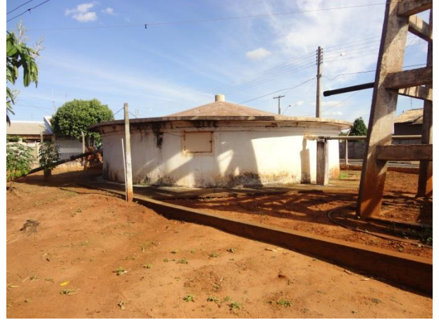
Foto 3.10 – Vista do reservatório RSE-02
