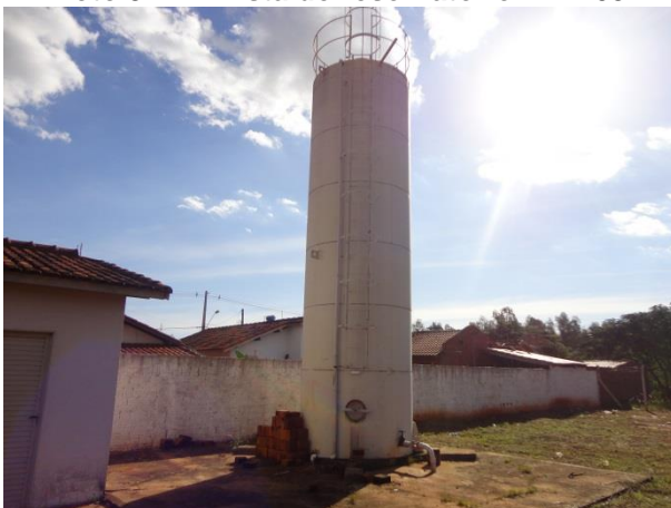
Foto 3.13 – Vista do reservatório RAP-05
