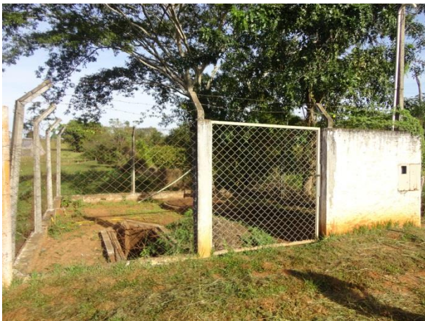
Foto 3.14 - Vista da área da EEE1
