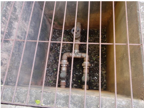
Foto 3.16 - Vista da área da EEE1
