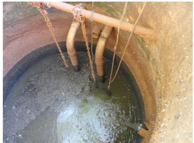
Foto 3.15 - Vista da área da EEE1
