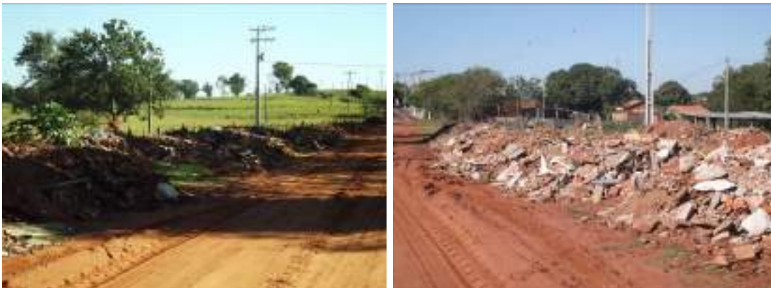
Fotos 16 e 17 – Local inadequado de disposição de RCC a beira da Estrada Municipal MCL - 040
