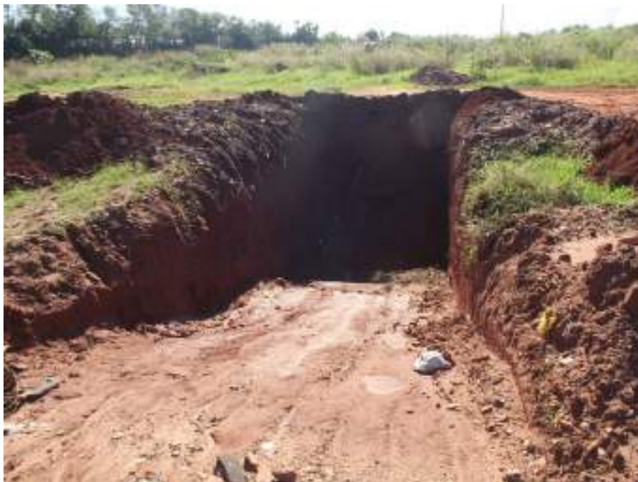
Foto 02 – Sistema de Abertura de Valas
