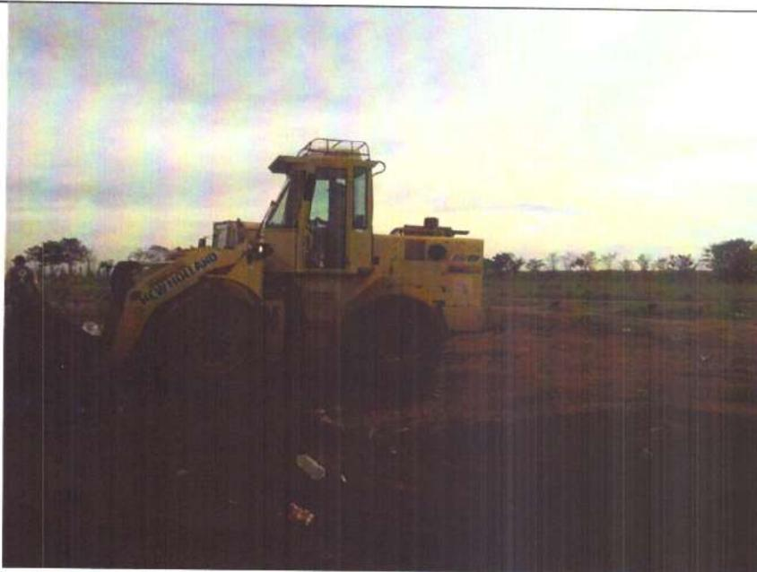
Máquina realizando serviço de recobrimento do rejeito no Aterro Municipal
