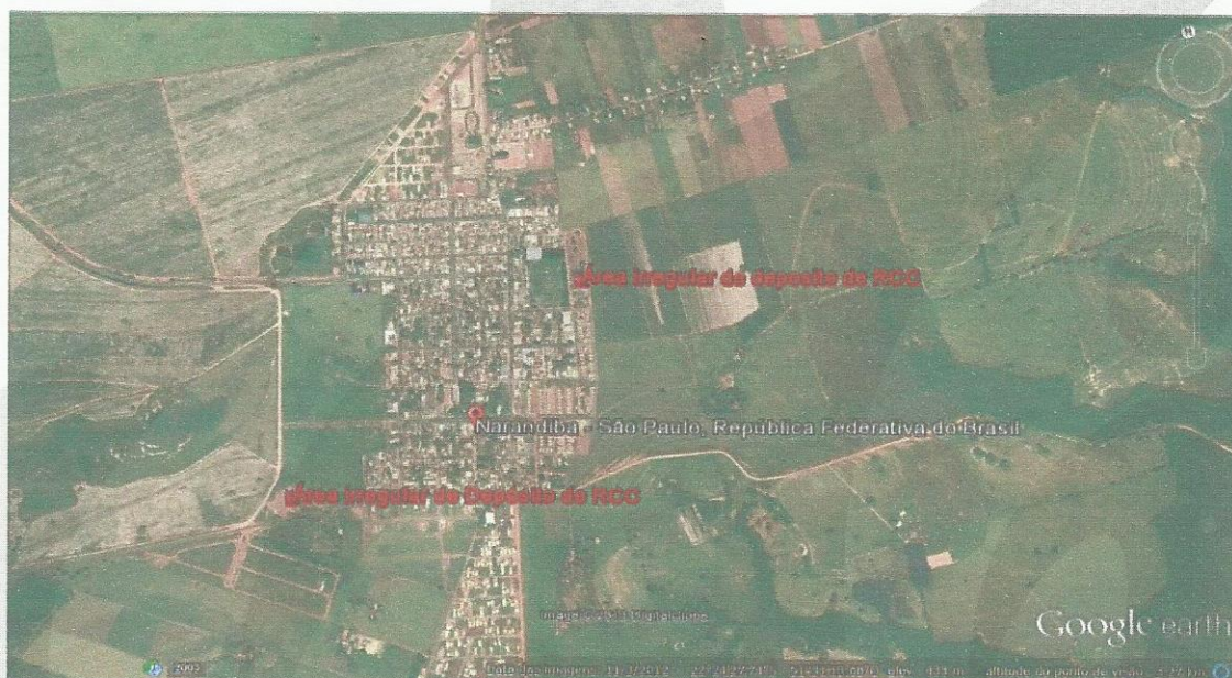
Foto 03 -Área aonde eram depositado de forma irregular os RCC
