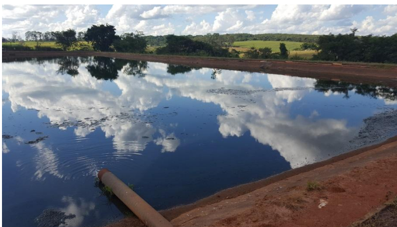
Foto 3.67 – Vista geral da lagoa facultativa
