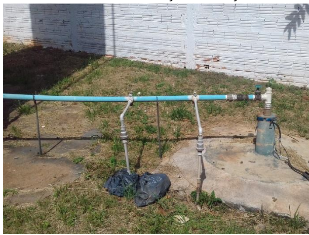
Foto 3.19 - Identificação do Poço: P06
