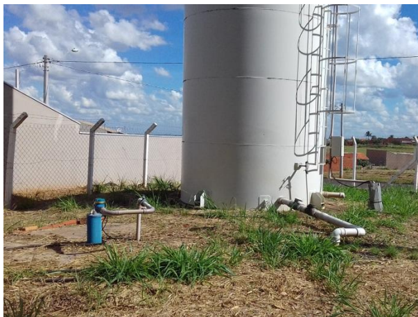
Foto 3.44 – Reservatório Jardim Nevens
