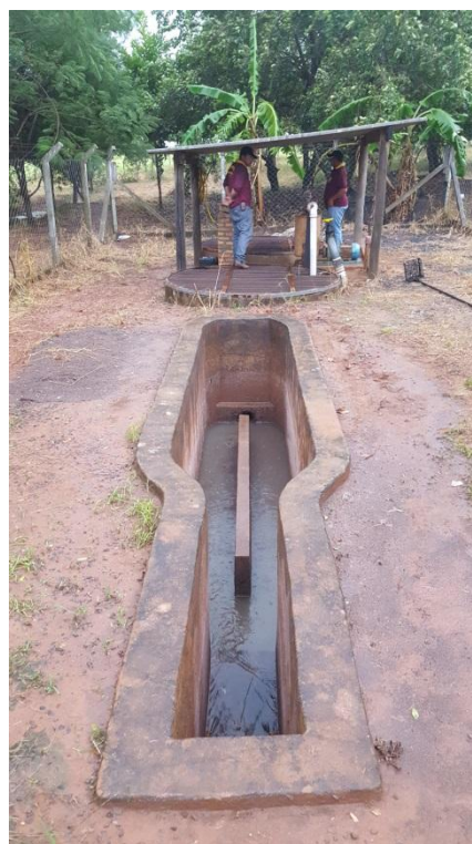
Foto 3.60 – Vista geral das unidades EEEB Quinta dos Ipês
