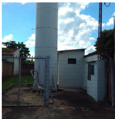
Foto 3.46 – Reservatório Cohab 1 final
