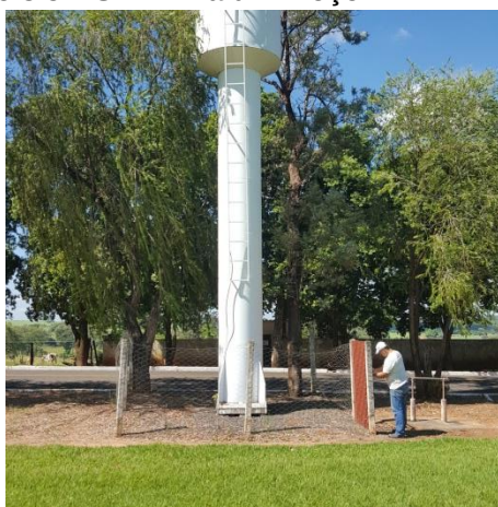
Foto 3.7 – SAA Miraluz – Reservatório
