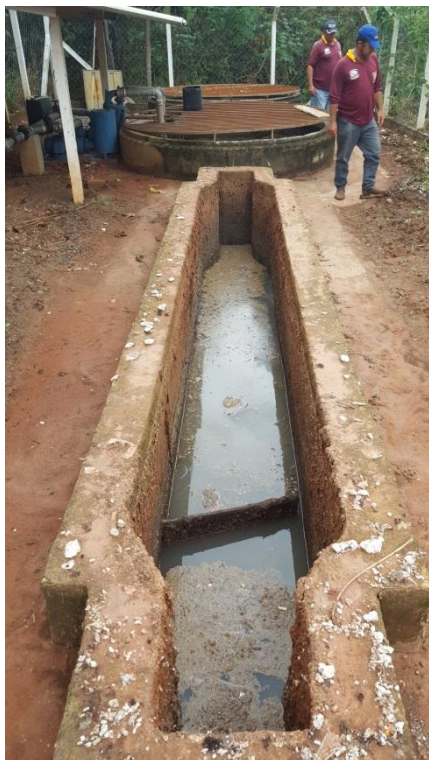
Foto 3.53 – Vista geral das unidades EEEB Jardim Nevense
