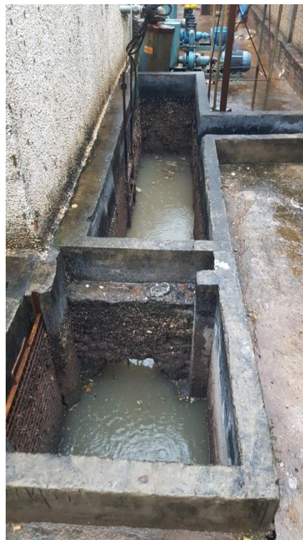
Foto 3.58 – Vista geral das unidades EEEB Central
