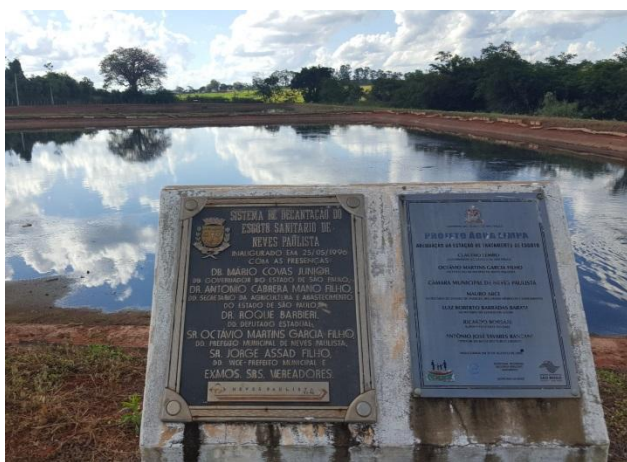
Foto 3.63 – Vista geral da ETE
