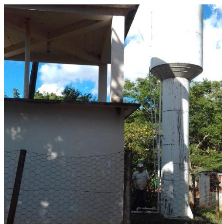
Foto 3.4 – SAA Barra Dourada - Reservatório
