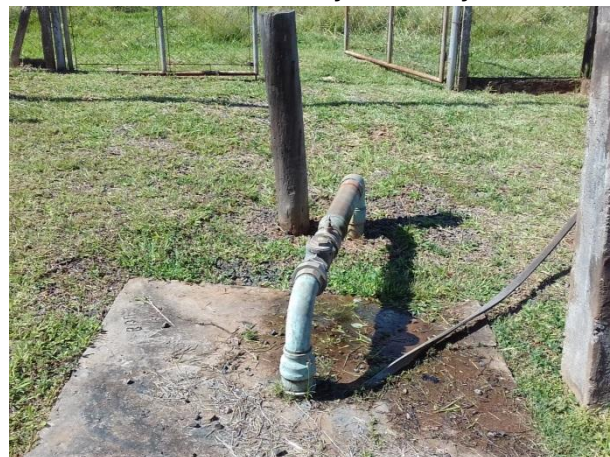
Foto 3.17 - Identificação do Poço: P04
