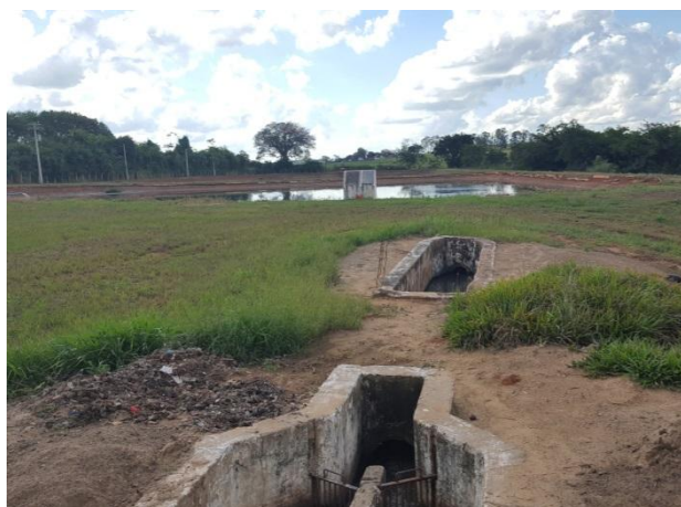
Foto 3.65 – Vista geral da ETE – Tratamento Preliminar
