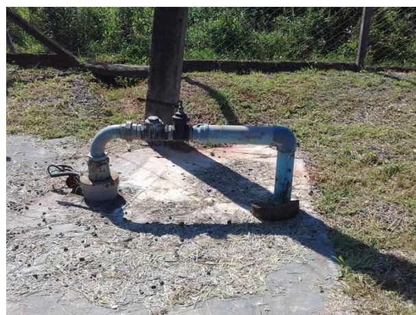
Foto 3.13 - Identificação do Poço: P01
