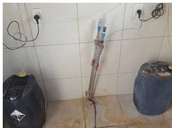
Foto 3.31 – Tratamento São José 1
