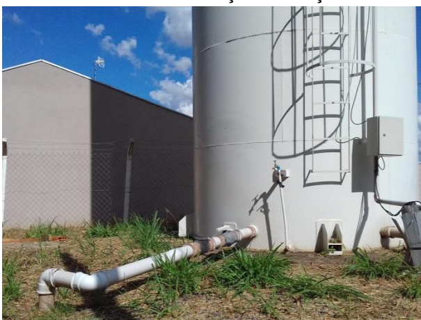
Foto 3.22 - Identificação do Poço: P11
