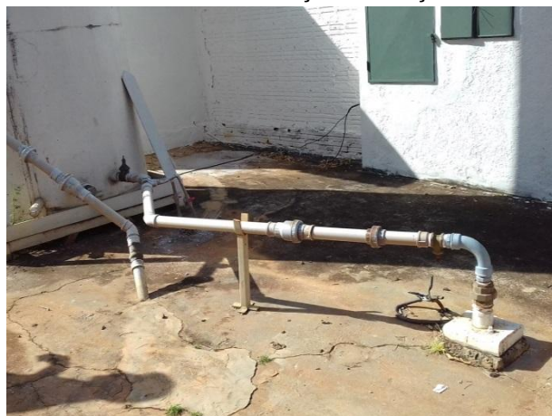
Foto 3.25 - Identificação do Poço: P14
