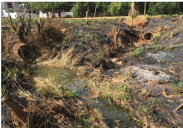
Foto 3.5 – Ponto de alagamento – chegada de 2 galerias
