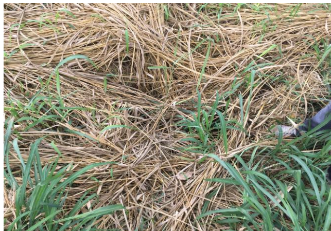
Foto 3.2- Caixa de entrada - galeria da rodovia – coberta por vegetação
