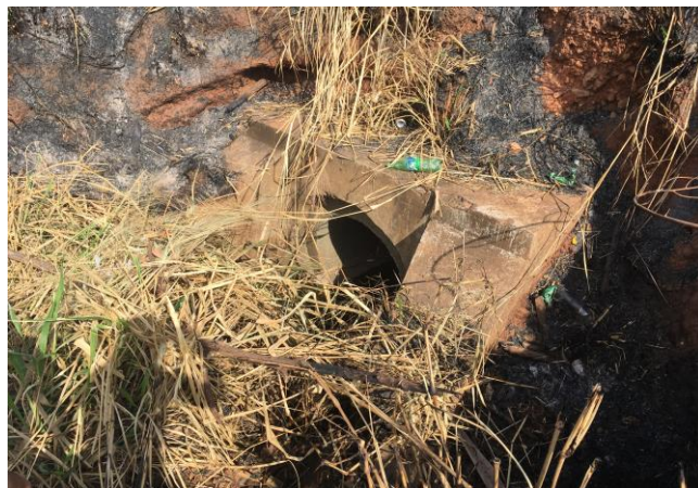
Foto 3.6 – Tubulação de saída – travessia da Rodovia SP-310
