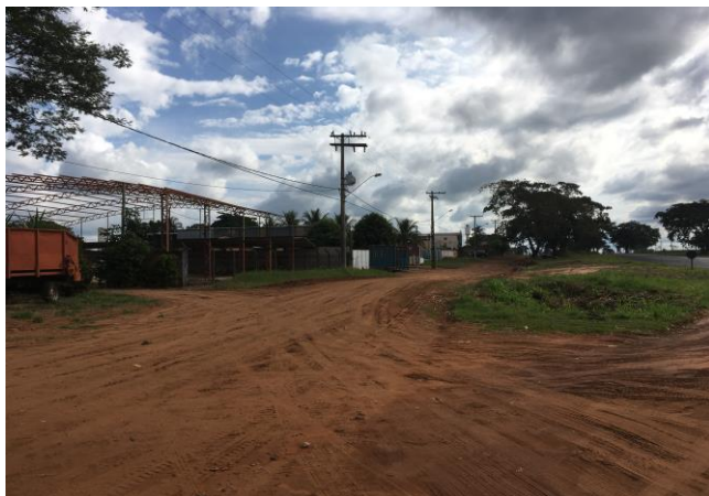
Foto 3.1 – Região de alagamento no Distrito Industrial
