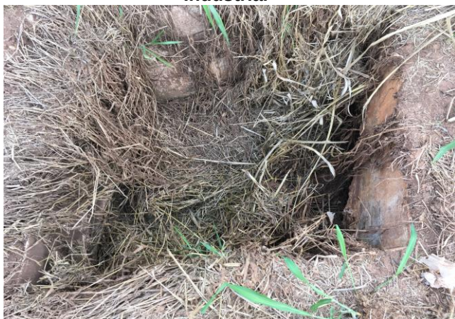
Foto 3.3 – Caixa de passagem da galeria da rodovia
