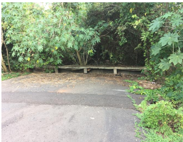
Foto 3.10 – Final das galerias do Jardim Florença
