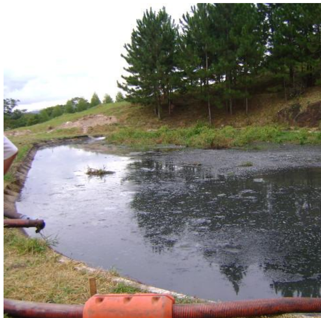
FOTO 4.12 - LAGOA ANAERÓBIA DA ETE NOVA CAMPINA
