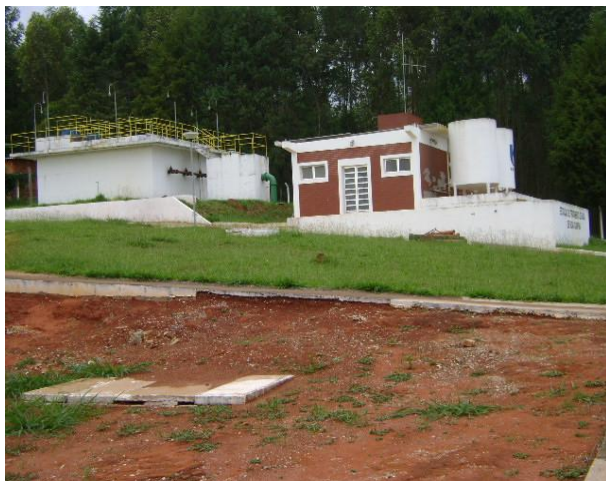
FOTO 4.4 - VISTA DA ETA NOVA CAMPINA
