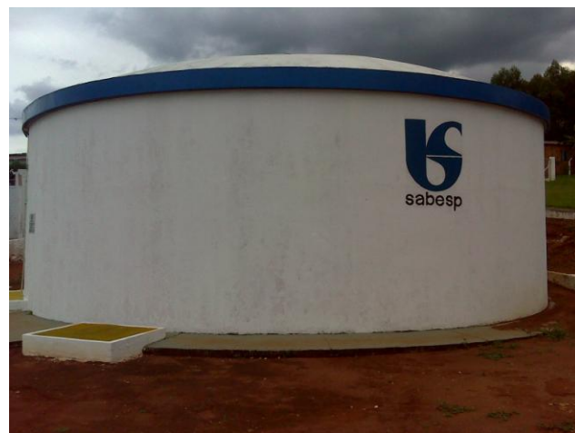
FOTO 4.8 – DETALHE DO RESERVATÓRIO R01 - LOCALIZADO NA ETA NOVA CAMPINA
