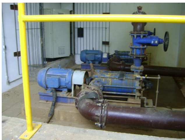
FOTO 4.2 – DETALHE DA EEAB CAPTAÇÃO 2
