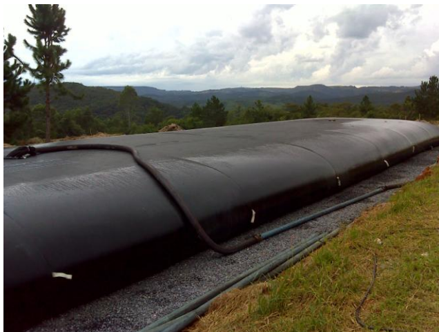
FOTO 4.13 – BAG DE ARMAZENAMENTO DO LODO NA ETA DE NOVA CAMPINA
