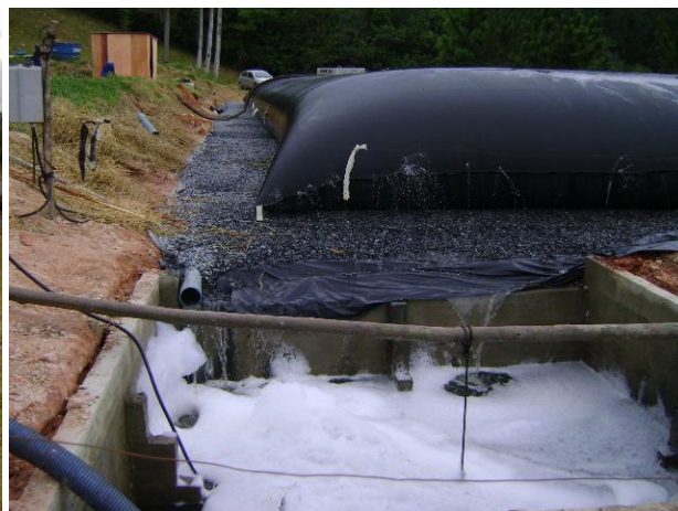
FOTO 4.14 – BAG DE ARMAZENAMENTO DO LODO NA ETA DE NOVA CAMPINA
