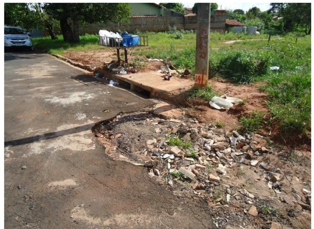
Foto 3.27 – Estrutura de microdrenagem que contribui para a erosão e problemas nas vias por conta da microdrenagem
