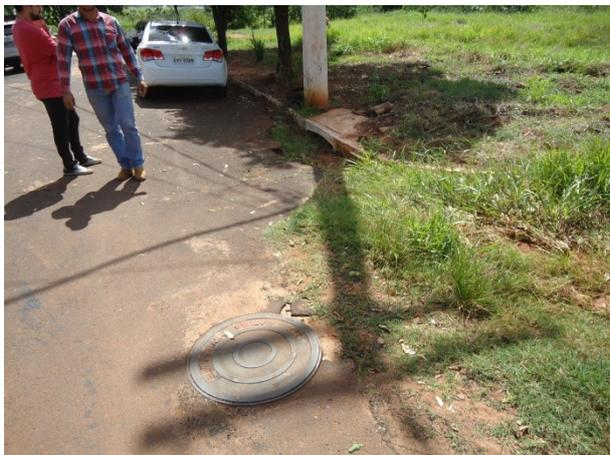
Foto 3.19 – Estrutura de microdrenagem que deságua na erosão
