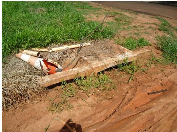
Foto 3.18 – Estrutura de microdrenagem que deságua na erosão
