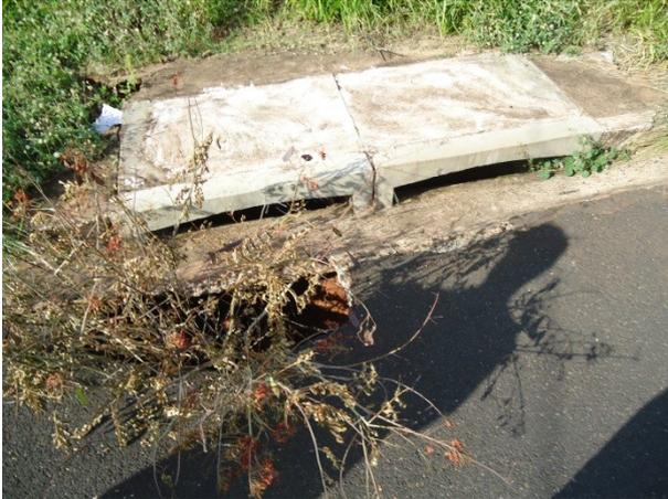
Foto 3.34 - Problemas na via por conta de sistema de drenagem ineficiente na Rua Manoel R. de Sá
