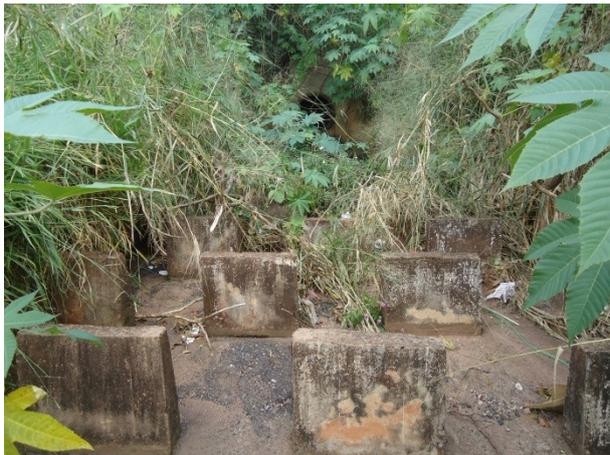
Foto 3.17 – Estrutura de dissipação
