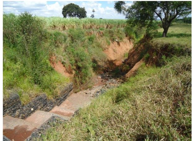
Foto 3.2 - Início da erosão/escada hidráulica
