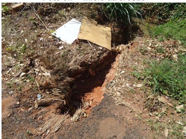
Foto 3.9 – Problemas na via devido à microdrenagem ineficiente
