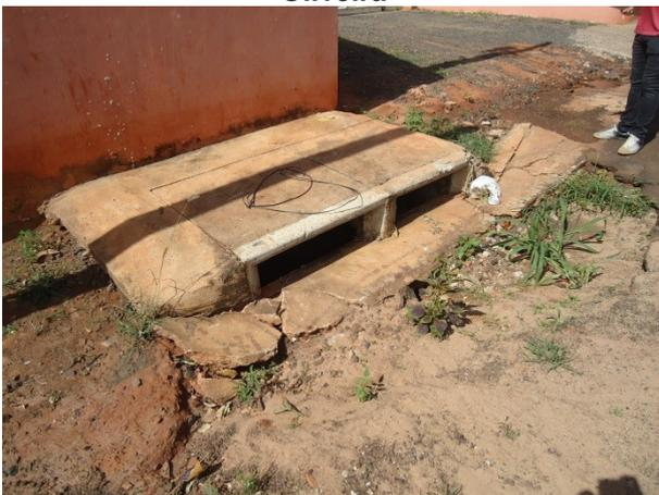
Foto 3.26 – Estrutura de microdrenagem que contribui para a erosão
