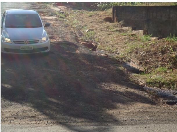
Foto 3.30 - Problemas na via por conta da falta de microdrenagem
