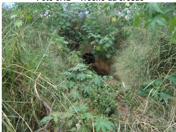
Foto 3.14 – Galeria de água pluvial que deságua na erosão
