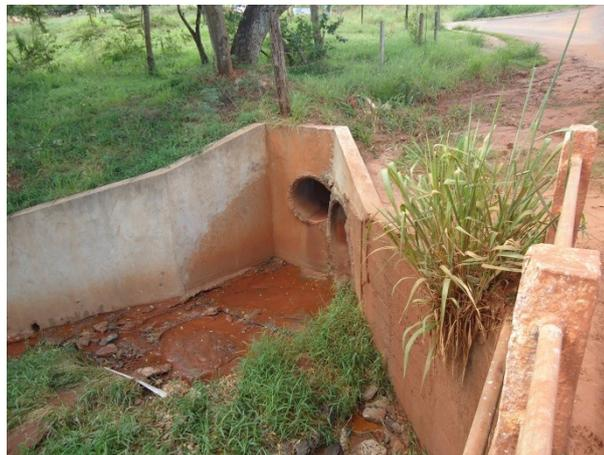
Foto 3.36 - Chegada da rede de águas pluviais dos novos loteamentos
