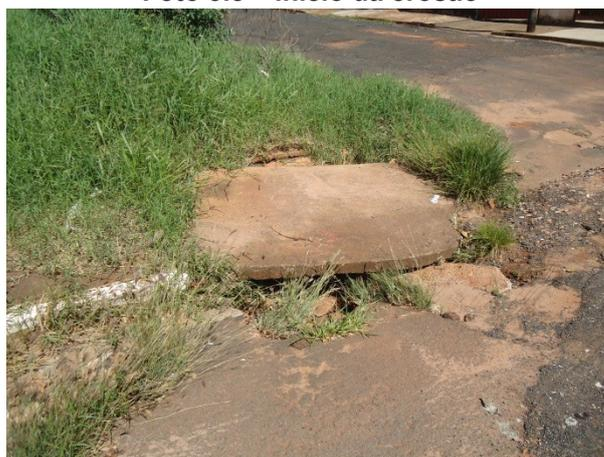
Foto 3.10 – Problemas na via devido à microdrenagem ineficiente
