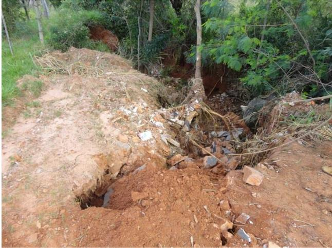
Foto 3.14 – Erosão provocada pelo lançamento de GAP
