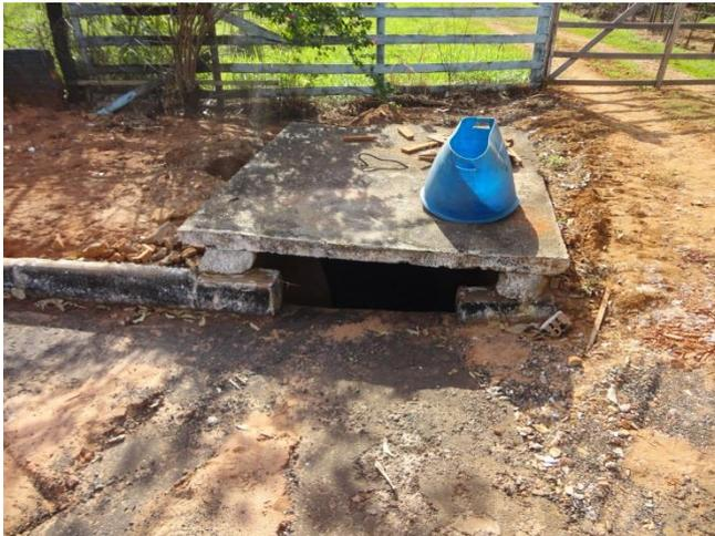
**Foto 3.6 – Microdrenagem insuficiente
