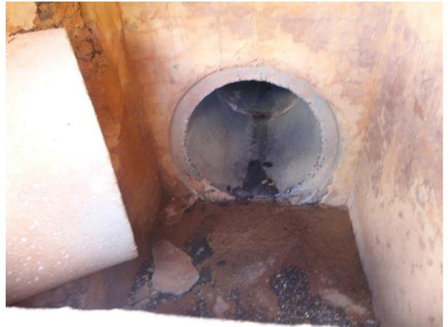
**Foto 3.7 – Microdrenagem insuficiente**
