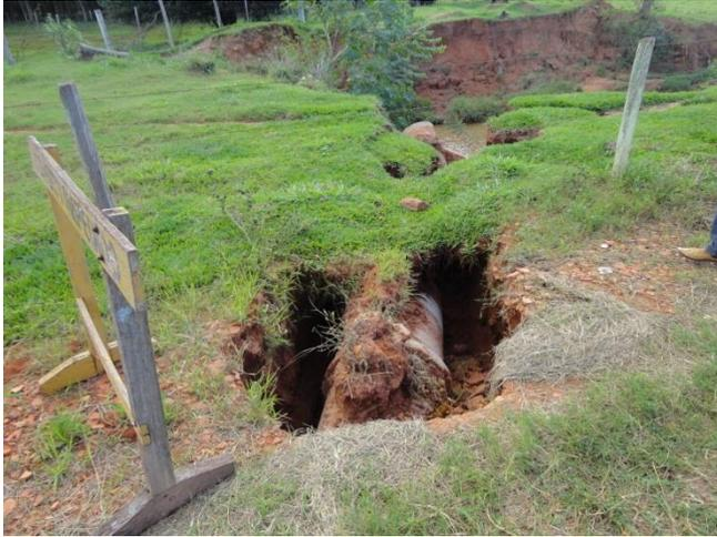
Foto 3.12 – Erosão provocada pelo lançamento de GAP
