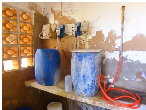
Foto 3.6 – Local de armazenamento das soluções
