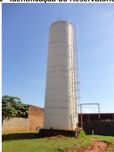
Foto 3.12 - Identificação do Reservatório: REL-03
