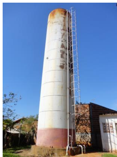
Foto 3.11 - Identificação do Reservatório: REL-02
