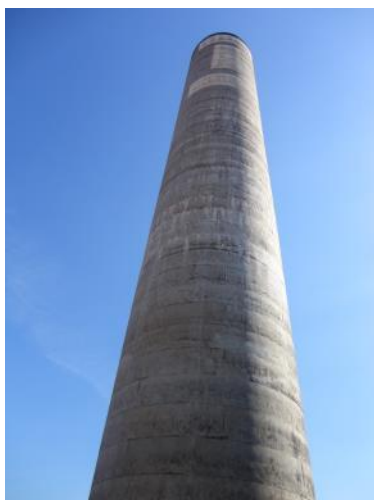
Foto 3.10 - Identificação do Reservatório: REL-01
