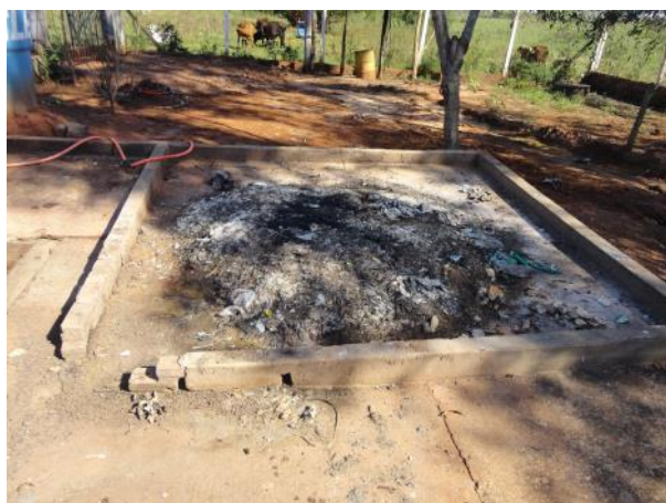
Foto 3.16 – Local de secagem de Lodo EEE1
