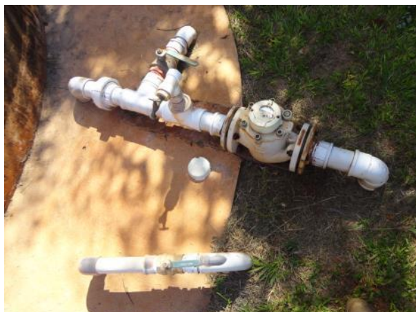
Foto 3.1 - Identificação do Poço: P01
