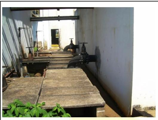
Foto 2.28 – Registro de descarga de lodo dos decantadores
