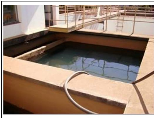
Foto 2.18 – Filtro em processo de operação
