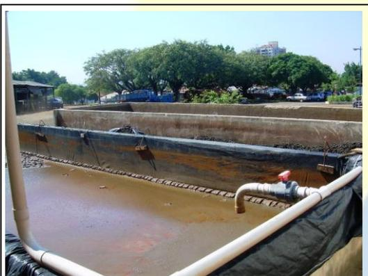
Foto 2.30 – Bateria de 3 leitos de localizados na parte lateral da ETA
