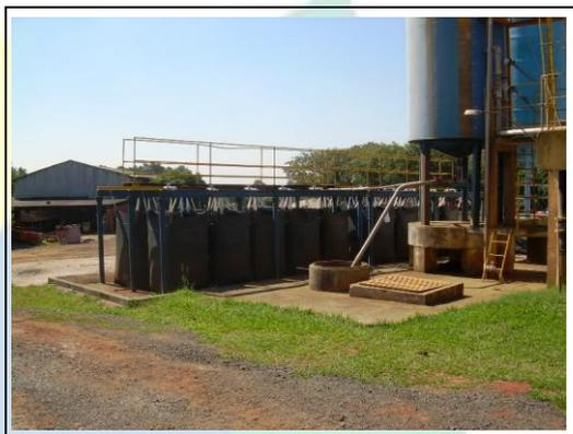
Foto 2.31 – Sistema de “bags” utilizados na desidratação do lodo
