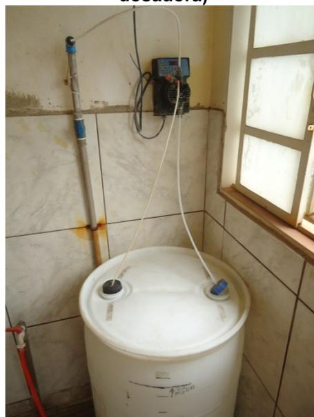
Foto 3.10 - Tratamento do Poço 5 (bomba dosadora)
