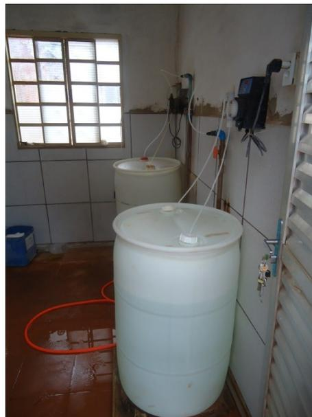
Foto 3.8 - Tratamento do Poço 4 (bomba dosadora)
