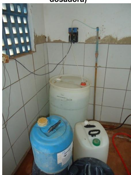
Foto 3.6 - Tratamento do Poço 3 (bomba dosadora)
