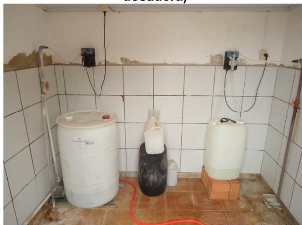
Foto 3.4 - Tratamento do Poço 2 (bomba dosadora)
