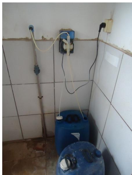
Foto 3.2 - Tratamento do Poço 1 (bomba dosadora)
