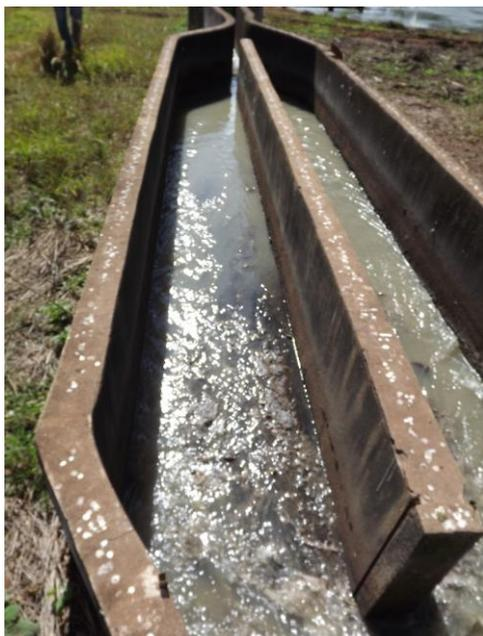
Foto 3.37 – Detalhe da caixa de areia (2 módulos) em operação
