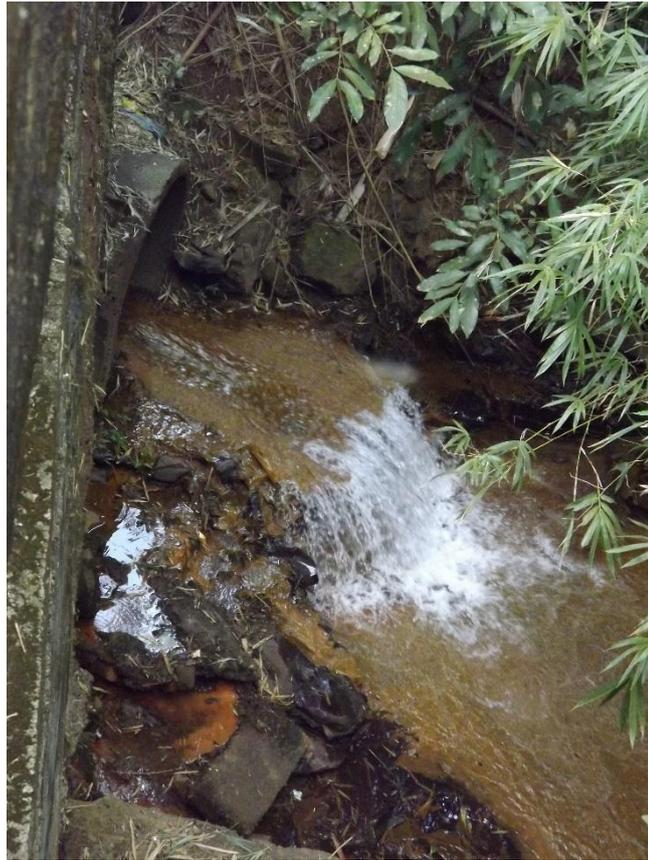
Foto 3.48 – Detalhe do lançamento da galeria de águas pluviais no Córrego Espírito Santo.
