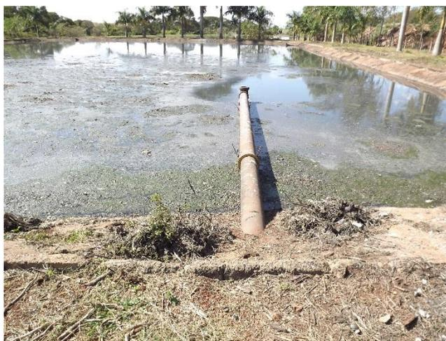
Foto 3.40 – Detalhe de uma das entradas da lagoa anaeróbia.
