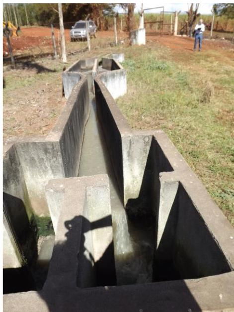
Foto 3.38 – Detalhe de caixa de passagem e Calha Parshall ao fundo.
