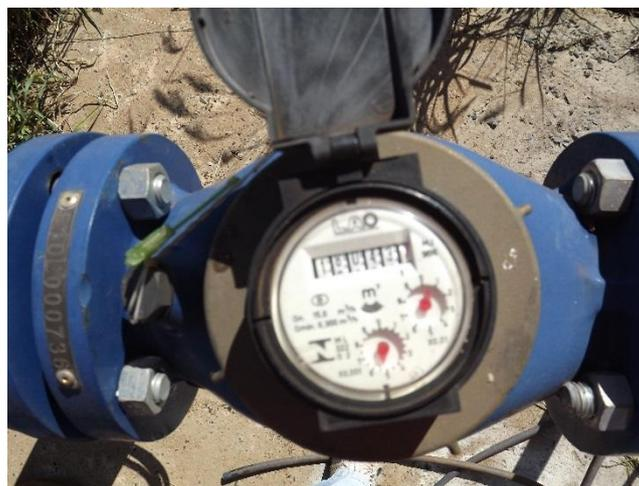
Foto 3.16 – Detalhe de macromedidor instalado no Poço Griff.
