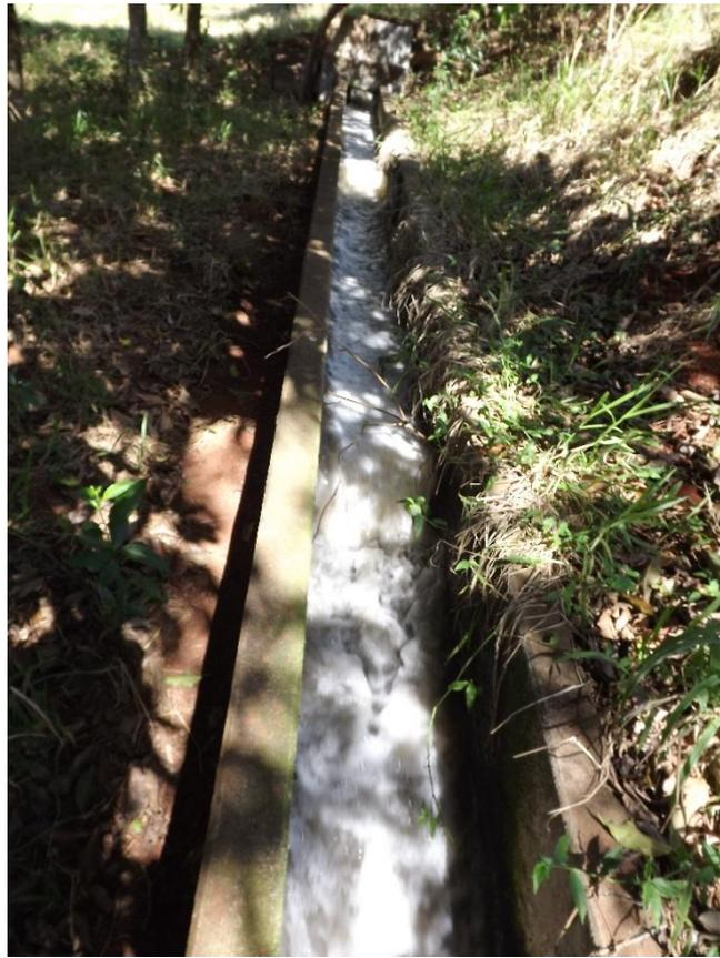
Foto 3.43 – Detalhe da escada hidráulica na saída da ETE Nuporanga.
