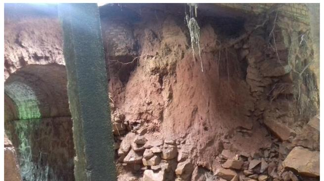
Foto 3.50 – Detalhe de perda de solo na galeria de águas pluviais.
