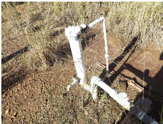
Foto 3.2– Detalhe da desinfecção por pastilhas de Cloro e Flúor no Poço Vila Diogo.
