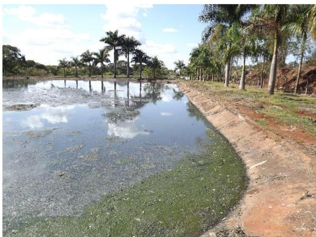
Foto 3.39 – Detalhe da lagoa anaeróbia com presença de sobrenadante.
