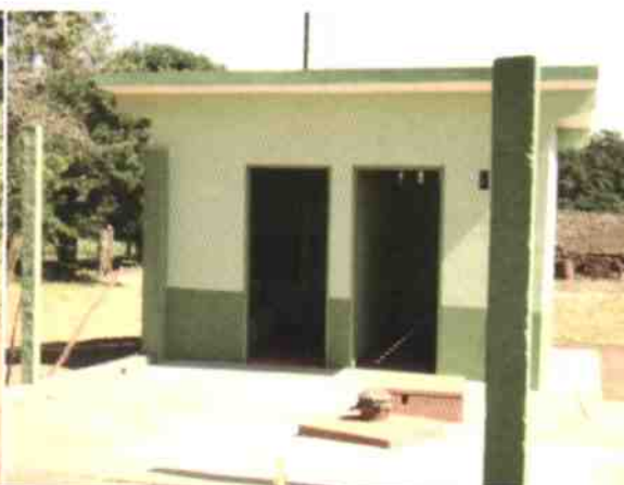
POÇO ÁGUA LIMPA
