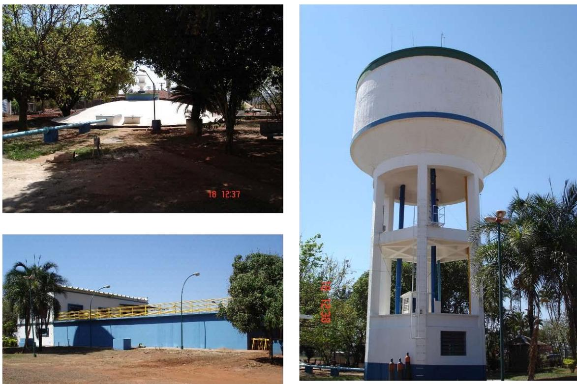
Figura 16 - Do canto superior esq., no sentido horário – um dos dois reservatórios semi-enterrados da ETA ( 2 x 250 m<sup>3</sup>); reservatório elevado; vista externa da ETA.
