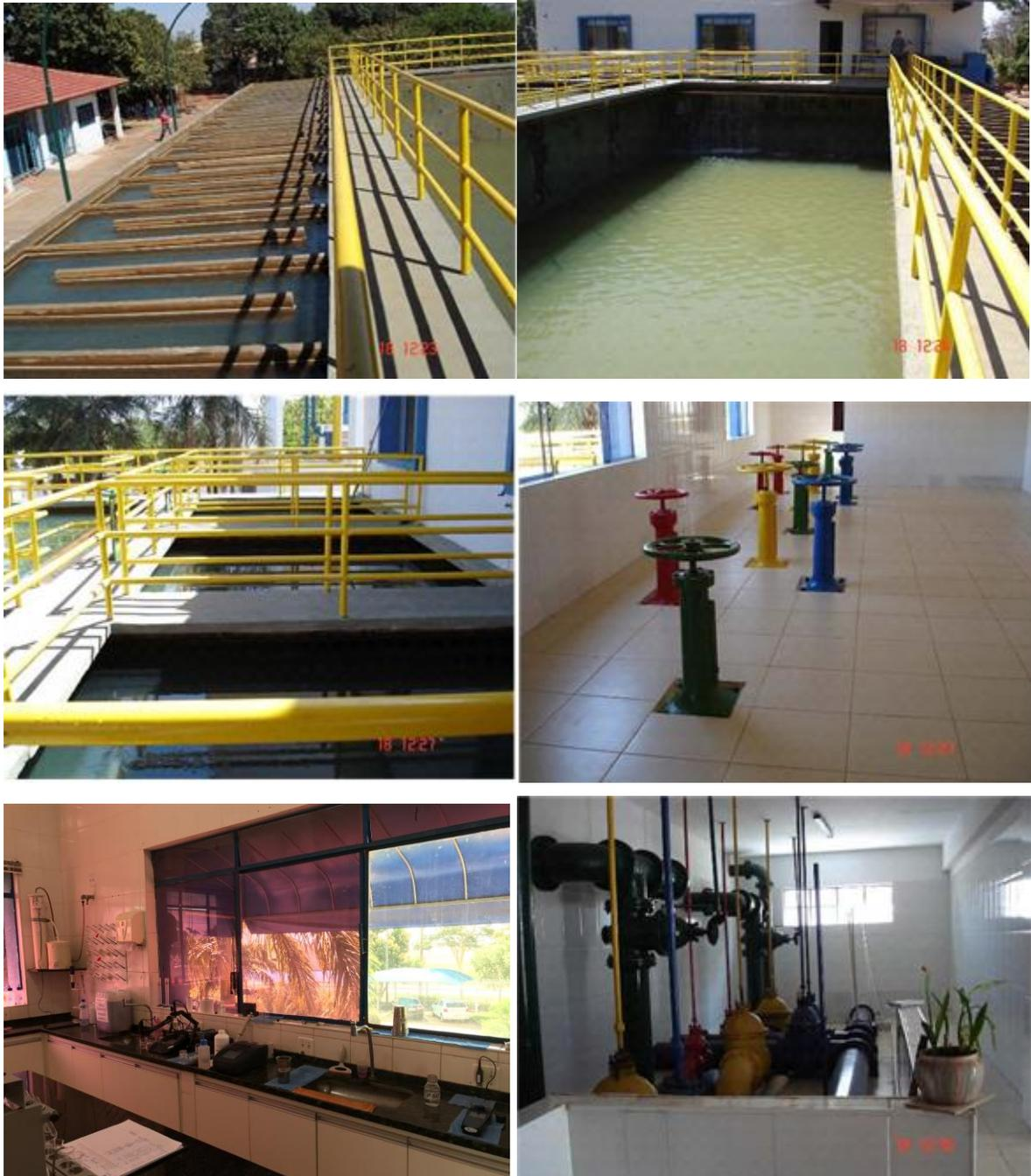
Figura 15 - Do canto superior esq., no sentido horário – chicanas; decantador; sala de controle (manual); saída dos filtros; laboratório; filtros.
