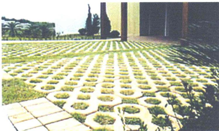
**Figura 19.** Exemplo de aplicação de pavimento permeável
