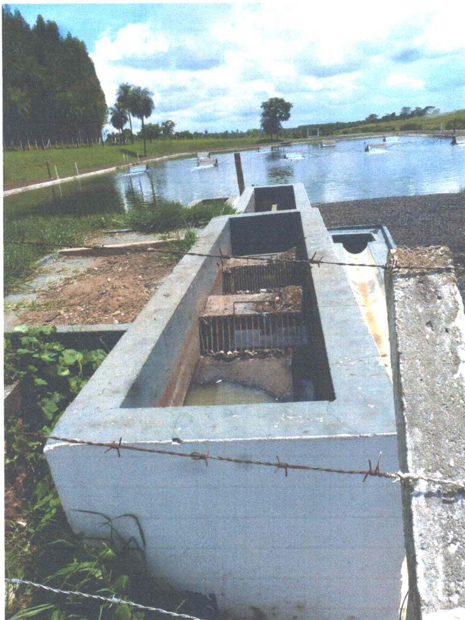
Figura 12. Gradeamento e Caixa de areia.
