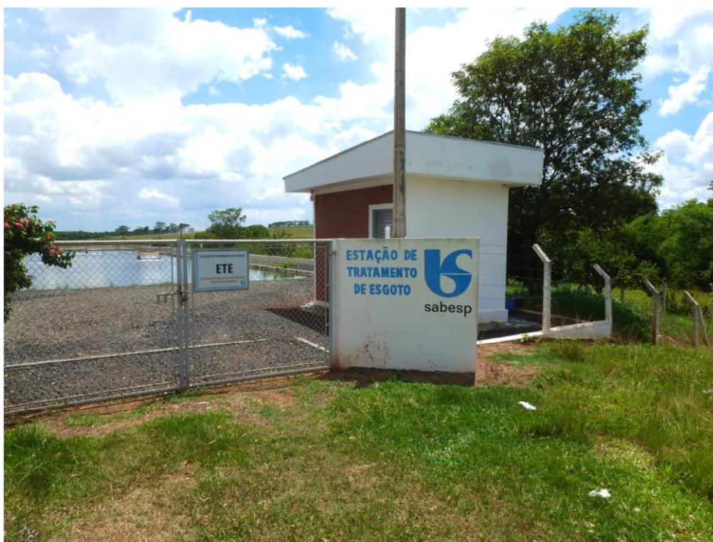
Figura 17. Vista da entrada da ETE de Onda Verde.
