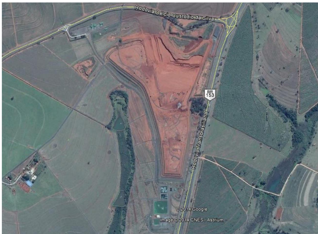
Figura 4. Aterro sanitário da empresa Constroeste Construtora e Participações Ltda.
